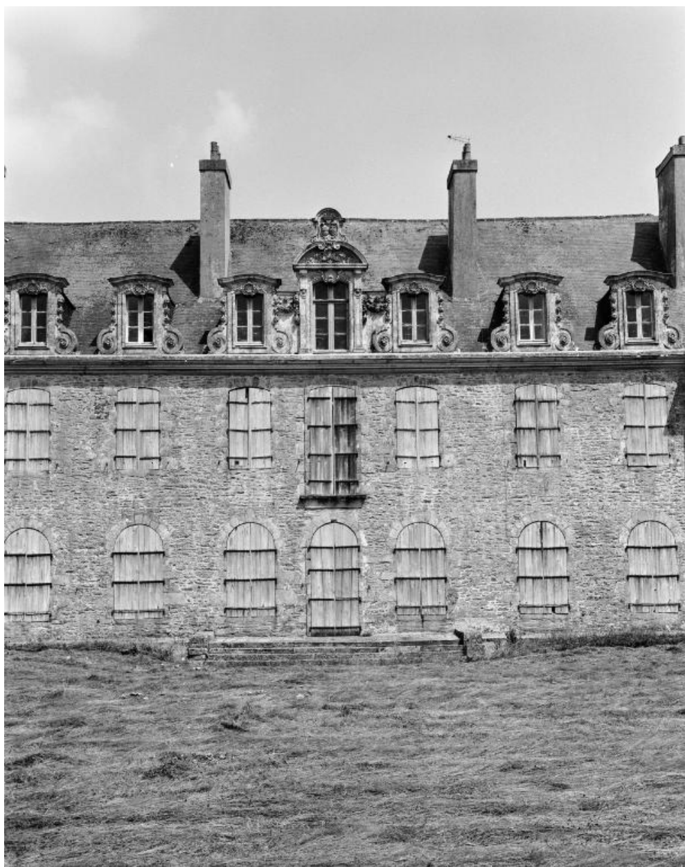
Château, logis, élévation ouest : partie centrale.
