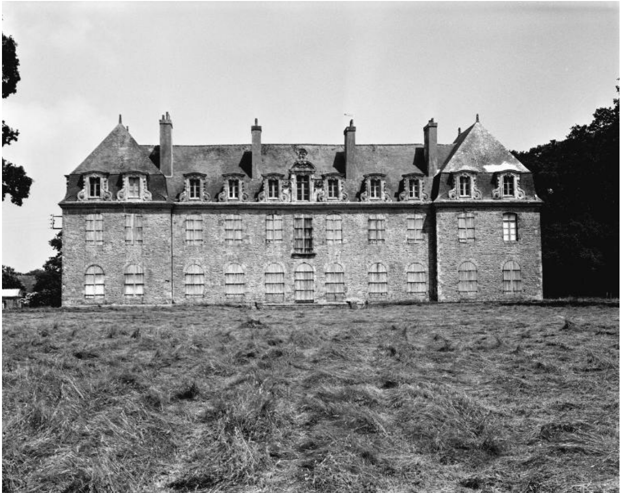
Château, logis, élévation ouest.
