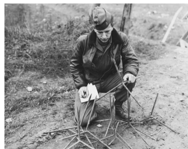
Vue d'un soldat américain examinant des chausse-trappes (United States Army Signal Corps, septembre 1944). Le soldat se situe juste au Sud du fossé anti-char, devant le poteau en bois Phot. Anonyme IVR53_20232905458NUCA
