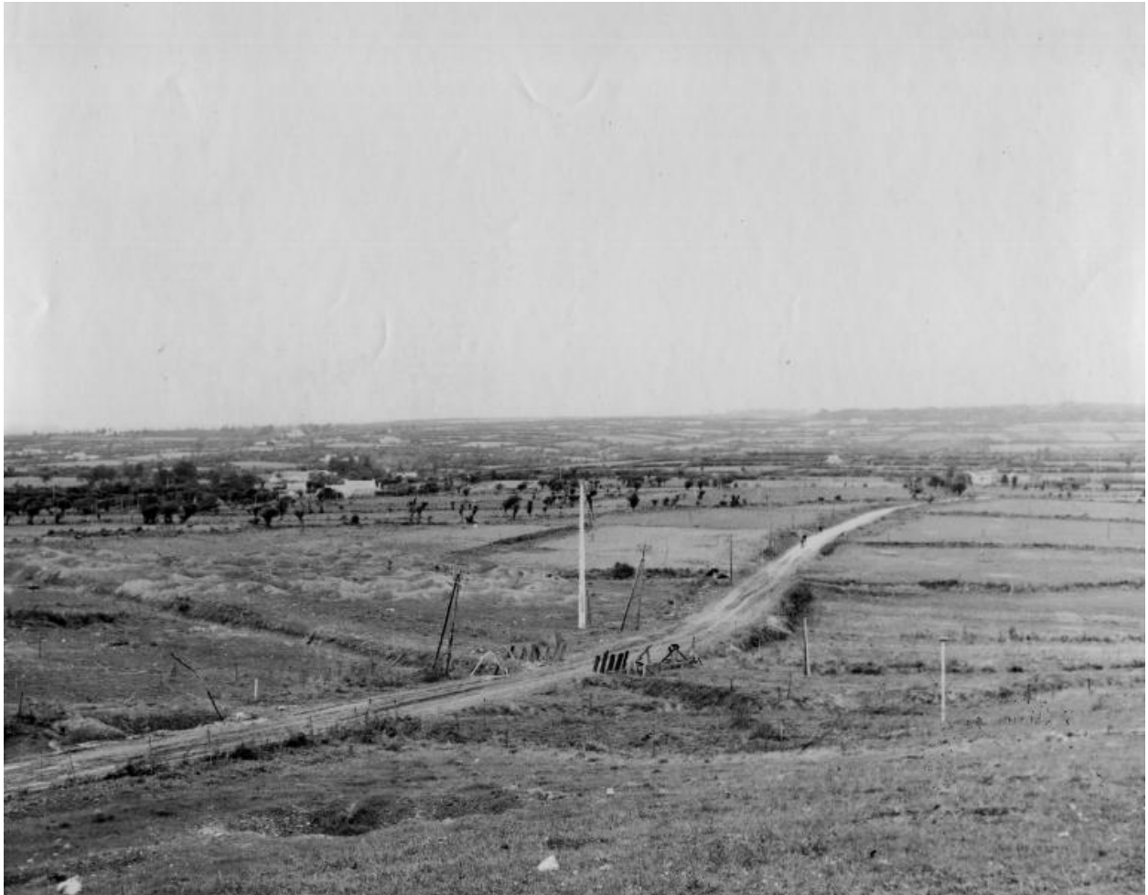
Vue de la route, du barrage et du fossé anti-char depuis le bunker - casemate 667 situé à l'Est de la route (United States Army Signal Corps, septembre 1944)
