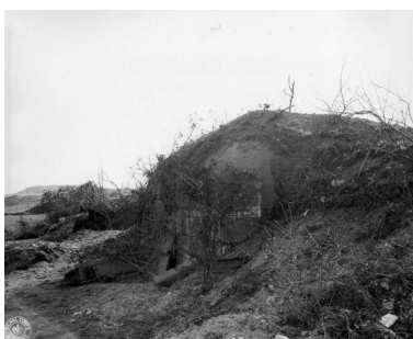
Vue de profil du bunker - casemate, variante du type 667 (United States Army Signal Corps, septembre 1944). Cette photographie a été identifiée en 2022 par Ludovic Le Braz et Simon Roudot Phot. Anonyme IVR53_20232905461NUCA
