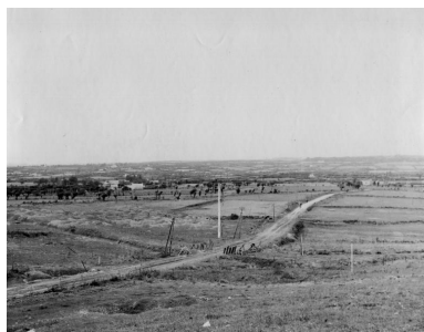
Vue de la route, du barrage et du fossé anti-char depuis le bunker - casemate 667 situé à l'Est de la route (United States Army Signal Corps, septembre 1944) Phot. Anonyme IVR53_20232905456NUCA
