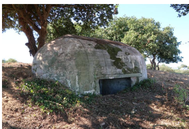
Vue du bunker - casemate de type 667 (365) pour un canon de 5 cm (B 47) situé à l'ouest de l'actuelle rue de Kerléo (état en août 2022) Phot. Guillaume Lécueillier IVR53_20222905853NUCA
