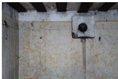
Vue intérieure du bunker - abri pour 6 soldats de type VF 1a de Menguen, à l'ouest de l'actuelle rue de Kerléo : les murs ont conservé
