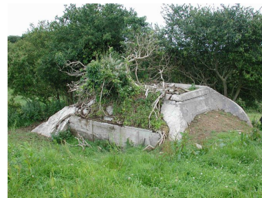
Vue du bunker - casemate de type 667 (365) pour un canon de 5 cm (B 46) situé à l'est de l'actuelle rue de Kerléo (état en 2002). La casemate a été détruite et/ou remblayée vers 2007 pour faire place à un ensemble d'habitat collectif situé rue Hundertwasser Phot. Guillaume Lécueillier IVR53_20022902932NUCA
