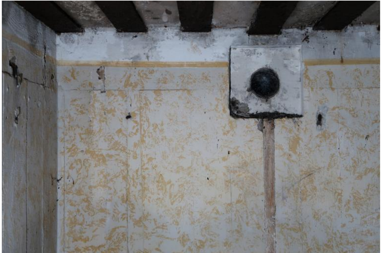
Vue intérieure du bunker - abri pour 6 soldats de type VF 1a de Menguen, à l'ouest de l'actuelle rue de Kerléo : les murs ont conservé leur peinture murale tachetée ocre jaune d'origine (état en 2021)
