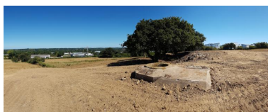
Vue de situation depuis l'ouest (août 2022, chantier en cours) Phot. Guillaume Lécueillier IVR53_20222905842NUCA
