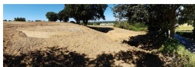
Vue de situation depuis l'est (août 2022, chantier en cours) Phot. Guillaume Lécueillier IVR53_20222905844NUCA
