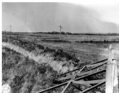
Vue de la jonction entre le fossé anti-char et la ligne continue d'obstacles constituée de barrières Cointet située au nord du fort de Keranroux et de la Butte du Polygone de la Marine (United States Army Signal Corps, septembre 1944). En arrière-plan, la route de Guilers et son barrage Phot. Archives municipales et communautaires. Brest Métropole Océane, Phot. Guillaume (retouche) Lécueillier, Autr. U.S. Army Signal Corps IVR53_20082909379NUC
