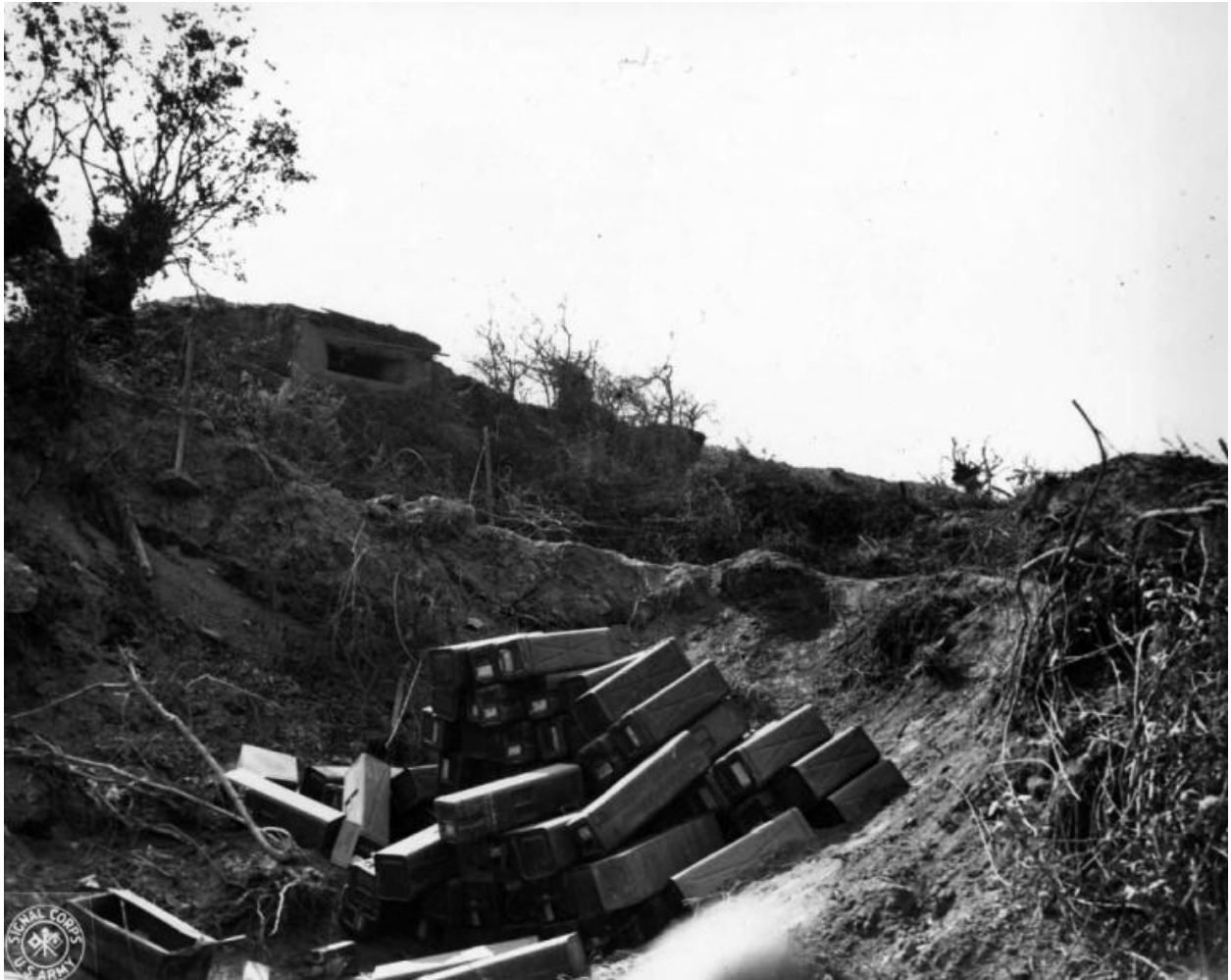
Vue du bunker - casemate surmontant le bunker de type 600 (United States Army Signal Corps, septembre 1944). Au premier plan : des caisses à munitions. Non visible : la cuve pour canon de 5 cm. Cette photographie a été identifiée par Ludovic Le Braz et Simon Roudot
