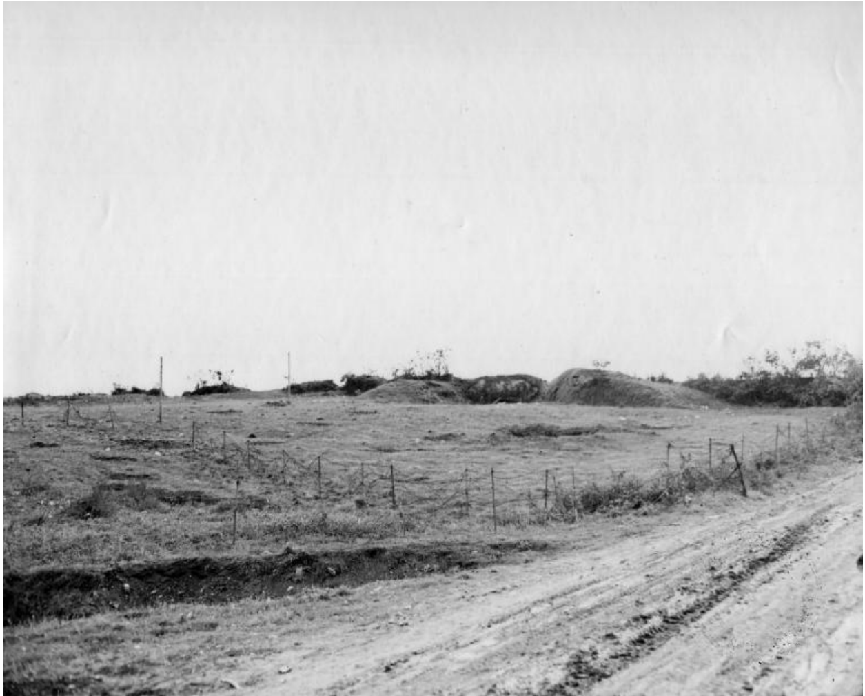
Vue générale du bunker - casemate de type 667 situé à l'Est de la route (United States Army Signal Corps, septembre 1944)
