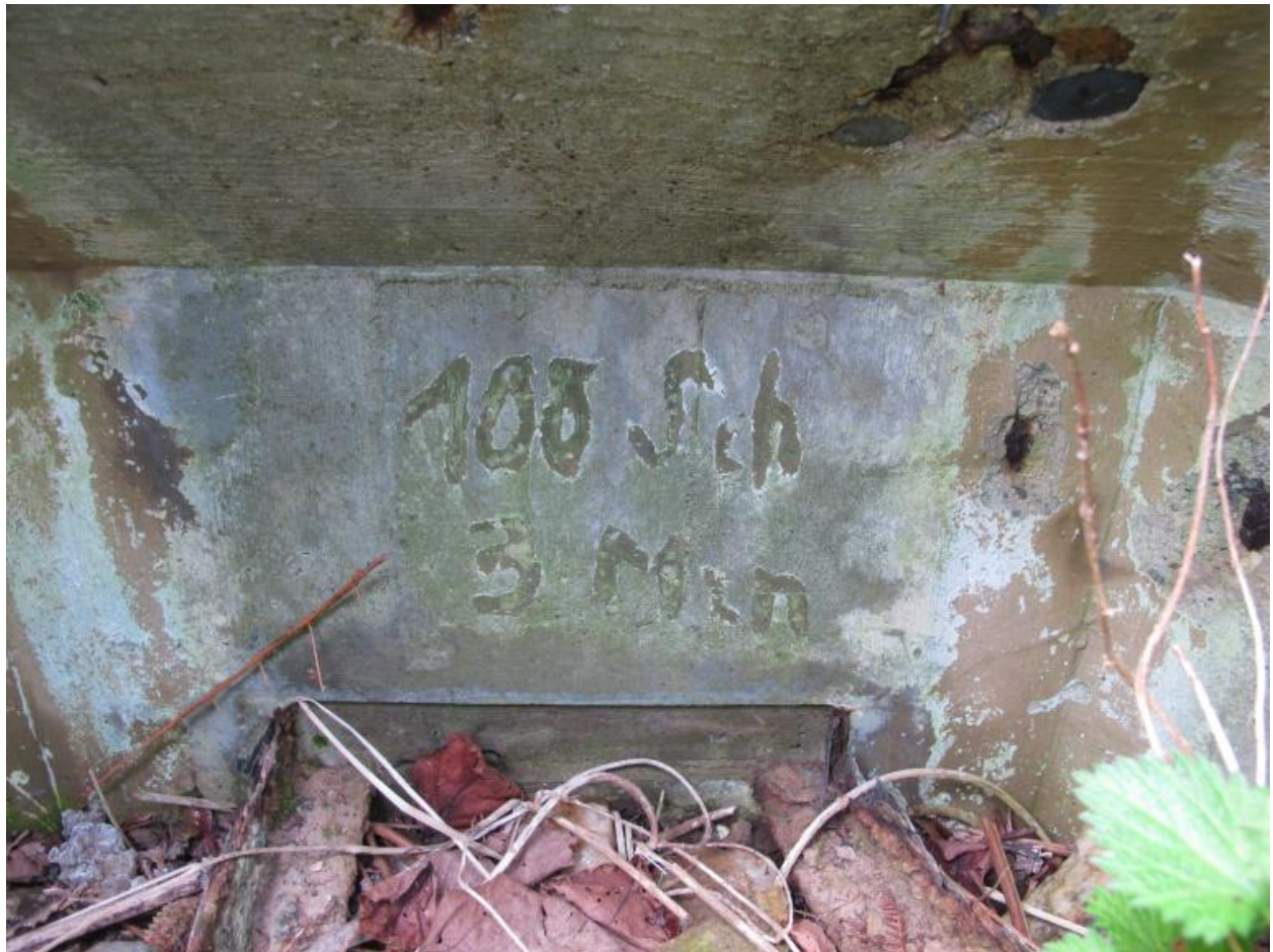
Vue du bunker - poste d'observation et de mitrailleuse dit Tobruk-Stand de Menguen (en bordure du champ), à l'ouest de l'actuelle rue de Kerléo : marquages de tir (100 Sch / 3 Min) (état en 2013)
