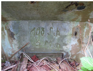
Vue du bunker - poste d'observation et de mitrailleuse dit Tobruk- Stand de Menguen (en bordure du champ), à l'ouest de l'actuelle rue de Kerléo : marquages de tir (100 Sch / 3 Min) (état en 2013) Phot. Guillaume Lécueillier IVR53_20222905264NUCA
