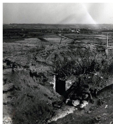
Vue arrière du bunker - casemate, variante du type 667 (United States Army Signal Corps, septembre 1944). Cette photographie a été identifiée en 2022 par Ludovic Le Braz et Simon Roudot Phot. Anonyme IVR53_20232905462NUCA
