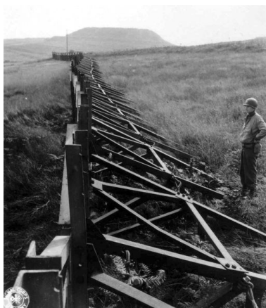
Vue d'un soldat américain observant la ligne continue d'obstacles constituée de barrières Cointet (appelées également portes belges ou élément-c) située au nord du fort de Keranroux et de la Butte du Polygone de la Marine (United States Army Signal Corps, septembre 1944). En arrière-plan, la Butte du Polygone de la Marine Phot. Archives municipales et communautaires. Brest Métropole Océane, Phot. Guillaume (retouche) Lécueillier, Autr. U.S. Army Signal Corps IVR53_20082909378NUC
