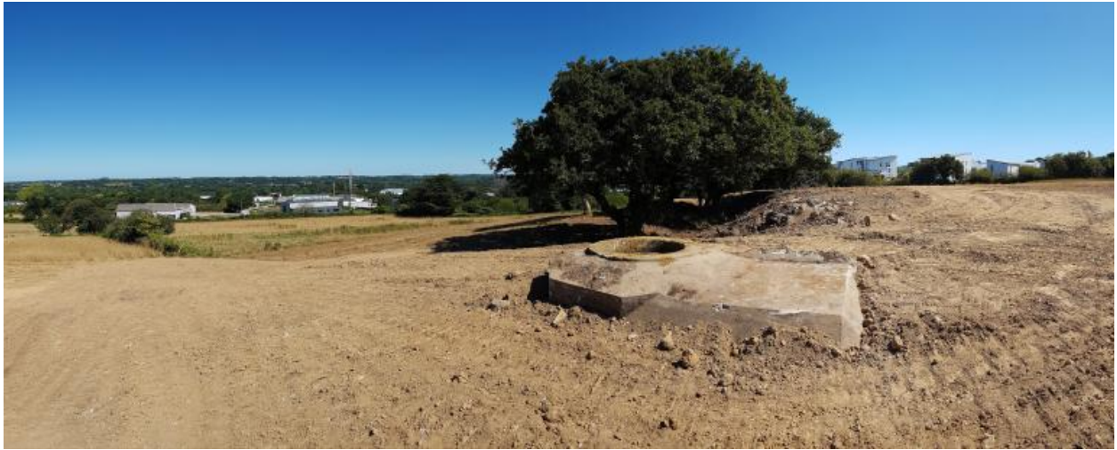
Vue de situation depuis l'ouest (août 2022, chantier en cours)
