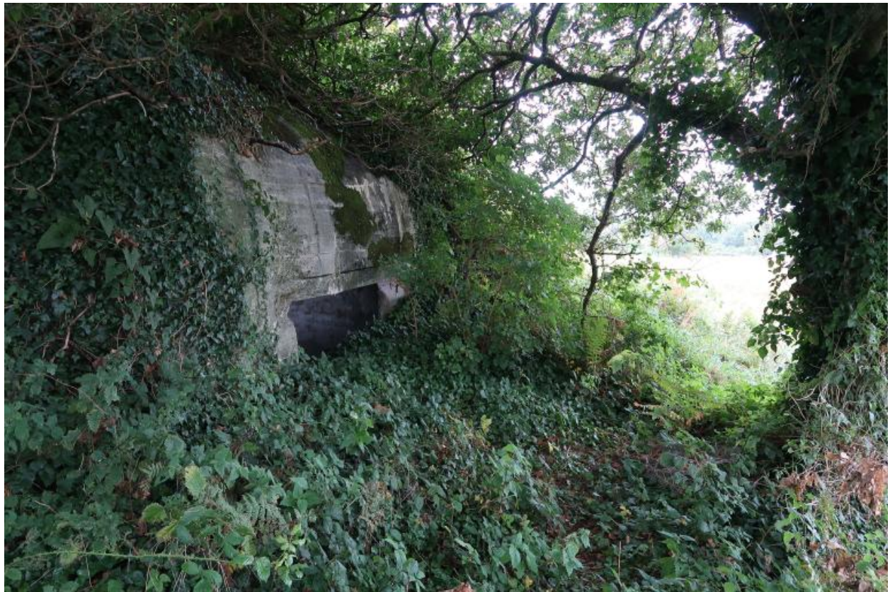
Vue du bunker - casemate de type 667 (365) pour un canon de 5 cm (B 47) situé à l'ouest de l'actuelle rue de Kerléo (état en 2021)
