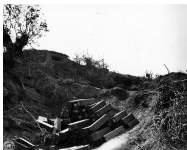
Vue du bunker - casemate surmontant le bunker de type 600 (United States Army Signal Corps, septembre 1944). Au premier plan : des caisses à munitions. Non visible : la cuve pour canon de 5 cm. Cette photographie a été identifiée par Ludovic Le Braz et Simon Roudot Phot. Anonyme IVR53_20232905460NUCA
