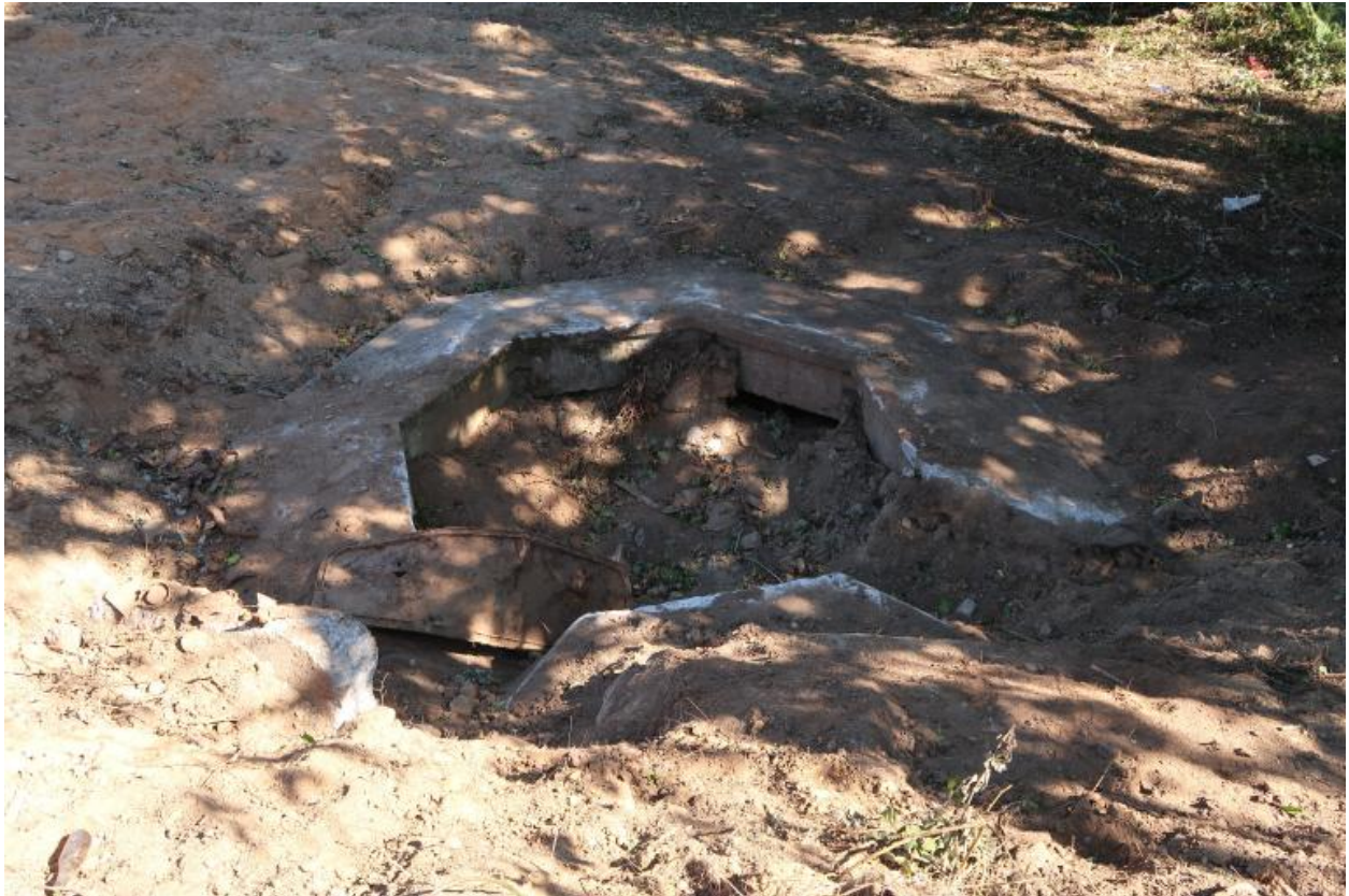
Vue générale (août 2022, chantier en cours)
