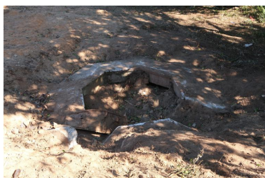
Vue générale (août 2022, chantier en cours) Phot. Guillaume Lécueillier IVR53_20222905847NUCA
