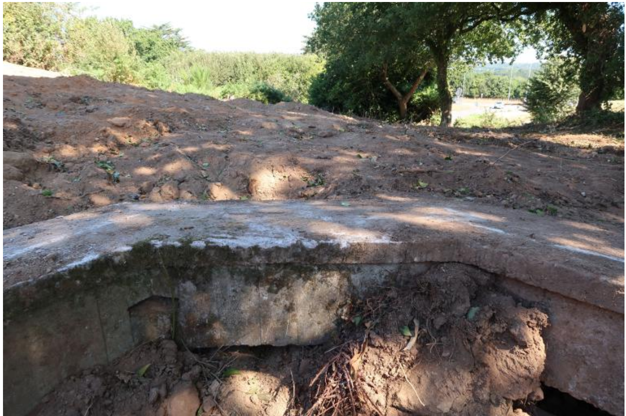
Vue depuis l'encuvement (août 2022, chantier en cours)
