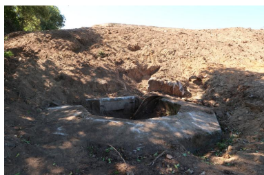
Vue générale (août 2022, chantier en cours). En surplomb de l'encuvement, la dalle de couverture d'un bunker - abri Phot. Guillaume Lécueillier IVR53_20222905846NUCA
