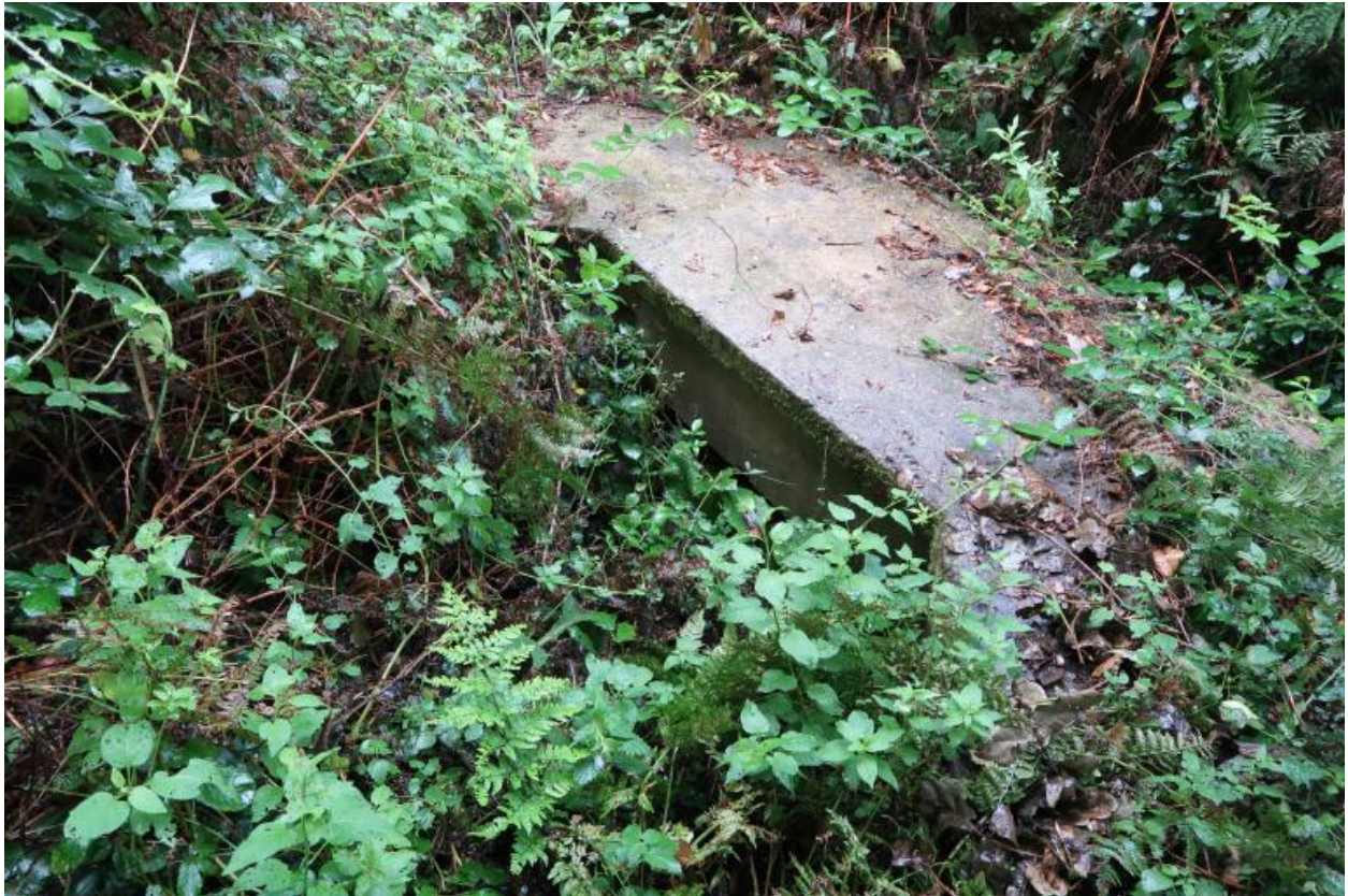
Vue du bunker en partie remblayé et envahi par la végétation (état en 2021)
