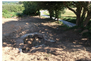
Vue de situation (août 2022, chantier en cours) Phot. Guillaume Lécueillier IVR53_20222905845NUCA
