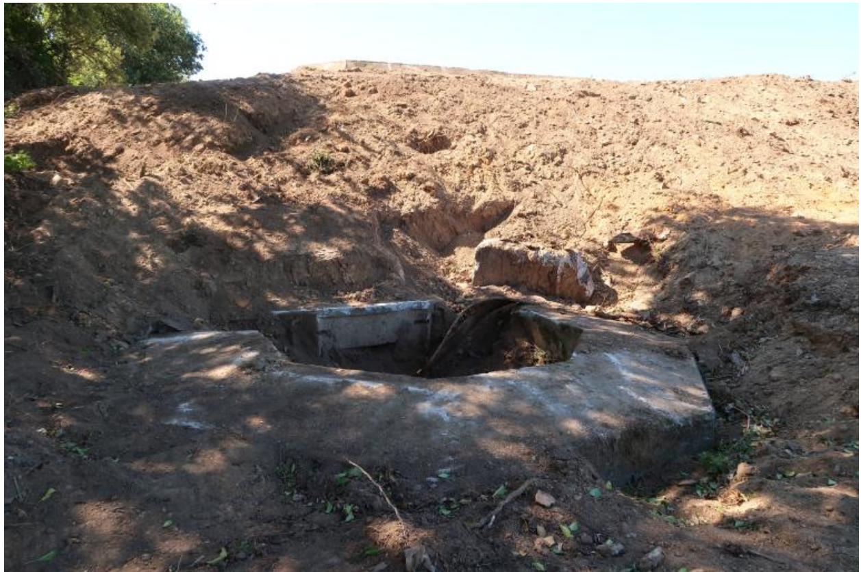
Vue générale (août 2022, chantier en cours). En surplomb de l'encuvement, la dalle de couverture d'un bunker - abri
