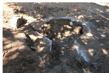
Vue générale (août 2022, chantier en cours) Phot. Guillaume Lécueillier IVR53_20222905848NUCA
