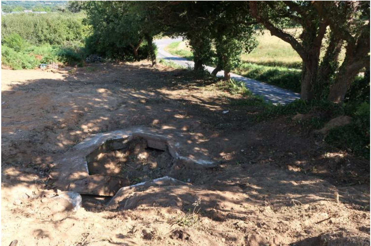
Vue de situation (août 2022, chantier en cours)
