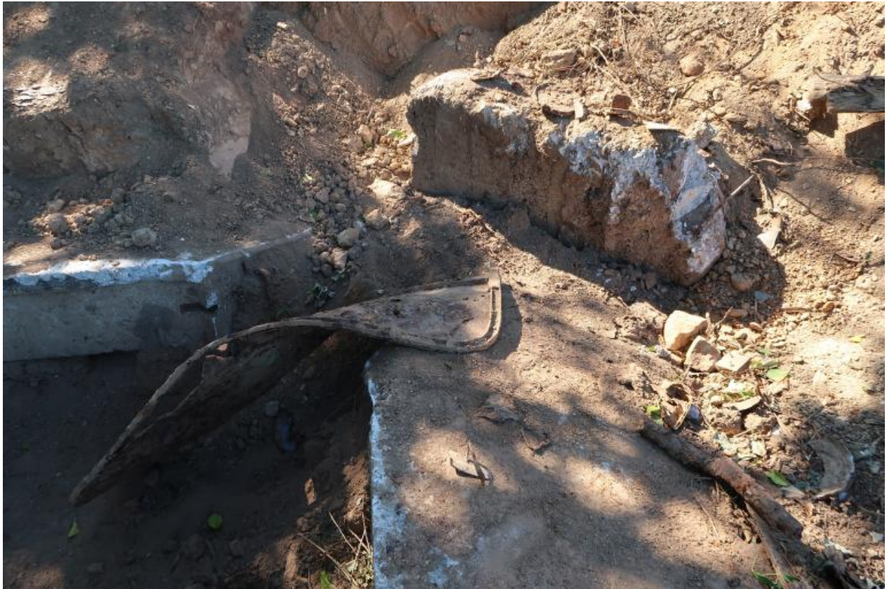
Vue de détail (août 2022, chantier en cours)
