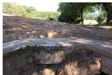
Vue depuis l'encuvement (août 2022, chantier en cours) Phot. Guillaume Lécueillier IVR53_20222905851NUCA
