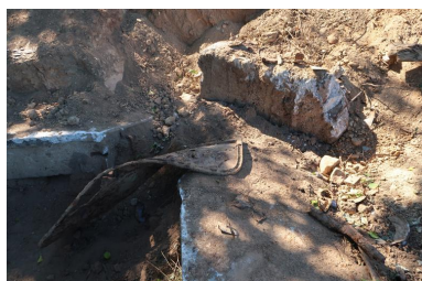
Vue de détail (août 2022, chantier en cours) Phot. Guillaume Lécueillier IVR53_20222905849NUCA
