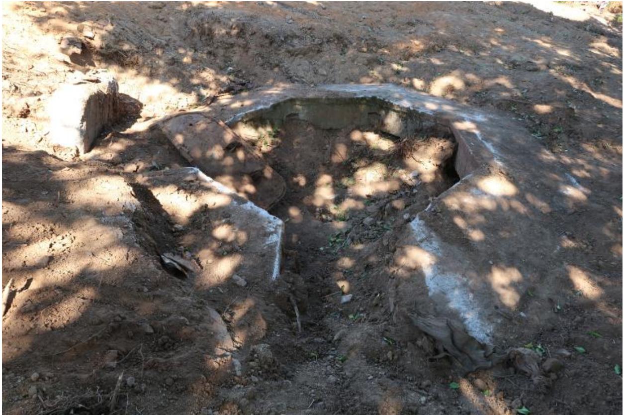
Vue générale (août 2022, chantier en cours)
