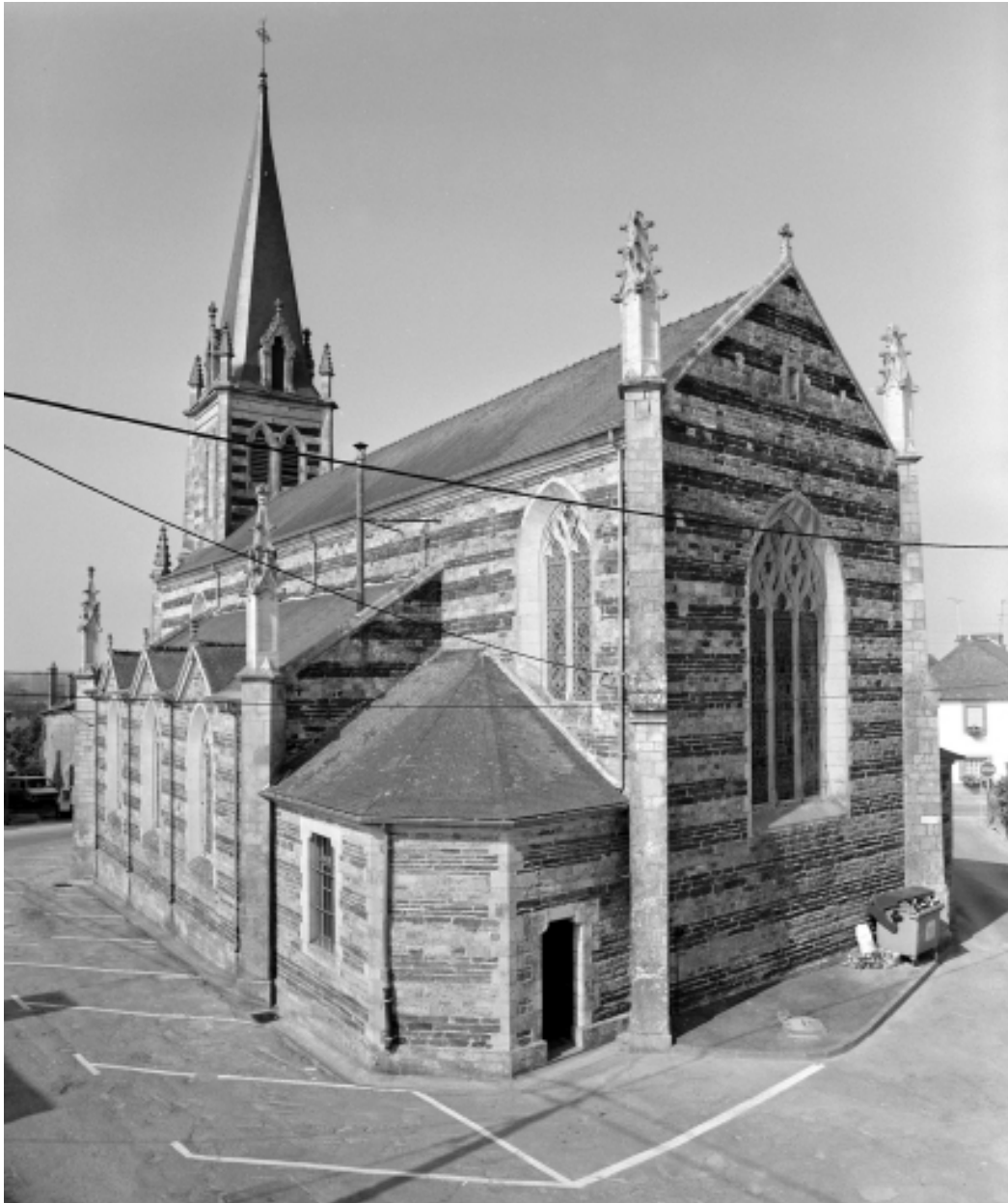
Vue générale nord-est
