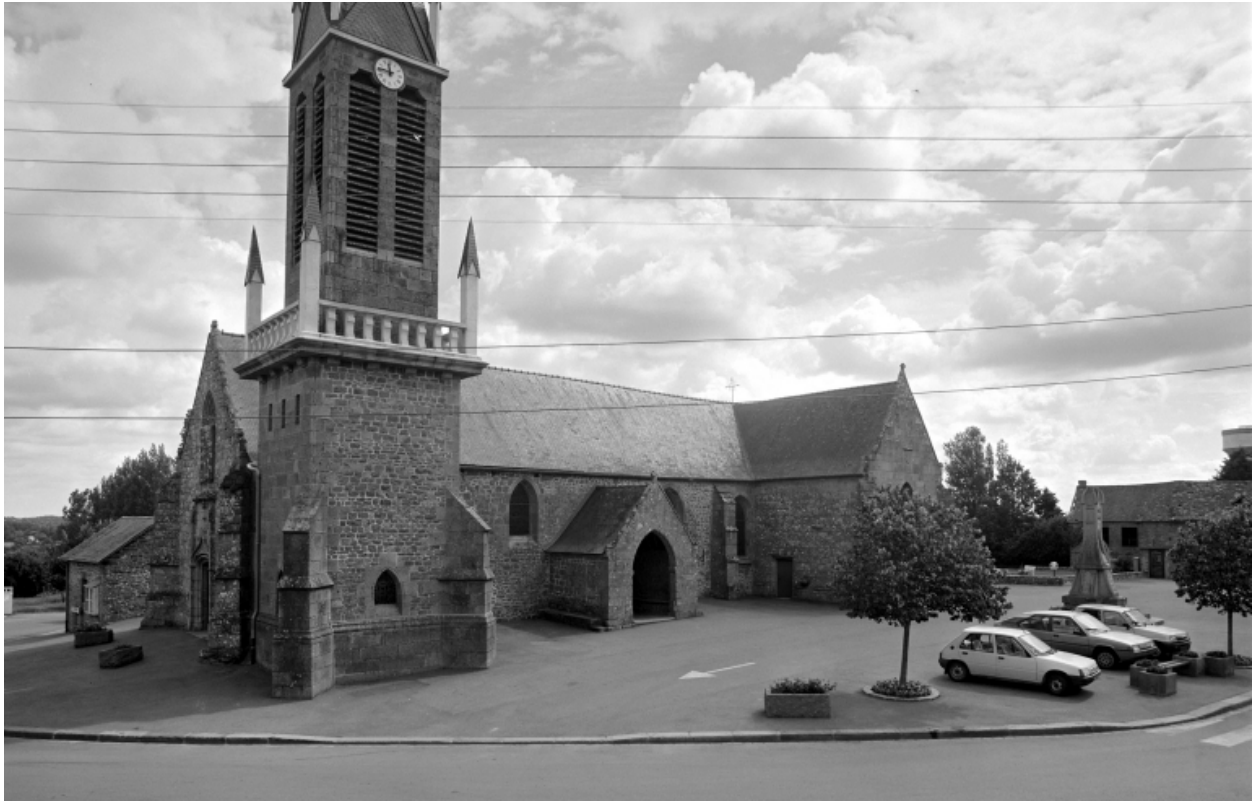
Elévation Sud : vue générale
