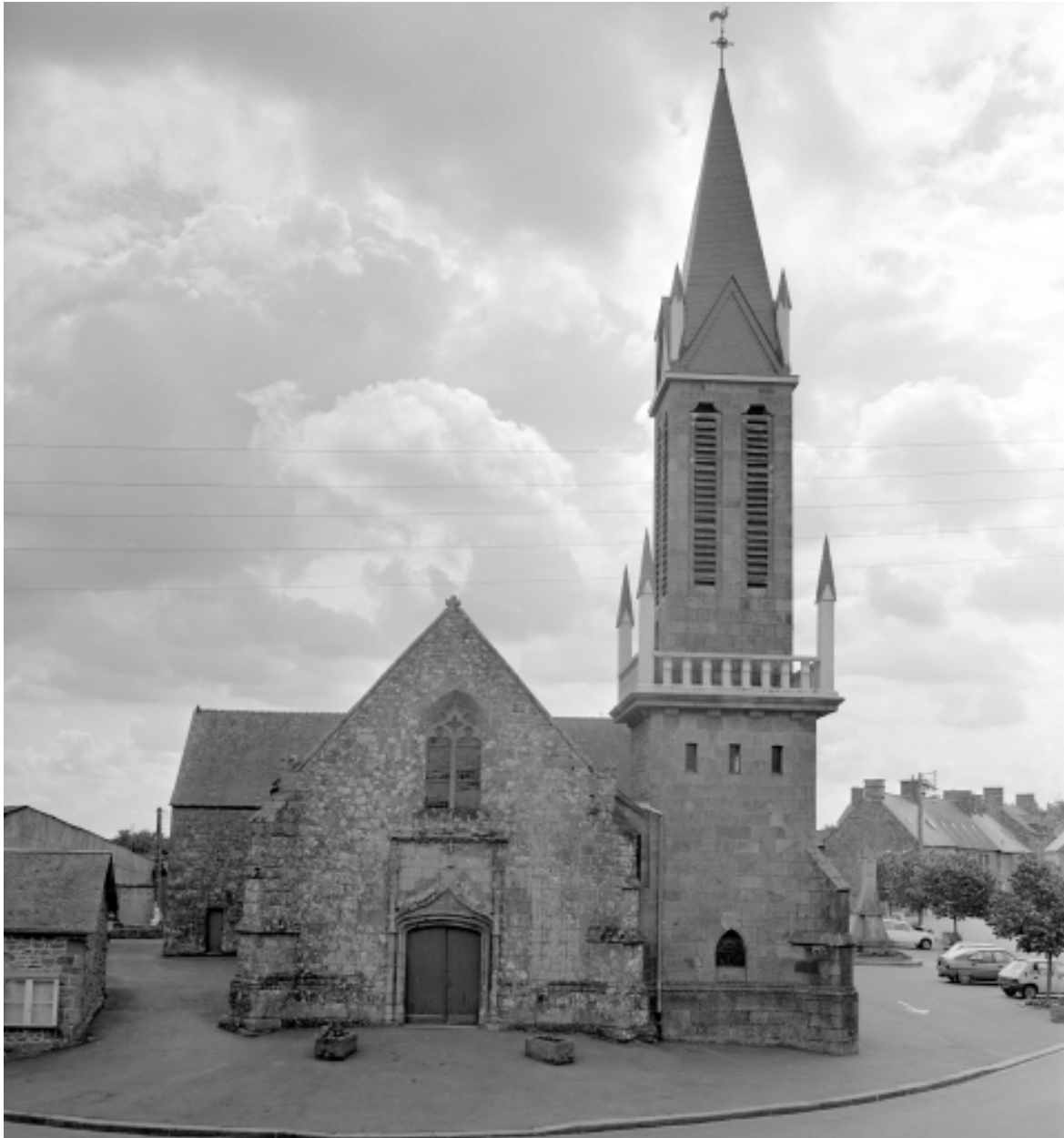
Elévation Ouest : vue générale
