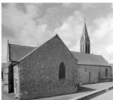
Elévation Nord : vue générale Phot. Guy Artur, Phot. Norbert Lambart IVR53_19943501295X
