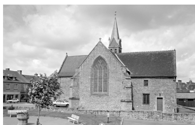
Elévation Est : vue générale Phot. Guy Artur, Phot. Norbert Lambart IVR53_19943501294X
