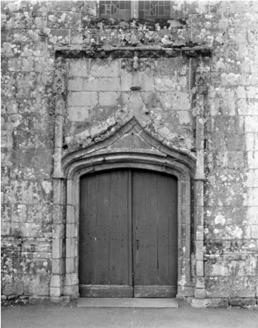
Elévation Ouest, porte principale : vue générale
