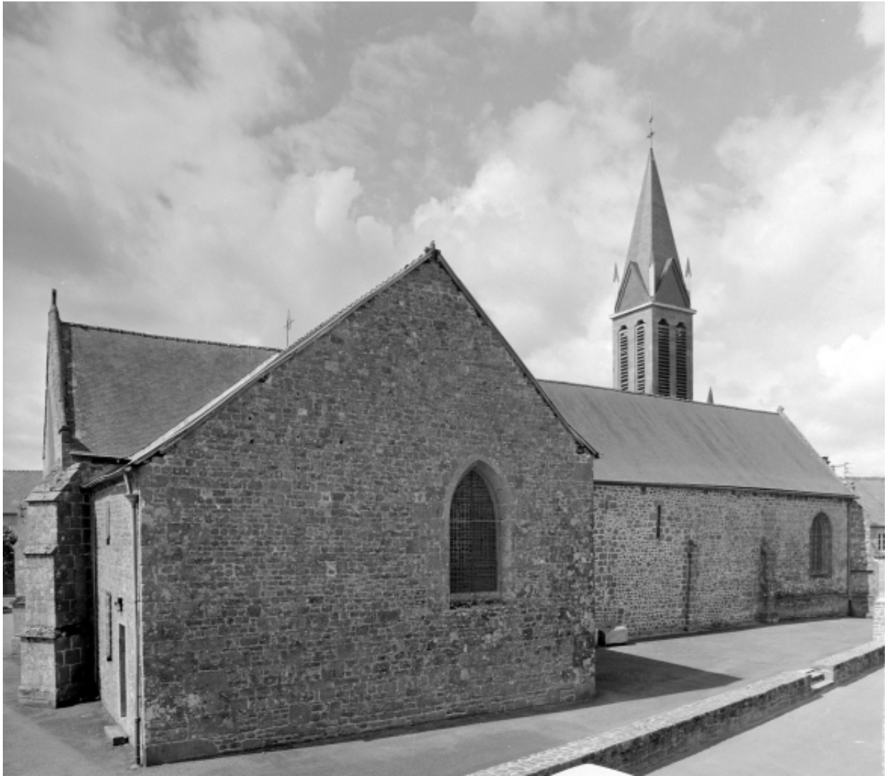
Elévation Nord : vue générale
