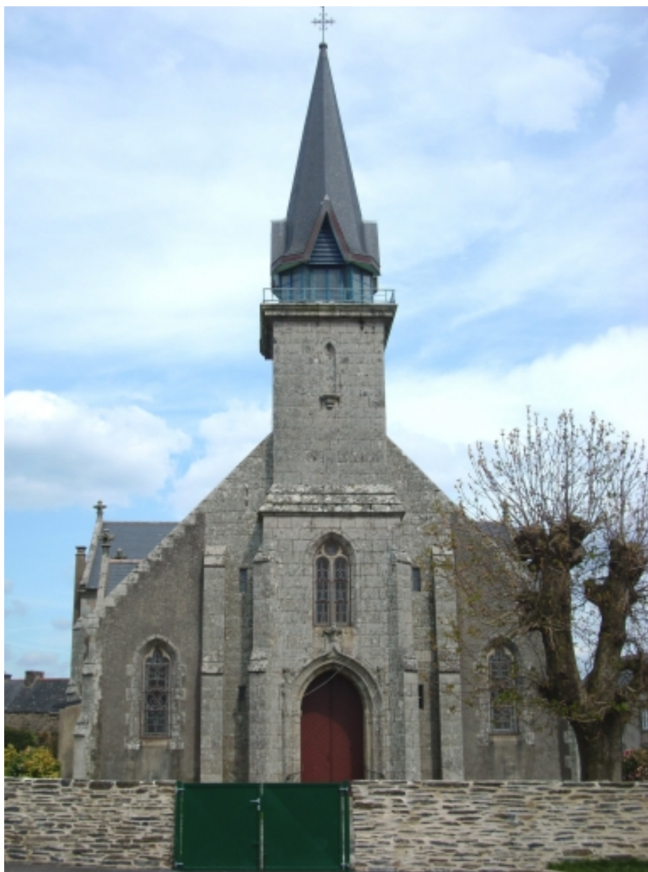
Saint-Goazec, église paroissiale : élévation ouest
