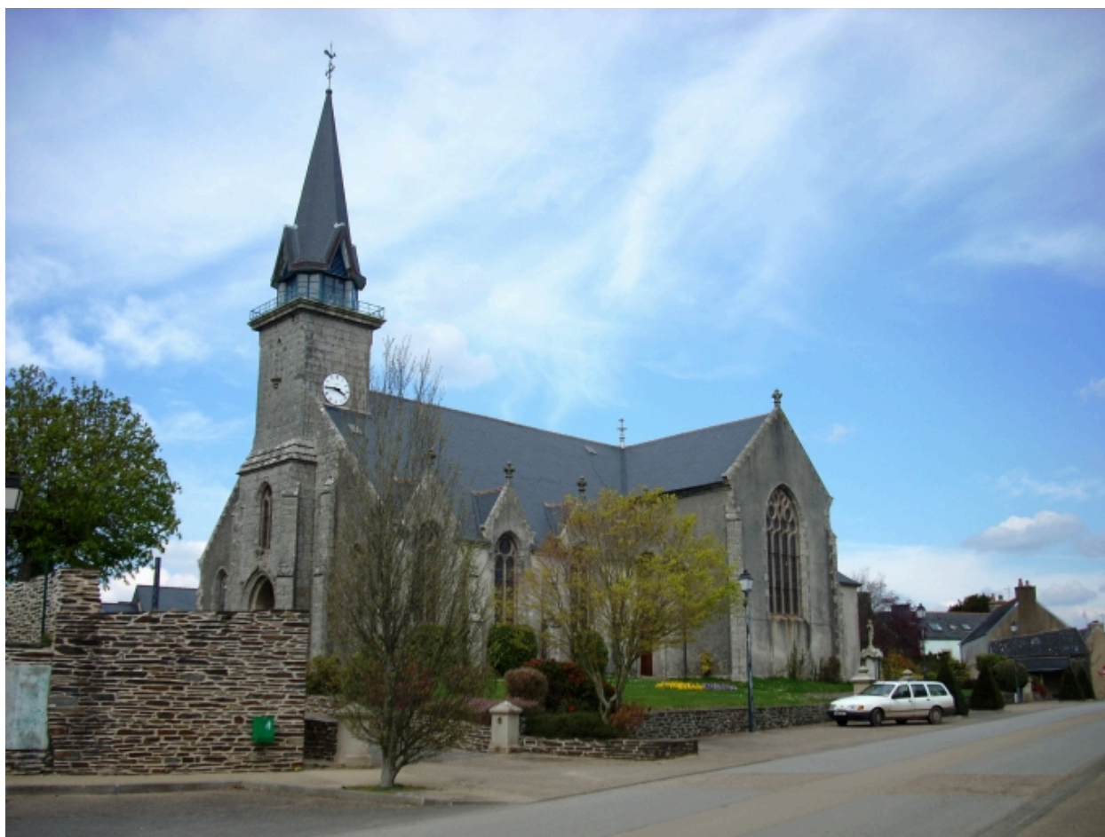
Saint-Goazec, église paroissiale : vue générale sud-ouest
