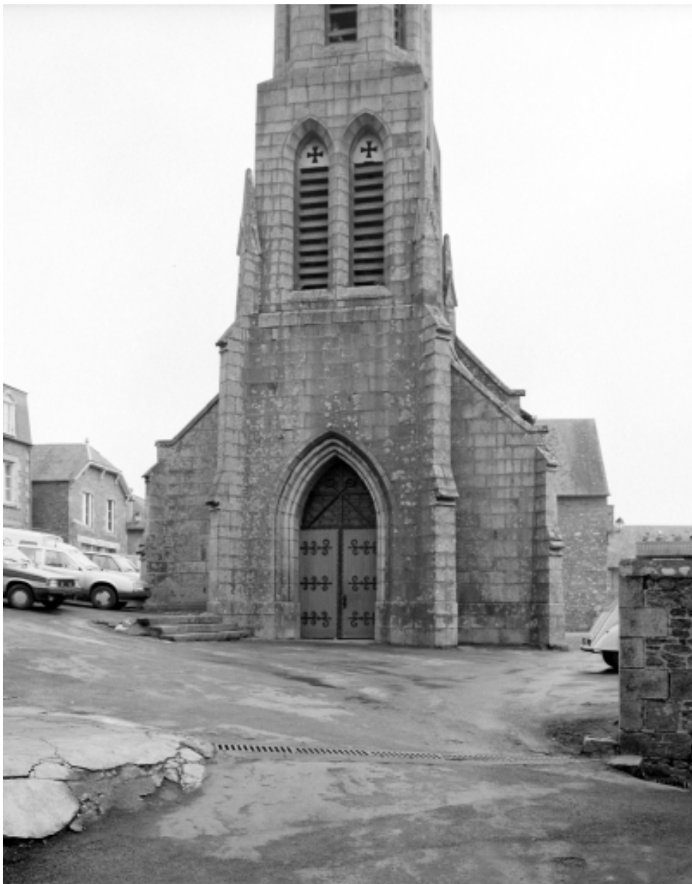
Elévation Ouest : vue générale
