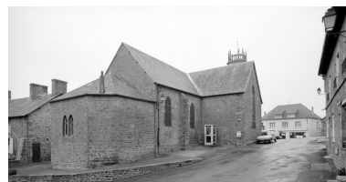
Elévation Nord-Est : vue générale Phot. Bernard Bègne, Phot. M. Loyon IVR53_19933500495X
