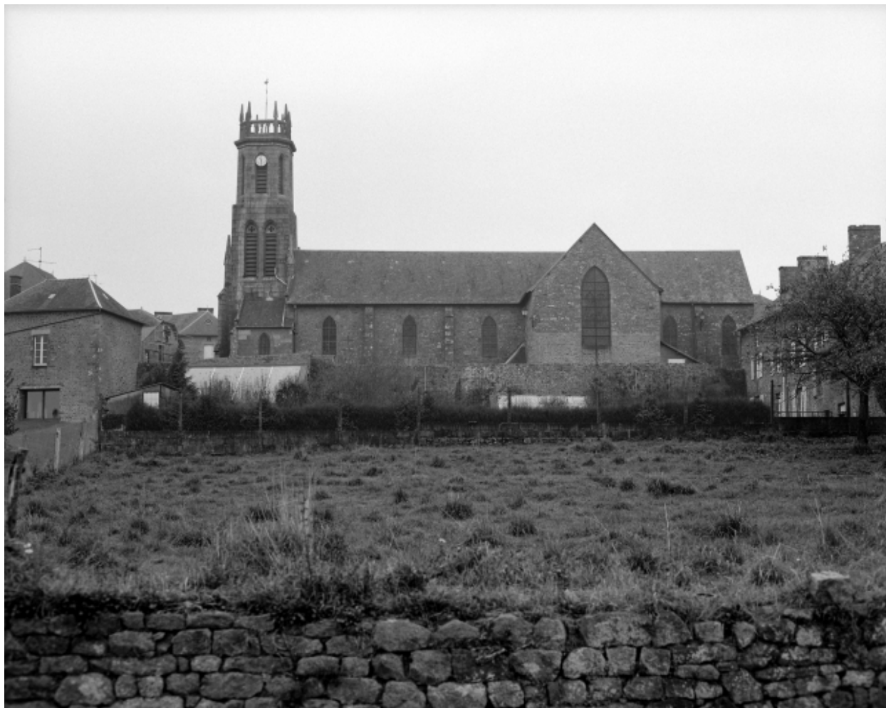
Elévation Sud-Ouest : vue générale
