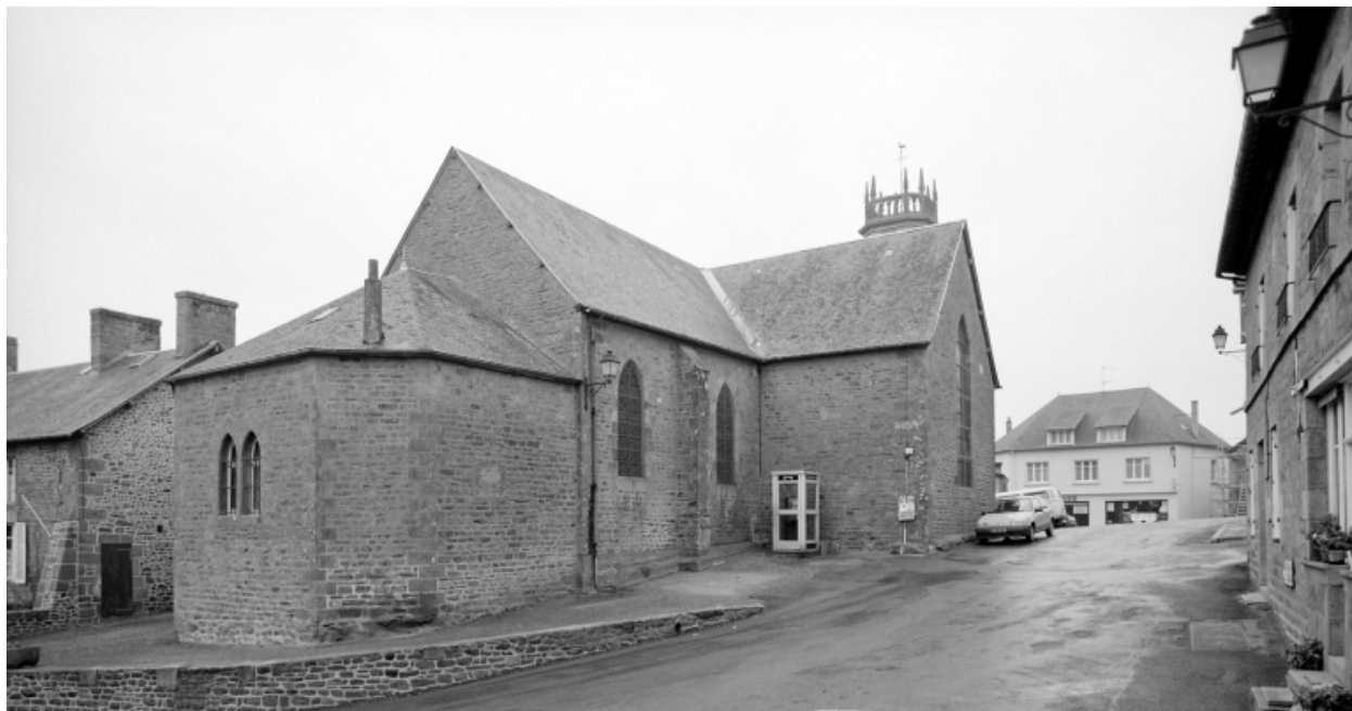
Elévation Nord-Est : vue générale
