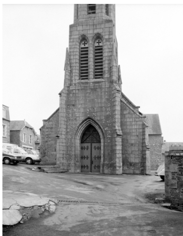
Elévation Ouest : vue générale Phot. Bernard Bègne, Phot. M. Loyon IVR53_19933500497X
