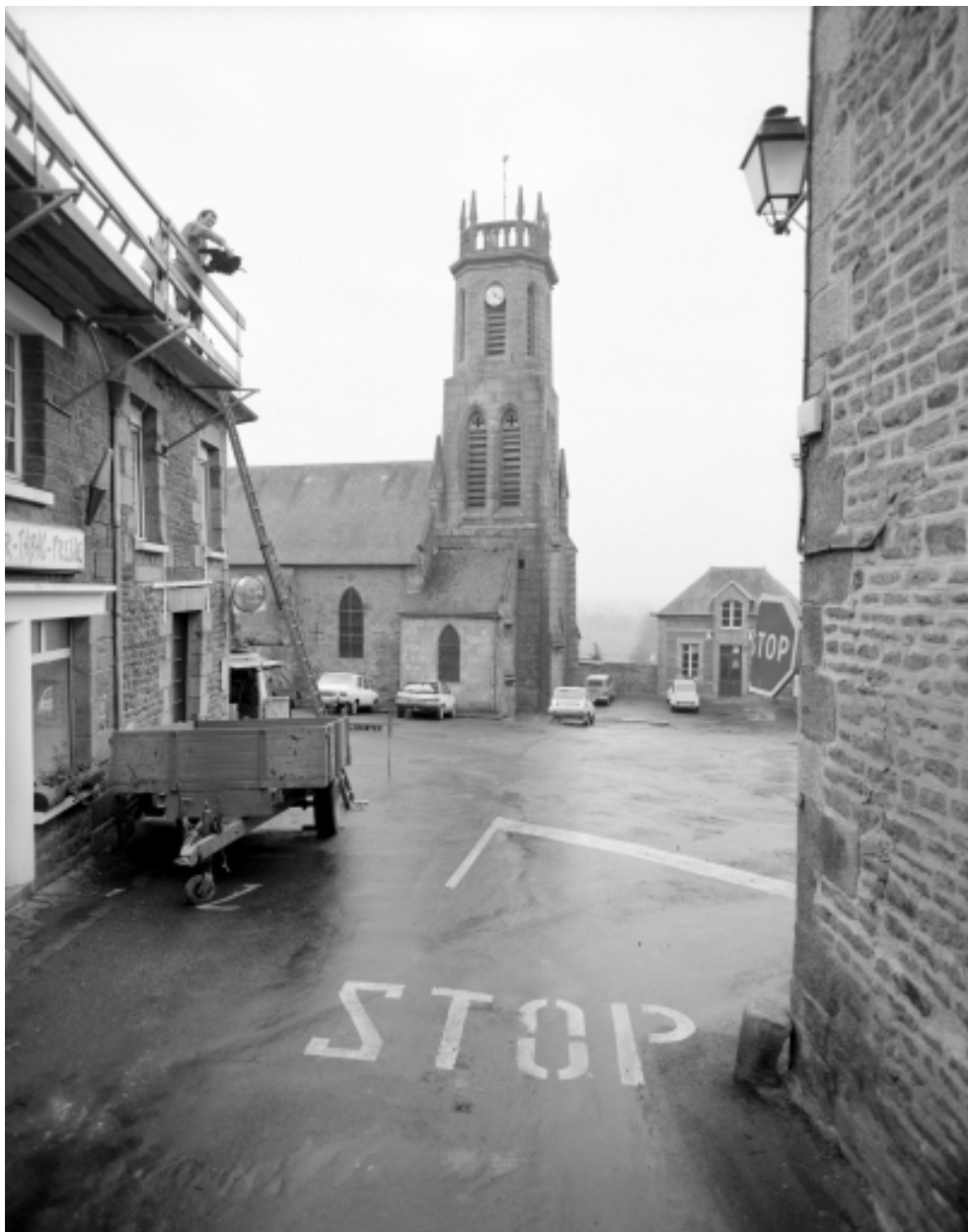
Elévation Nord, partie Ouest : vue générale
