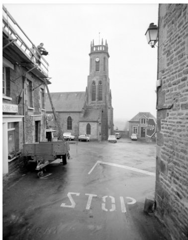
Elévation Nord, partie Ouest : vue générale Phot. Bernard Bègne, Phot. M. Loyon IVR53_19933500494X
