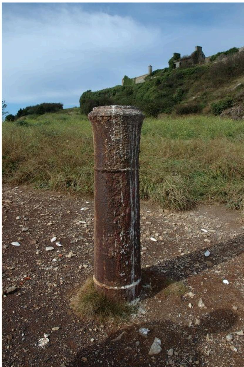
Crozon : vue de l'île des Morts en 2007, canon-bollard permettant de capeler l'oeil des amarres
