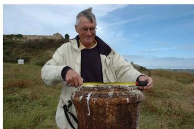
Crozon : vue de l'île des Morts en 2007, canon-bollard permettant de capeler l'oeil des amarres.
