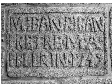
Elévation Nord-Ouest, porche : détail des inscriptions Phot. Bernard Bègne, Phot. M. Loyon IVR53_19933500146X
