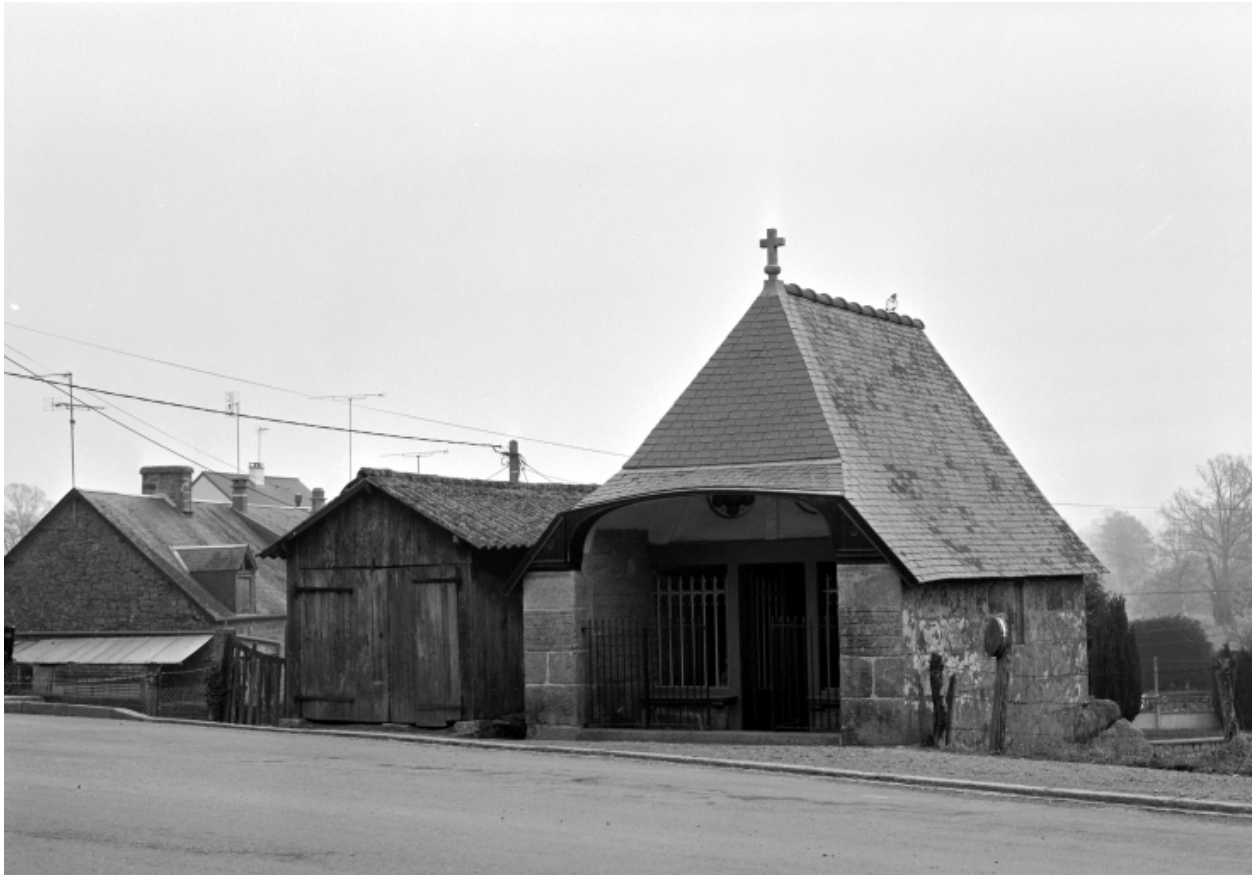
Elévation Nord-Ouest : vue générale
