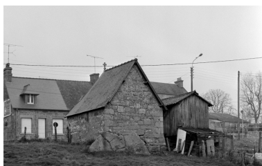
Elévation Sud-Est : vue générale Phot. Bernard Bègne, Phot. M. Loyon IVR53_19933500143X
