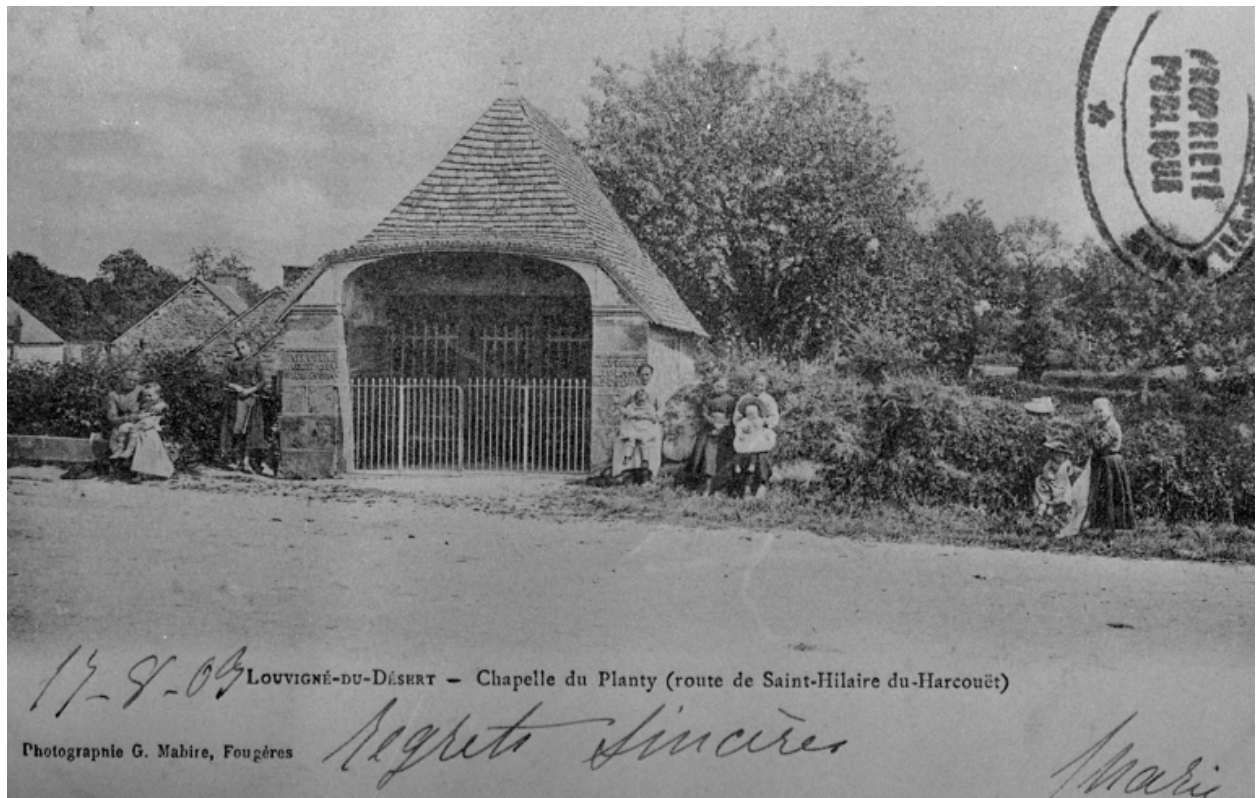
Elévation Nord-Ouest : vue générale (Carte postale ancienne, AD35 : 6Fi)
