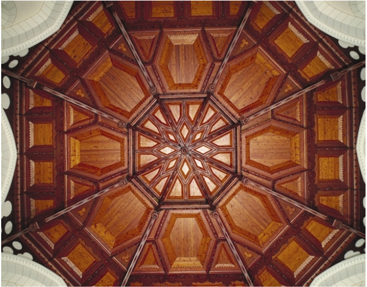
Intérieur, plafond : vue générale
