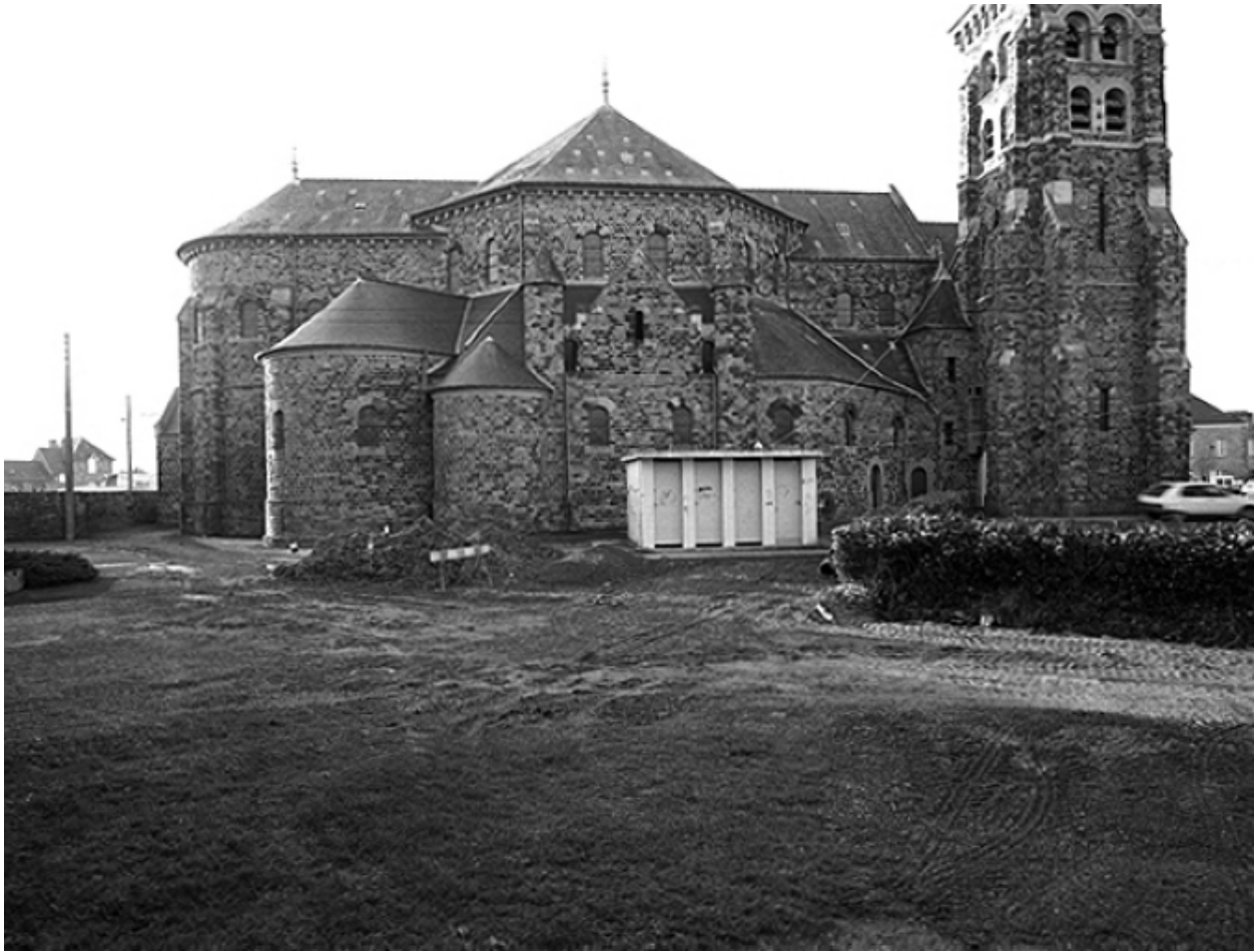
Elévation nord : vue générale
