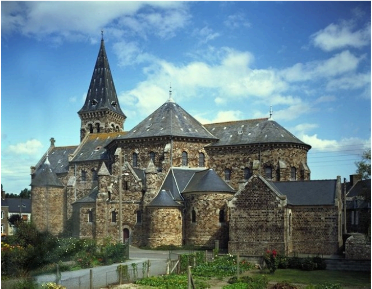
Elévation sud-ouest : vue générale
