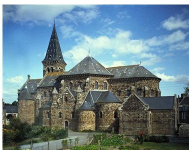
Elévation sud-ouest : vue générale Phot. Guy Artur, Phot. Norbert Lambart IVR53_19923500701XA
