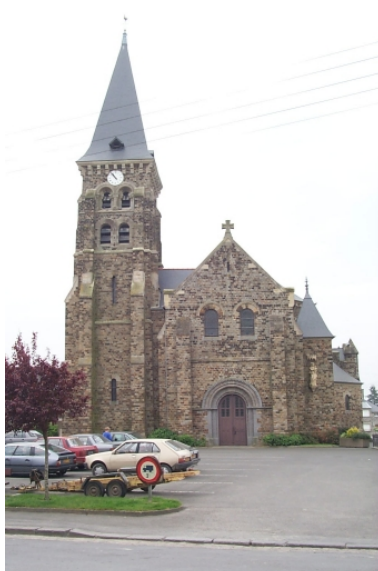
Elévation nord : vue générale Phot. Claude Quillivic IVR53_19993505655NUCA
