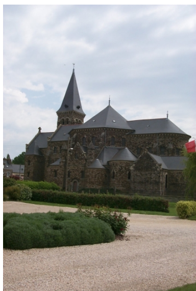
Vue générale sud ouest Phot. Claude Quillivic IVR53_19993505791NUCA
