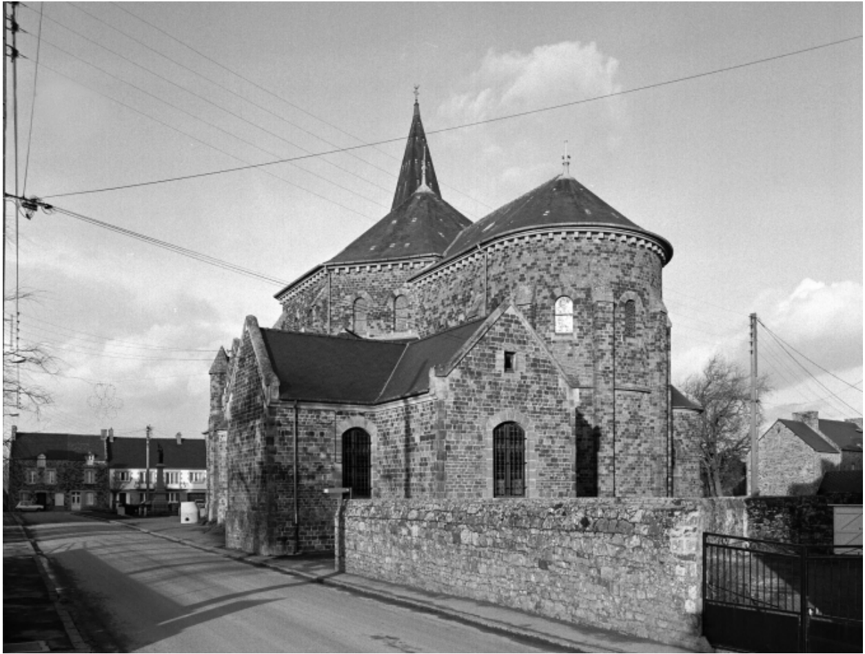
Elévation sud : vue générale
