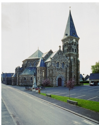
Vue générale sud ouest Phot. Guy Artur, Phot. Norbert Lambart IVR53_19923500850VA
