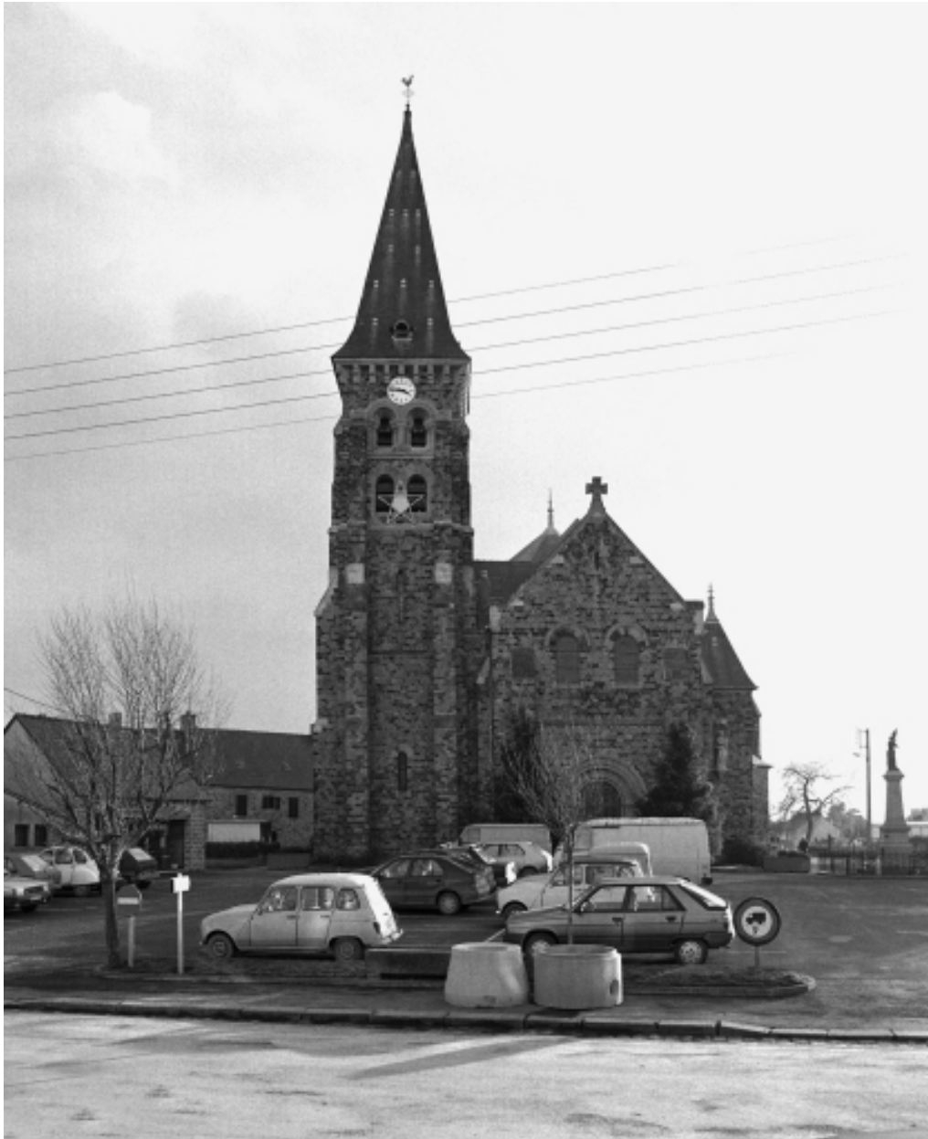
Elévation ouest : vue générale
