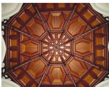
Intérieur, plafond : vue générale Phot. Guy Artur, Phot. Norbert Lambart IVR53_19923500762VA
