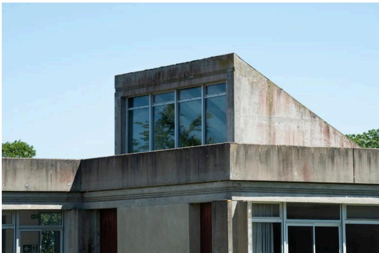
Sur les toits de l'aile est de l'externat : des baies exposées au nord devaient permettre l'éclairage optimal de salles de dessin. Un faux plafond a été installé dans ces salles. Les baies n'ont plus qu'un rôle décoratif.
