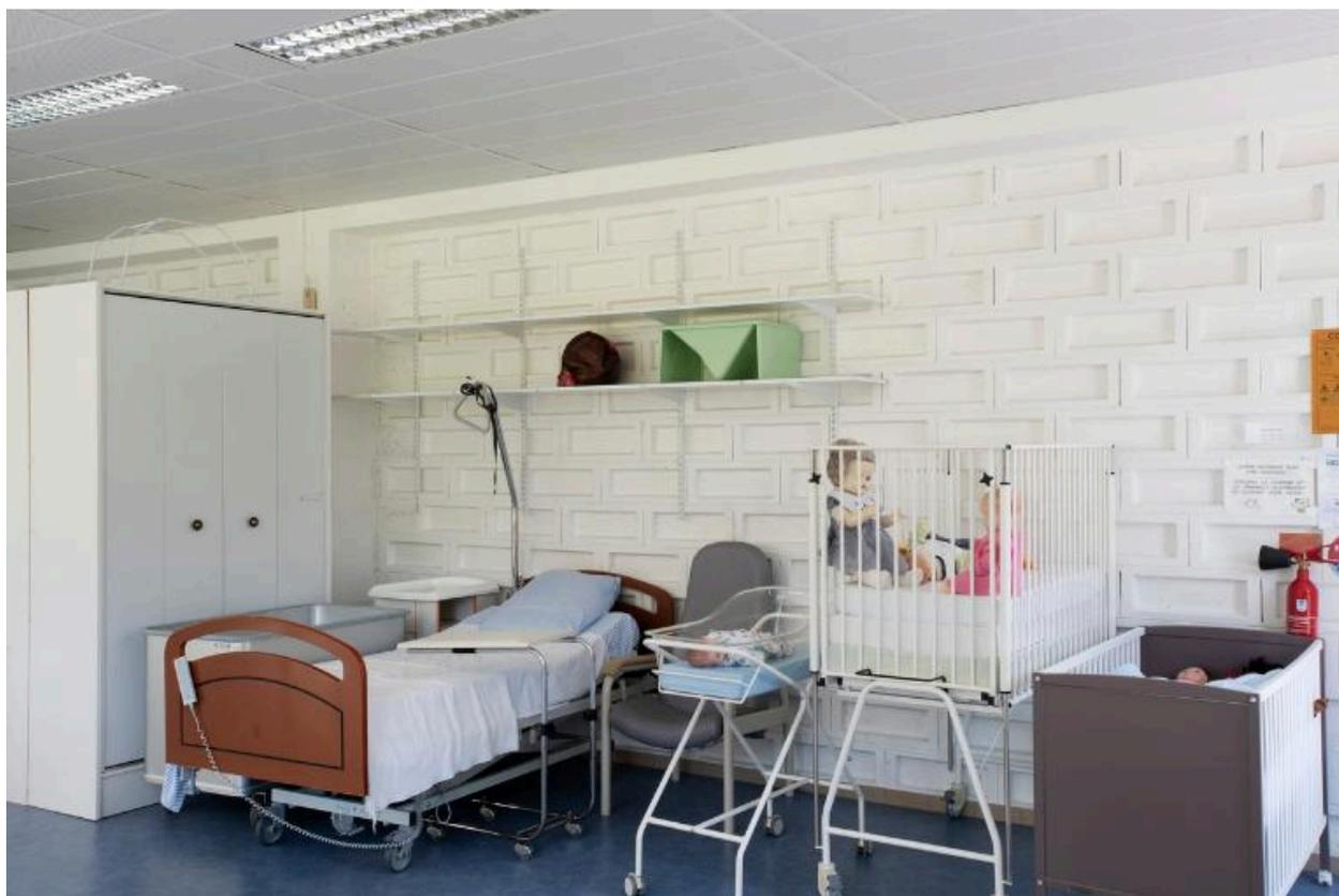
Atelier. Noter la cloison en parpaing de ciment dont la forme joue un rôle acoustique.
