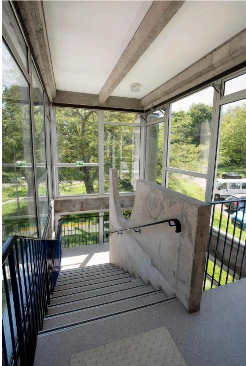
Cage d'escalier au sud de l'aile ouest de l'externat. Noter le design du noyau central en béton, et son rôle porteur, qui autorise des façades entièrement vitrées sur trois côtés.
