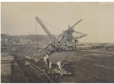
Travaux de la forme de radoub n°1 : mise à niveau du terre-plein à la jonction du couronnement
