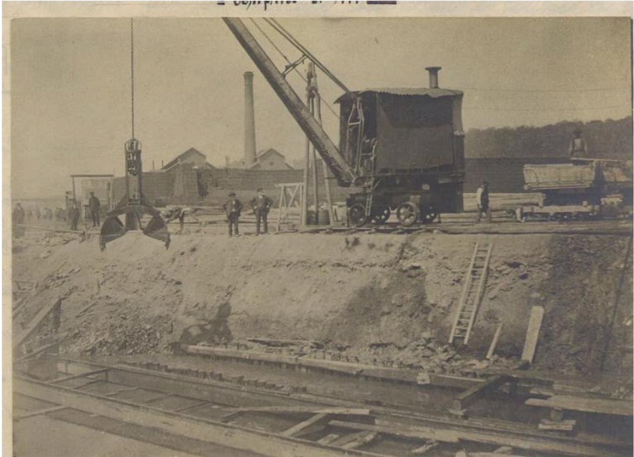
Travaux de la forme de radoub n°1 : extraction des enrochements (1904 ?)
