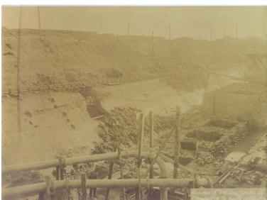
Travaux de la forme de radoub n°1 : blocs de fondation en cours de construction, 31 octobre 1904
