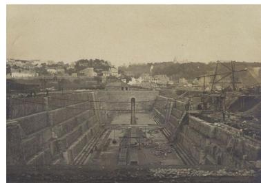
Travaux de la forme de radoub n°1 : avancement des travaux, état au 31 janvier 1907 (bajoyer babord construit ; bajoyer tribord en cours de construction ; radier finalisé)
