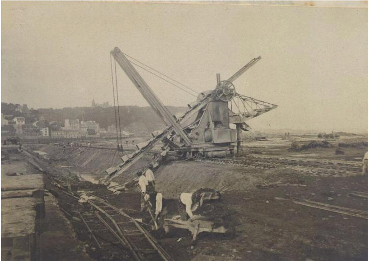
Travaux de la forme de radoub n°1 : mise à niveau du terre-plein à la jonction du couronnement
