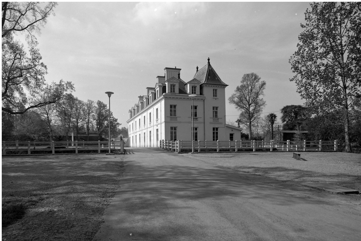
Vue générale depuis l'allée d'accès.
