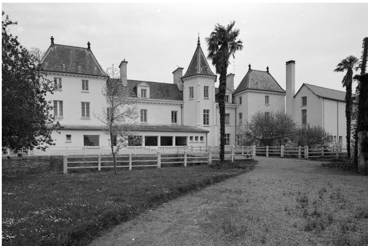
Vue générale façade ouest.
