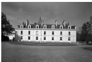
Vue générale façade principale à l'est. Phot. Guy Artur IVR53_19683500373V
