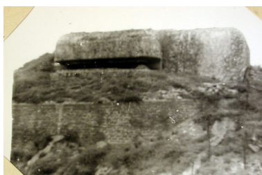
Vue du bunker - poste de commandement de la pointe du Petit Minou, vers 1946-1947 (extrait du rapport Pinczon du Sel, photographie n° 96) Phot. Guillaume Lécueillier IVR53_20032901716NUCA
