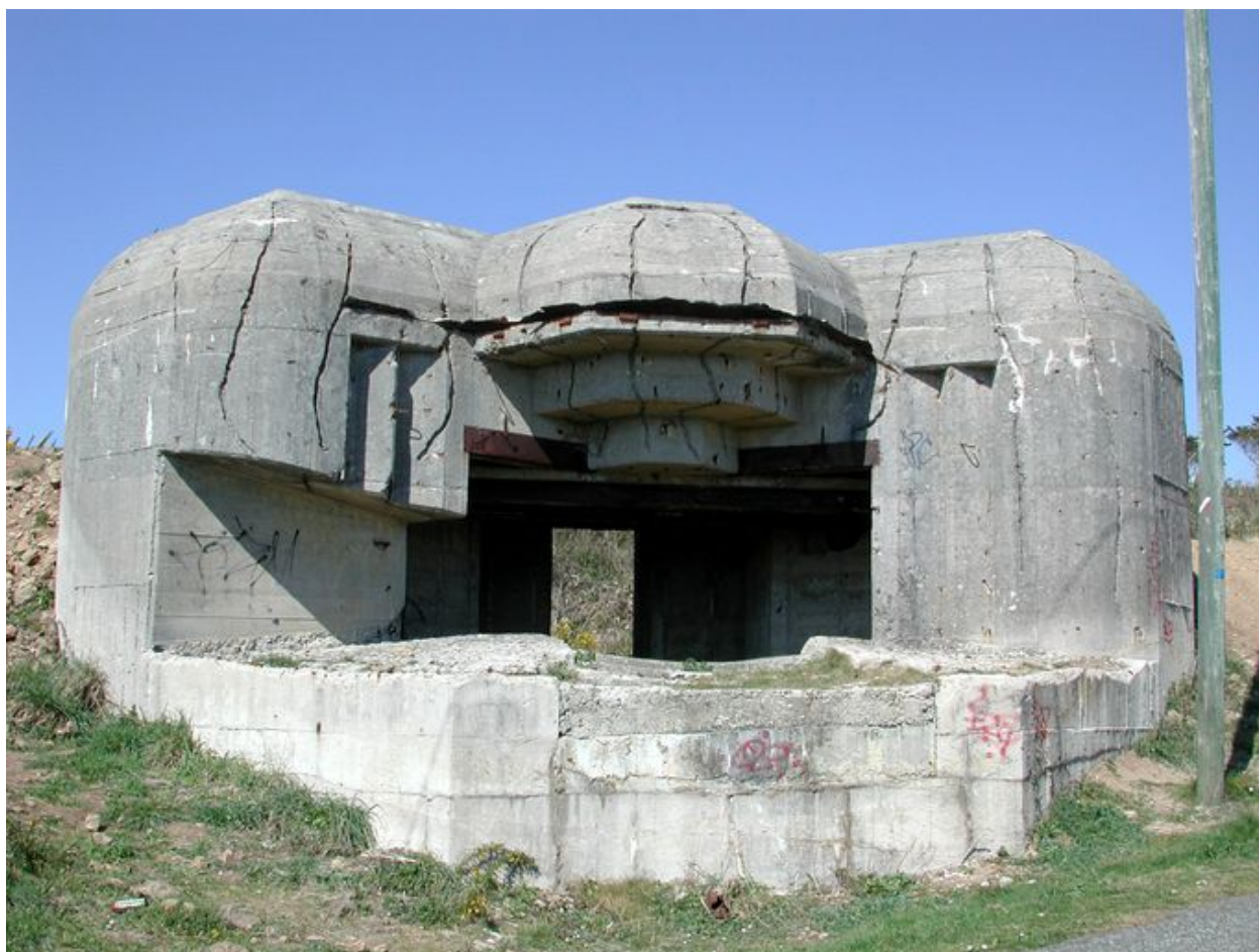
Vue de la casemate est (état en 2004)
