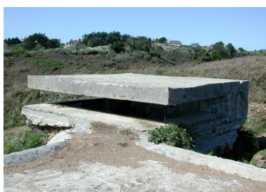
Vue du poste d'observation surplombant la casemate ouest (état en 2004) Phot. Guillaume Lécueillier IVR53_20042904313NUCA
