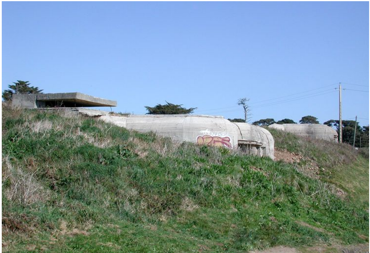
Vue de situation depuis l'ouest (état en 2004). Surplombant la casemate ouest, un poste d'observation
