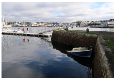
Quai au vin Phot. Erwana L'Haridon IVR53_20252910106NUCA
