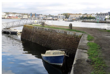
Quai au vin Phot. Erwana L'Haridon IVR53_20252910108NUCA
