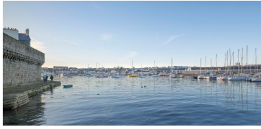
Arrière-port et quai au vin Phot. Charlotte Barraud IVR53_20252900223NUCA
