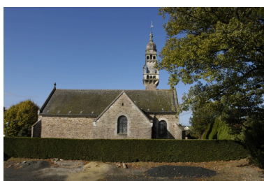
Façade est de l'église Phot. Alain Dagorn IVR53_20043502177NUCA
