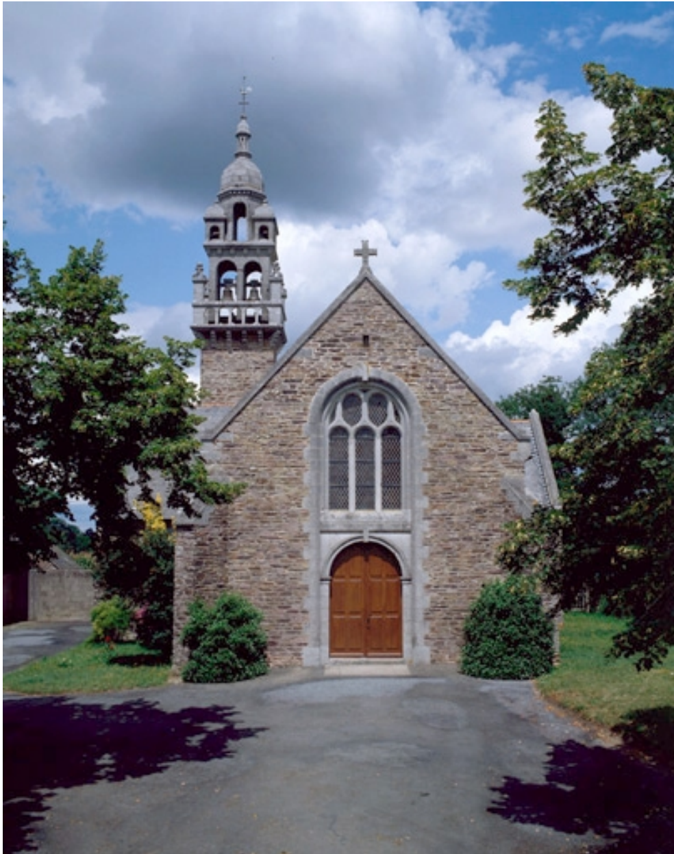
Élévation sud : vue générale
