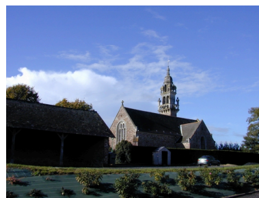
Vue de situation de l'église Phot. Vanessa Hue IVR53_20043514624NUCA
