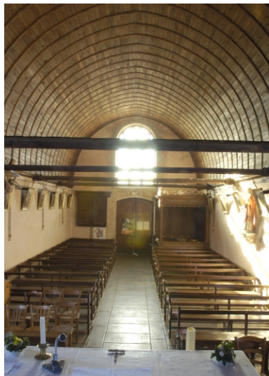
Vue intérieure prise du chœur vers la nef Phot. Alain Dagorn IVR53_20043502585NUCA
