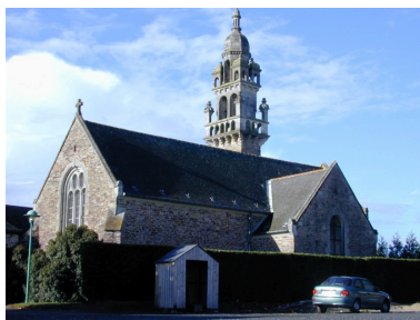
Vue générale sud-est de l'église Phot. Vanessa Hue IVR53_20043514715NUCA
