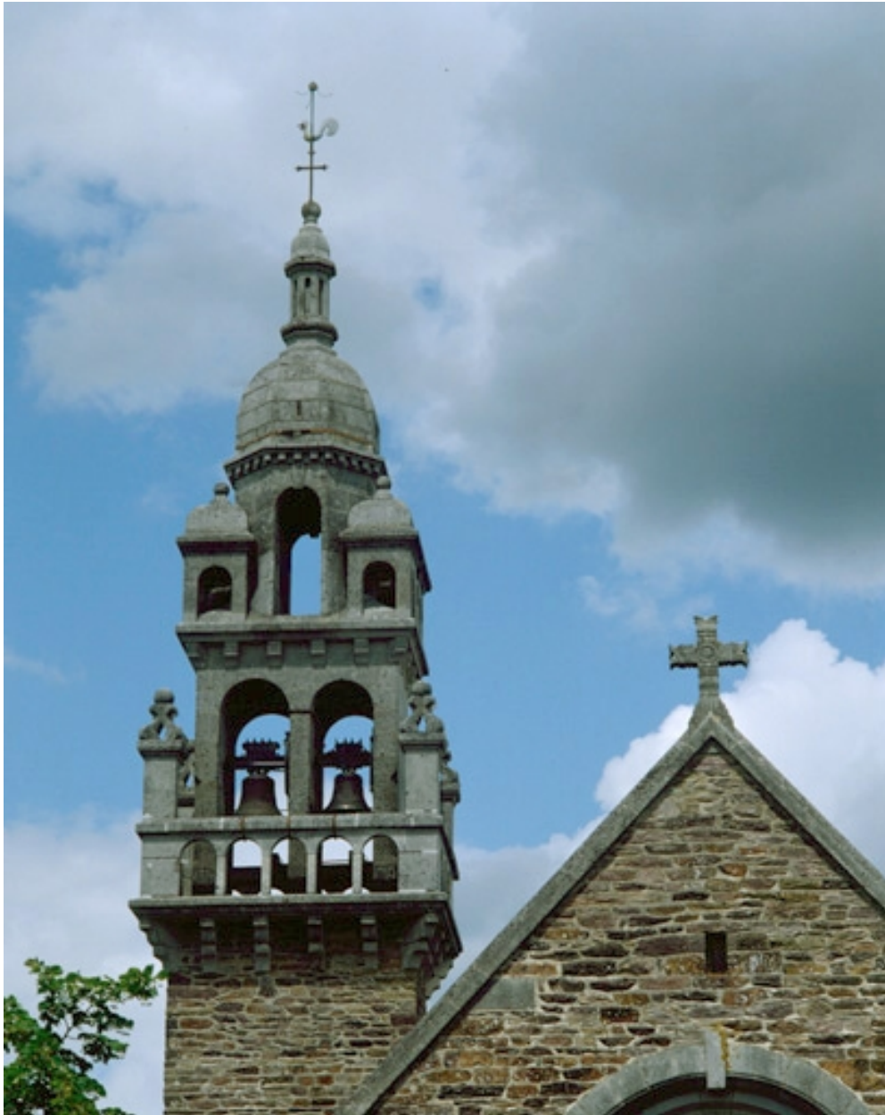
Élévation ouest, clocher, partie haute : vue générale
