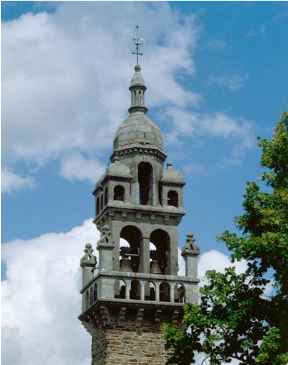
Élévation nord, clocher, partie haute : vue générale
