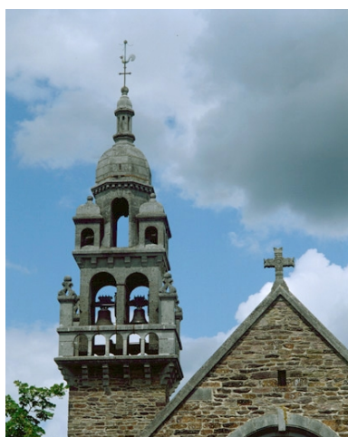
Élévation ouest, clocher, partie haute : vue générale Phot. Guy Artur, Phot. Norbert Lambart IVR53_19923500682XA
