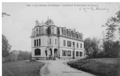
Vue de la façade principale Phot. Elise Lauranceau IVR53_20042905566NUCB
