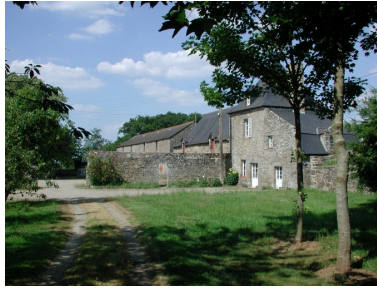
L'emplacement de l'ancien manoir Phot. Claude Quillivic IVR53_20013519918NUCA
