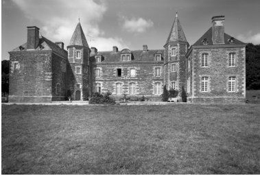
Vue générale sud Phot. François Dagorn IVR53_19775600721V
