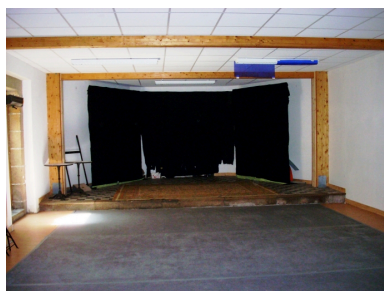
Morlaix, chapelle Saint-Joseph : vue axiale est de la salle de théâtre au rez-de-chaussée Phot. Gwénaél Fauchille IVR53_20082906606NUCA
