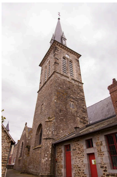
Tour-clocher, façade septentrionale, église Saint-Jean-Baptiste, Saint-Jean-sur-Vilaine IVR53_20153505417NUCA
