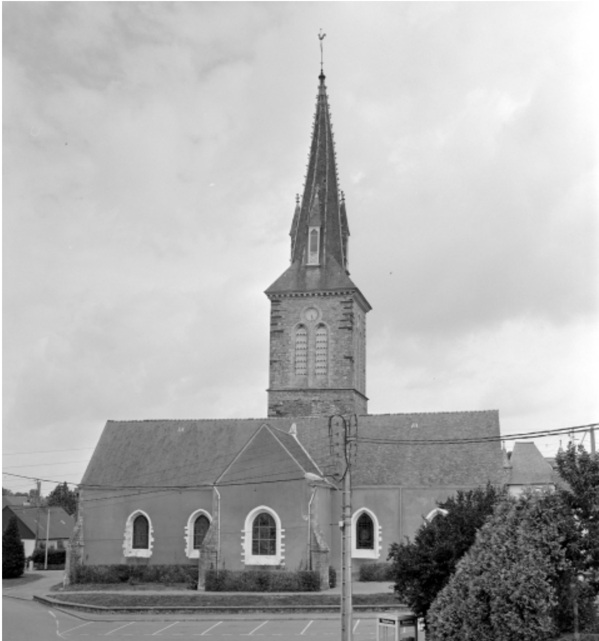
Elévation Sud : vue générale (état en 1994)
