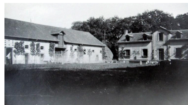
Etable et logements des ouvriers agricoles Phot. Julien Huon IVR53_20183506121NUCA
