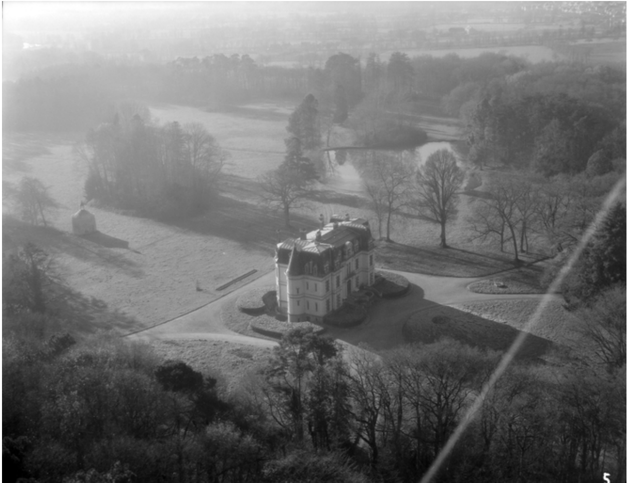
Vue aérienne, façade nord et pignon est (état en 1984)
