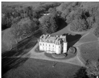
Vue aérienne de la façade sud (état en 1984) Phot. G.A.L.A.T. IVR53_19843501052V
