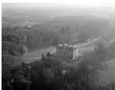
Vue aérienne de la façade nord et du pignon ouest (état en 1984) Phot. G.A.L.A.T.
