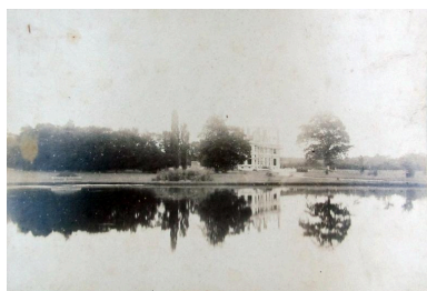
Construction du château (1888) Phot. Julien Huon IVR53_20183506115NUCA
