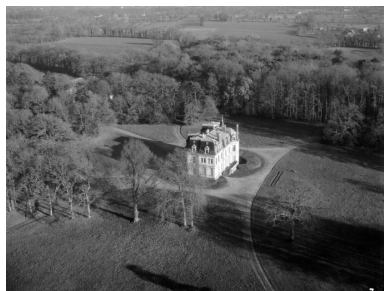
Vue aérienne de la façade sud et du pignon ouest (état en 1984) Phot. G.A.L.A.T. IVR53_19843501051V
