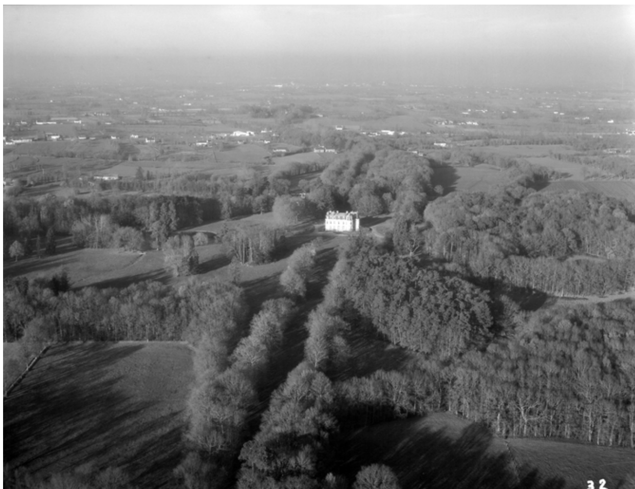
Vue aérienne du site du sud vers le nord (état en 1984)
