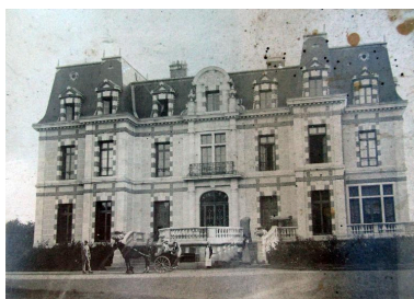
Vue générale de la façade nord (1ère moitié du 20e siècle) Phot. Julien Huon IVR53_20183506113NUCA
