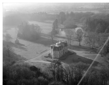
Vue aérienne, façade nord et pignon est (état en 1984) Phot. G.A.L.A.T.
