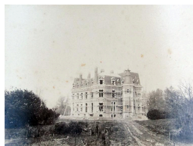
Construction du château (1888) Phot. Julien Huon IVR53_20183506111NUCA
