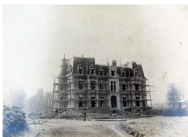
Construction du château (1888) Phot. Julien Huon IVR53_20183506110NUCA
