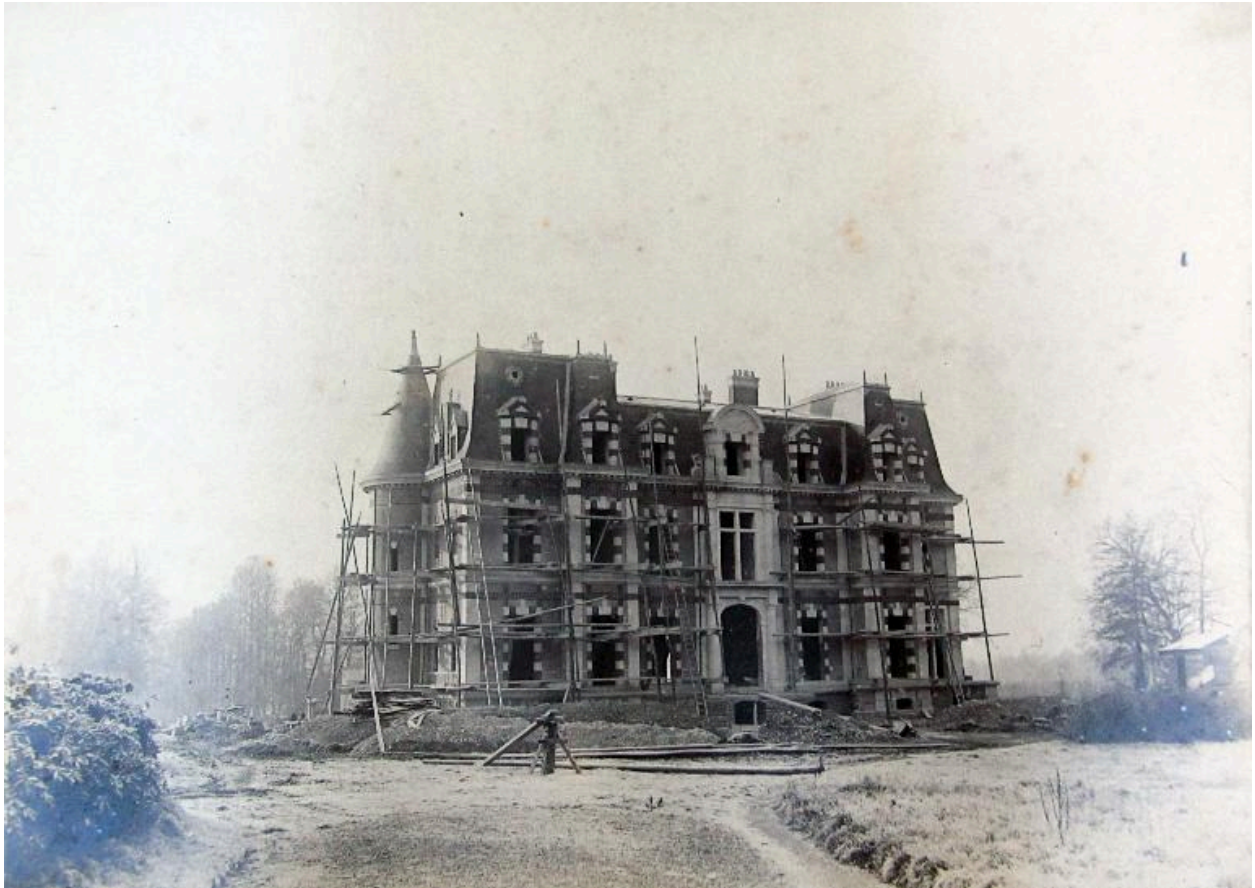
Construction du château (1888)
