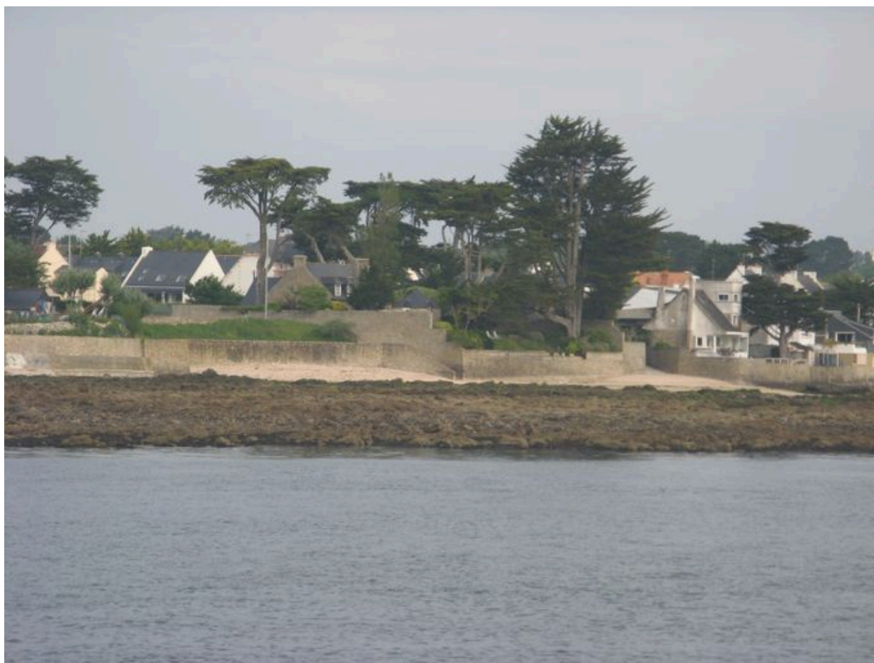
Vue de la pointe de Toulhars et de ses fortifications
