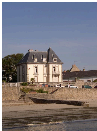
Maison de villégiature du 14 rue du Beau Rivage Phot. Johan Vincent IVR53_20065606532NUCA
