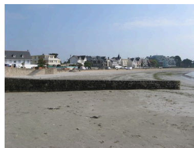
Partie orientale du front balnéaire de la plage de Toulhars Phot. Guillaume Marie IVR53_20075605593NUCA
