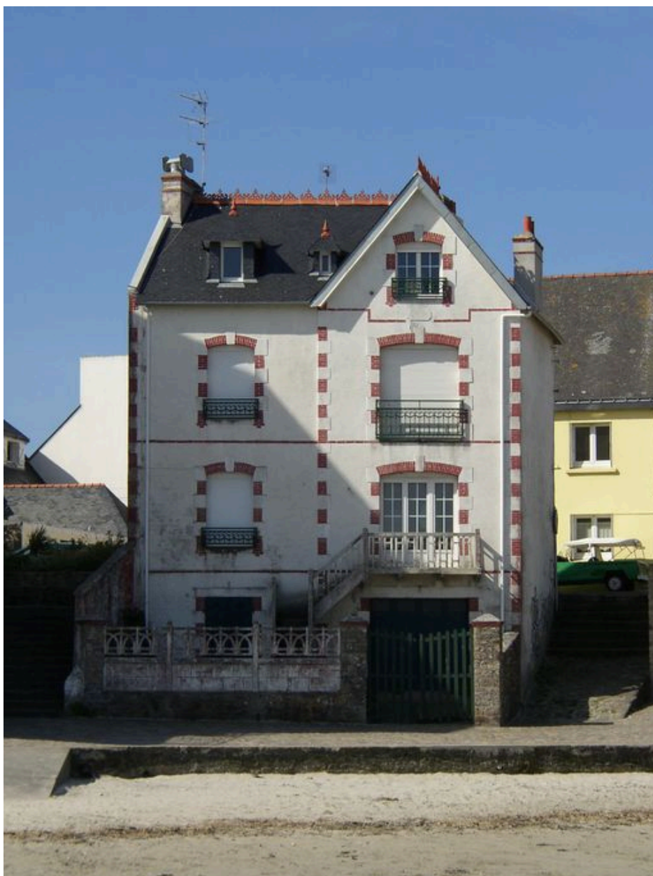
Maison de villégiature du 6 rue du Port
