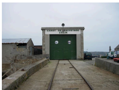
Vue générale de l'abri du canot de sauvetage Phot. Iwan Le Berre IVR53_20062908372NUCA
