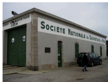
Elévation latérale de l'abri du canot de sauvetage Phot. Françoise Péron IVR53_20062908388NUCA
