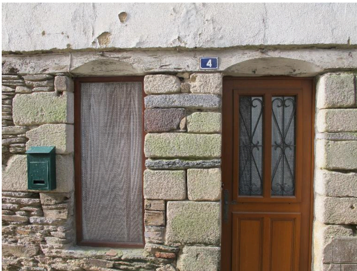
Ensemble de deux logis jumelés : une porte et une fenêtre (état en 2012)
