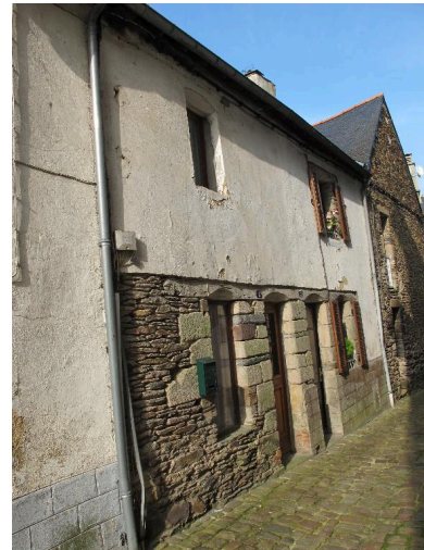
Ensemble de deux logis jumelés vus du sud-est (état en 2012) Phot. Marie-Dominique Menant IVR53_20125608242NUCA
