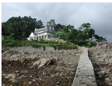
Vue de la jetée, longue de 100 m et large de 3 m, construite en 1928, qui donne accès à la villa Schueller, pointe de l'Arcouest, Phot. Guy Prigent IVR53_20082207483NUCA
