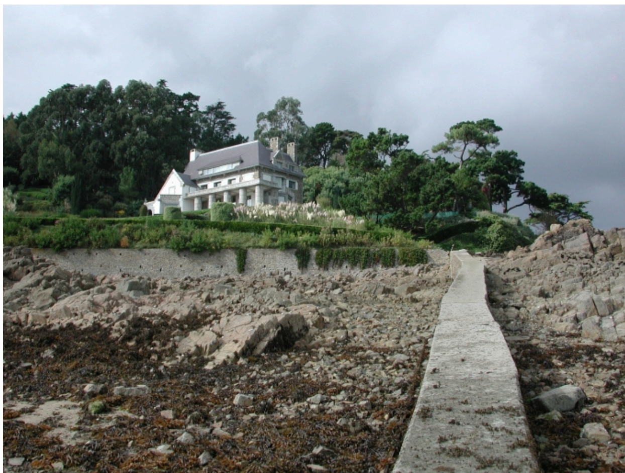
Vue de la jetée, longue de 100 m et large de 3 m, construite en 1928, qui donne accès à la villa Schueller, pointe de l'Arcouët,
