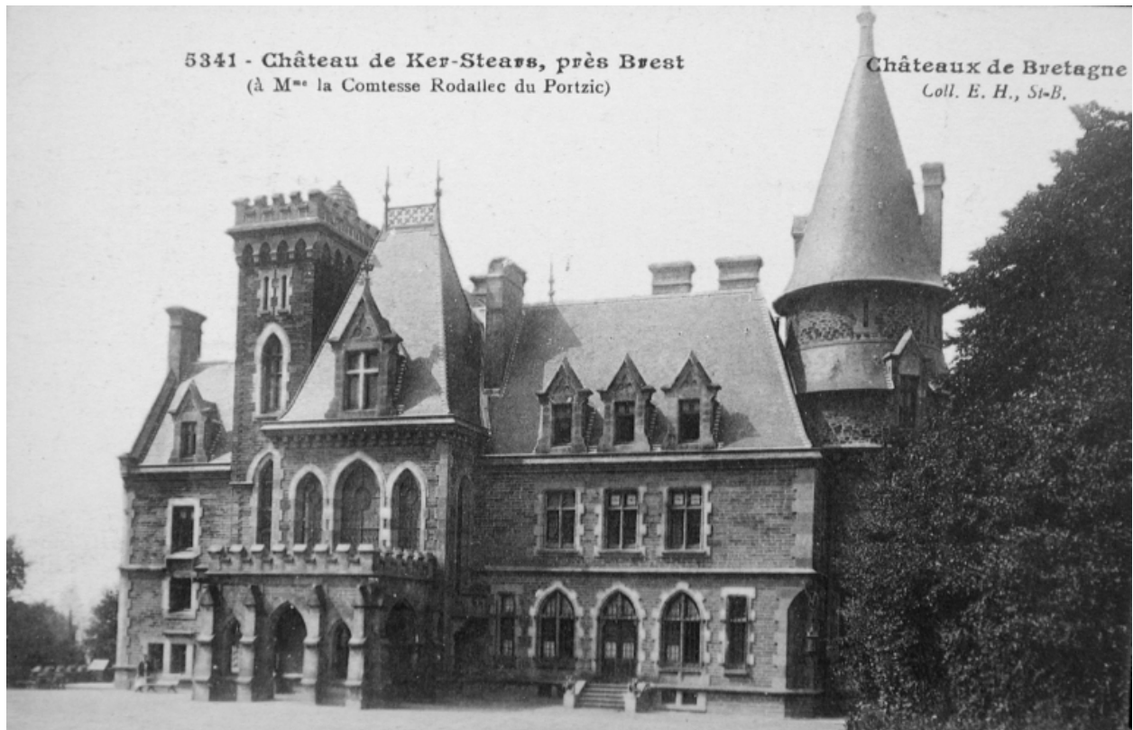
Vue générale de la façade nord (AD35, 6 Fi BREST 018)
