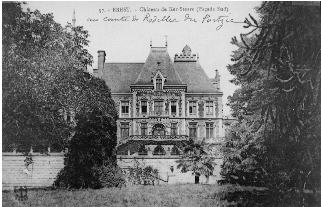
Vue générale de la façade sud (AD35, 6 Fi BREST 020)
