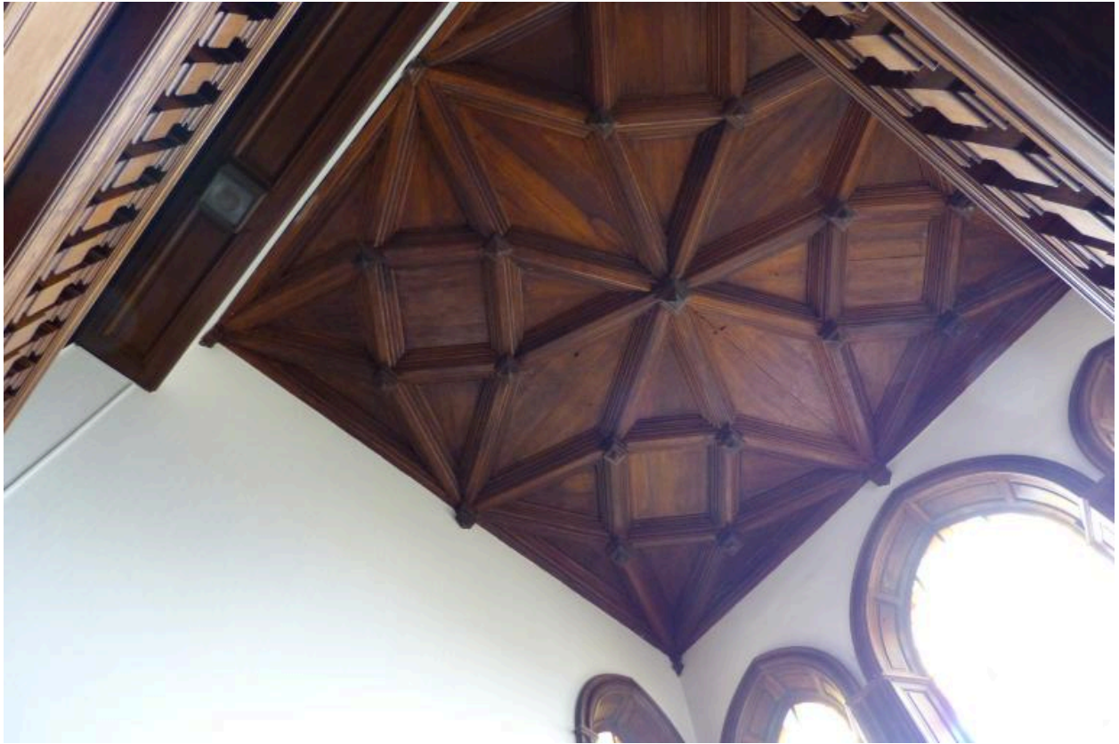
Plafond en fausse voûte du grand escalier
