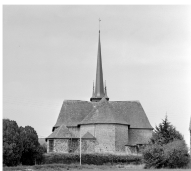
Elévation est : vue générale Phot. Guy Artur, Phot. Norbert Lambart IVR53_19943501404X
