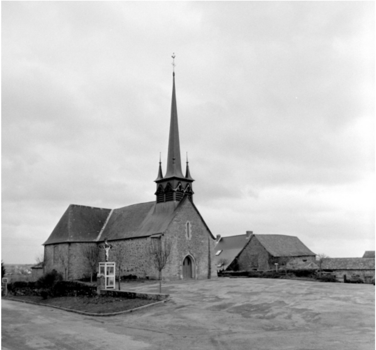
Elévation nord-ouest : vue générale
