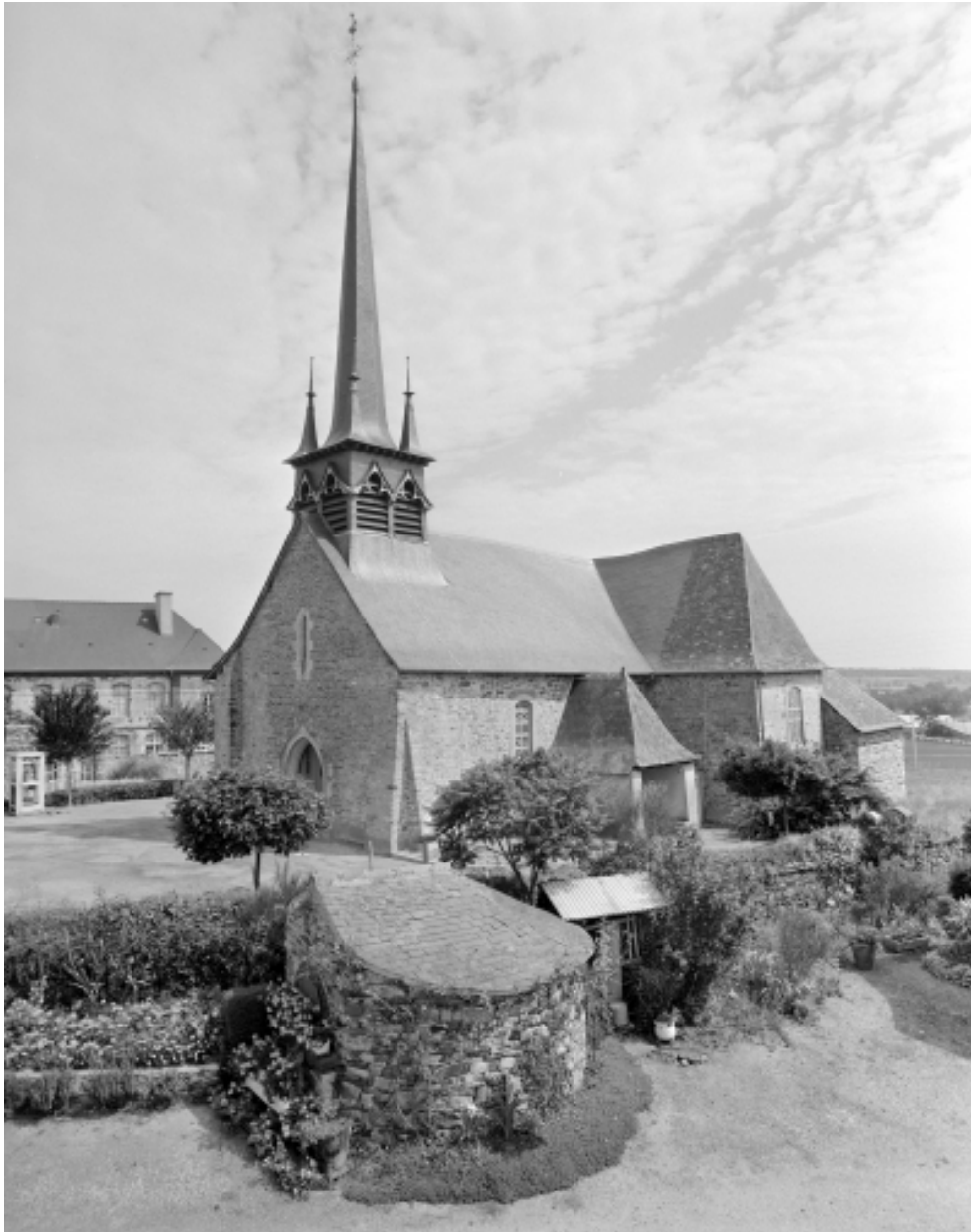
Elévation sud-ouest : vue générale
