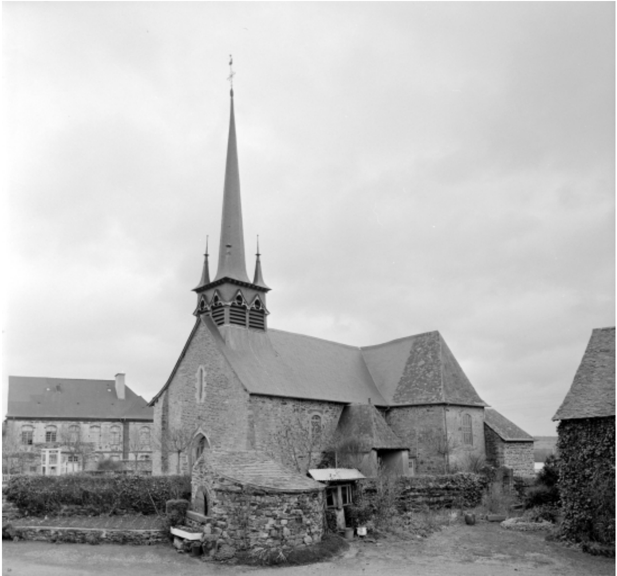
Elévation sud-ouest : vue générale
