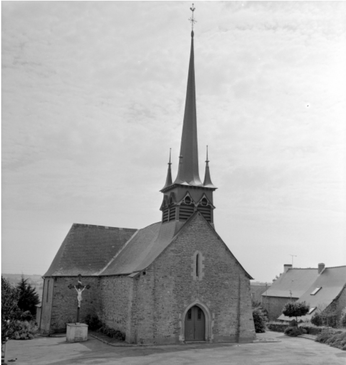
Elévation ouest : vue générale
