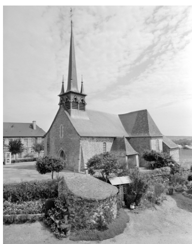
Elévation sud-ouest : vue générale Phot. Guy Artur, Phot. Norbert Lambart IVR53_19943501405X
