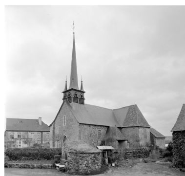
Elévation sud-ouest : vue générale Phot. Guy Artur, Phot. Norbert Lambart IVR53_19933500463X
