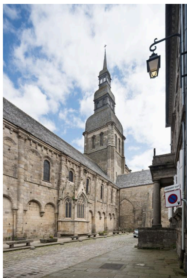
Vue du mur sud de la nef et du clocher de croisée en 2019 Phot. Delia Gaulin-Crespel IVR53_20192200608NUCA
