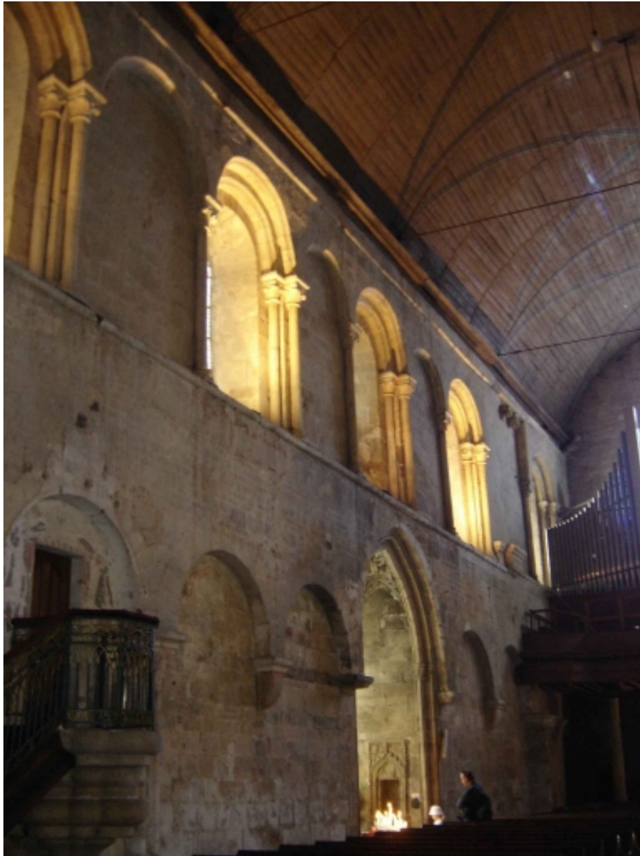
Elévation intérieure Sud de la nef, vue vers l'Ouest
