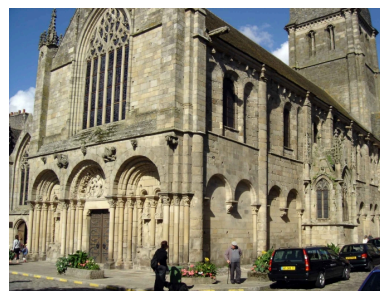
Vue d'ensemble de l'église, élévations ouest et sud en 2006 Phot. Mélanie Cros IVR53_20062212848NUCA
