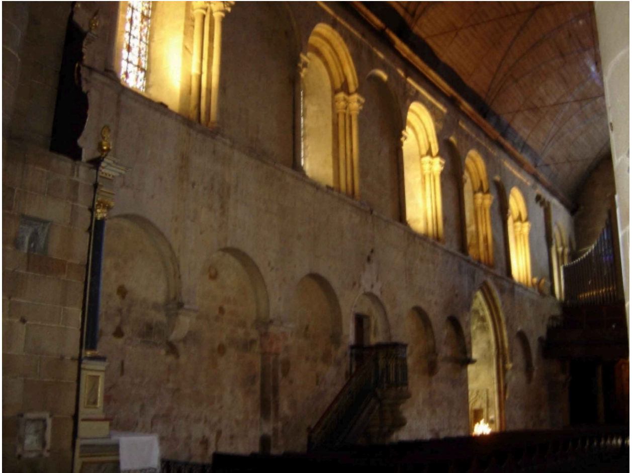
Elévation intérieure Sud de la nef, vue vers l'Ouest en 2006
