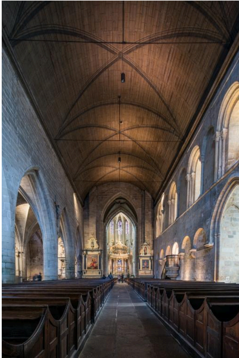
Vue générale de la nef vers le chœur
