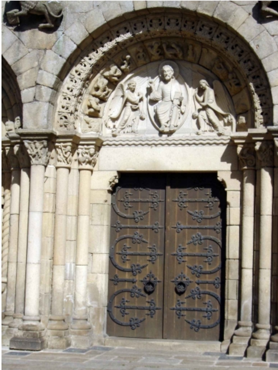
Façade occidentale : portail central en 2006
