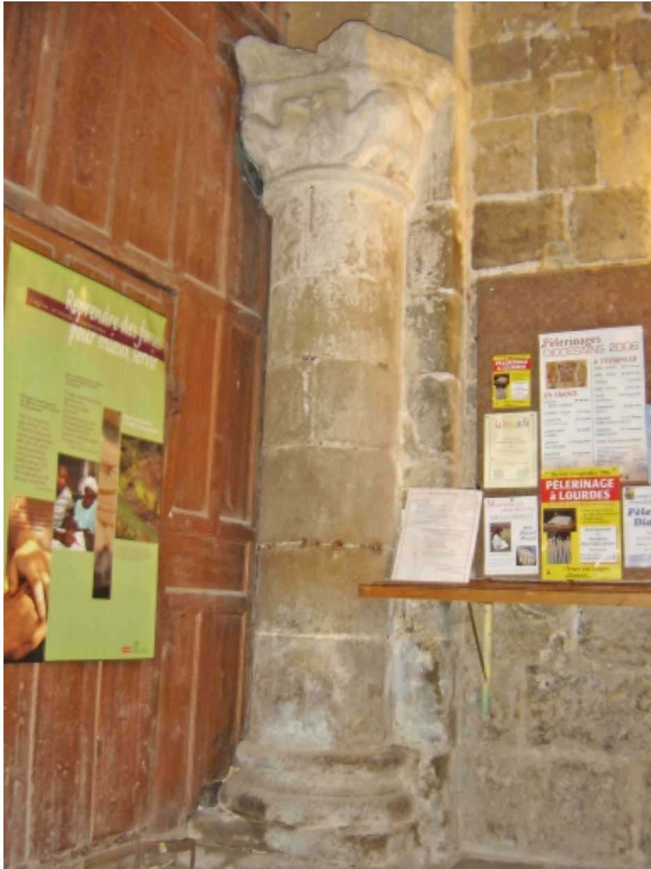
Intérieur de l'église, revers de la façade occidentale : colonne Nord
