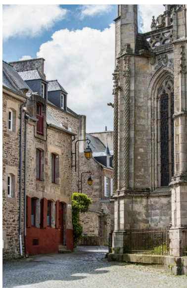
Détail des colonnettes torsées d'un contrefort du chevet Phot. Delia Gaulin-Crespel IVR53_20192200623NUCA
