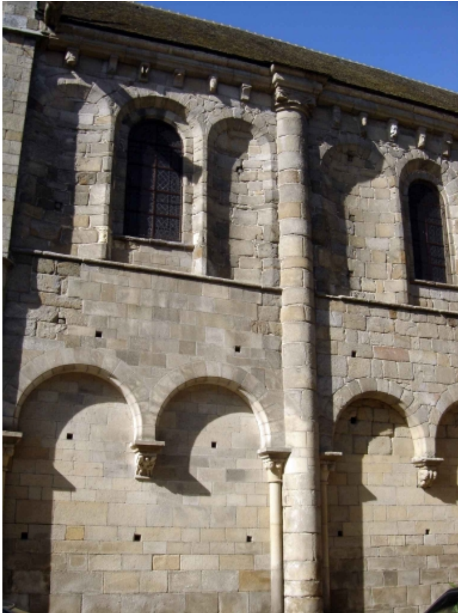
Elévation Sud : détail d'une travée en 2006
