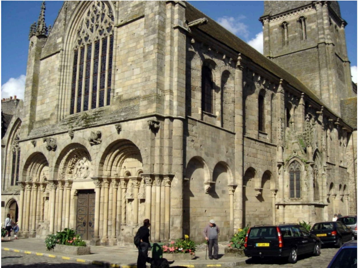
Vue d'ensemble de l'église, élévations ouest et sud en 2006
