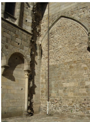
Bras de transept Sud : angle de l'élévation sud de la nef et du mur ouest Phot. Mélanie Cros IVR53_20062212852NUCA
