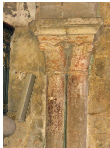
Elévation intérieure Sud : détail des colonnettes du registre inférieur Phot. Mélanie Cros IVR53_20062212862NUCA
