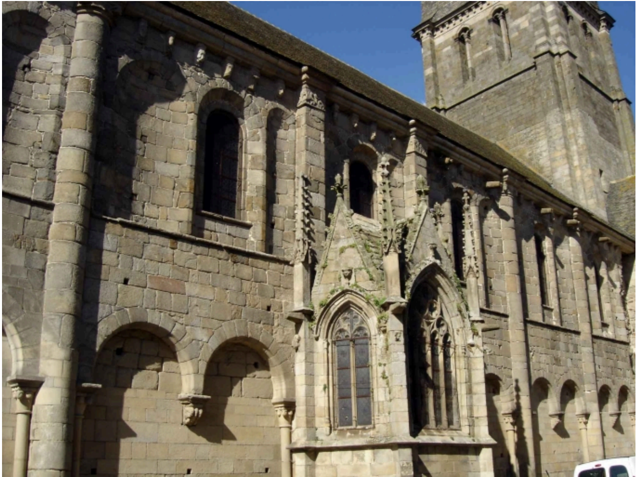
Elévation sud, vue vers l'Est
