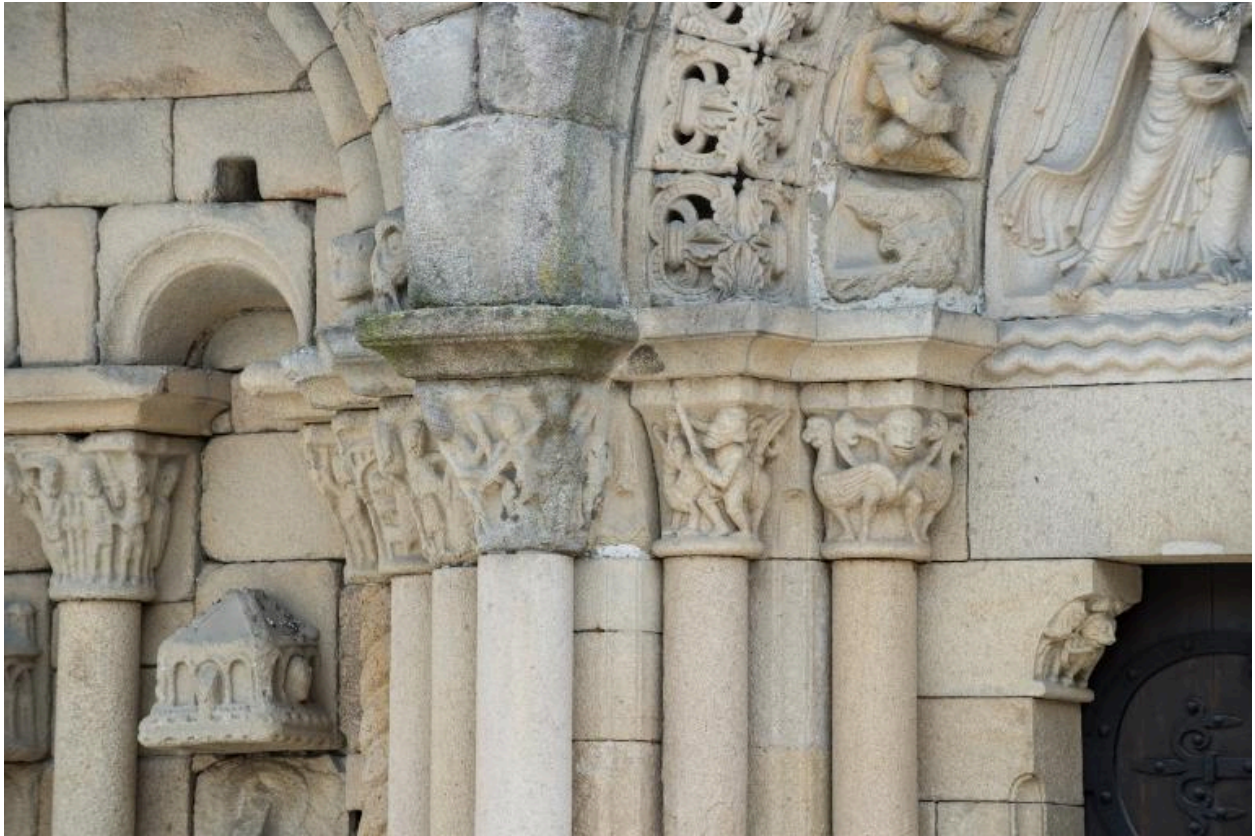
Détail des chapiteaux de la façade ouest
