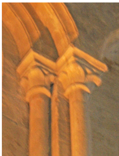
Elévation intérieure Sud de la nef : chapiteaux des colonnettes du registre supérieur Phot. Mélanie Cros IVR53_20062212863NUCA
