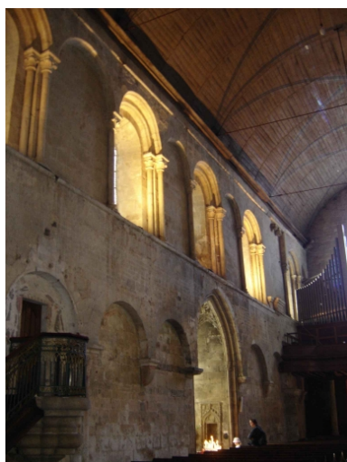
Elévation intérieure Sud de la nef, vue vers l'Ouest Phot. Mélanie Cros IVR53_20062212864NUCA
