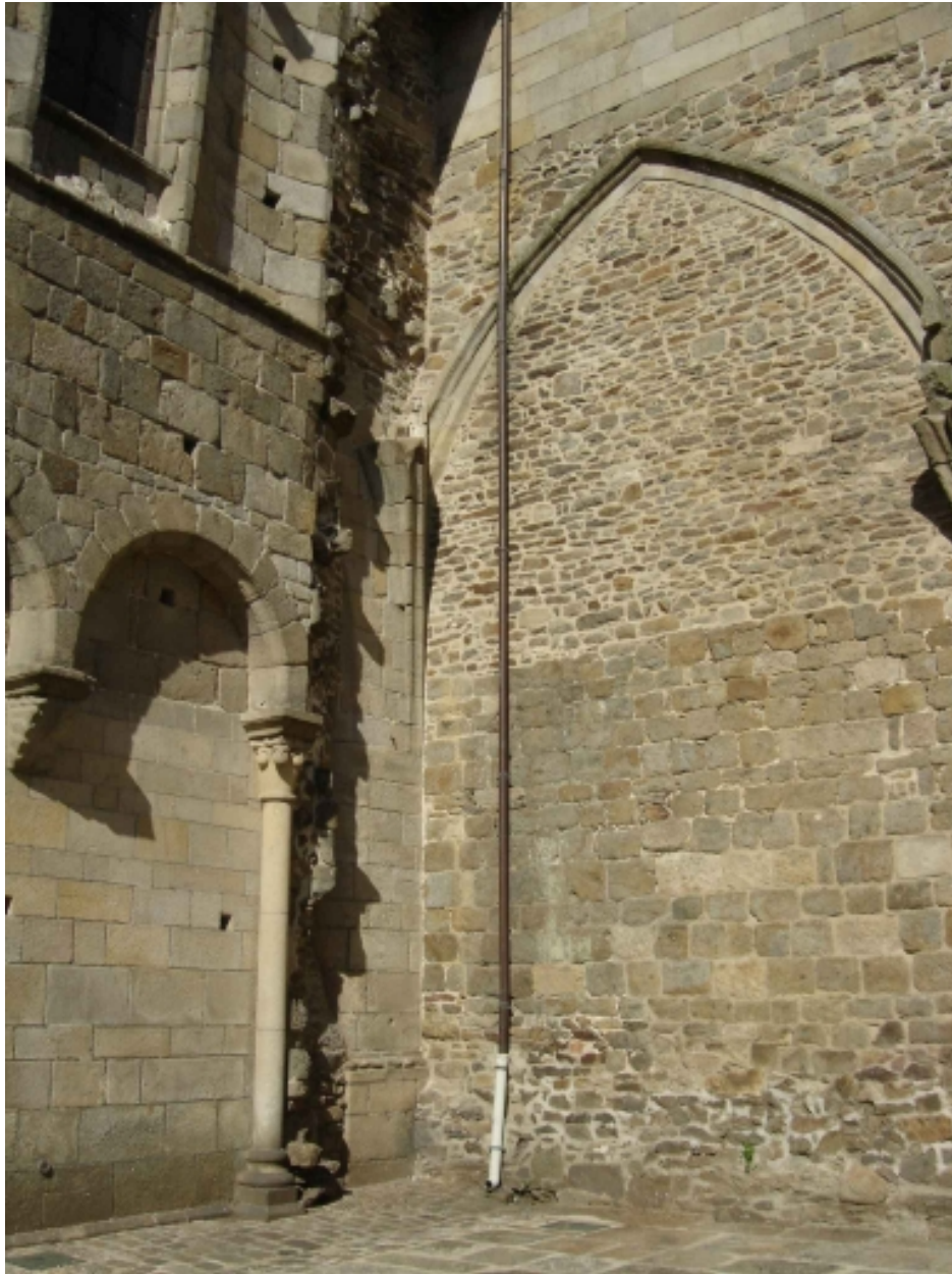
Bras de transept Sud : angle de l'élévation sud de la nef et du mur ouest
