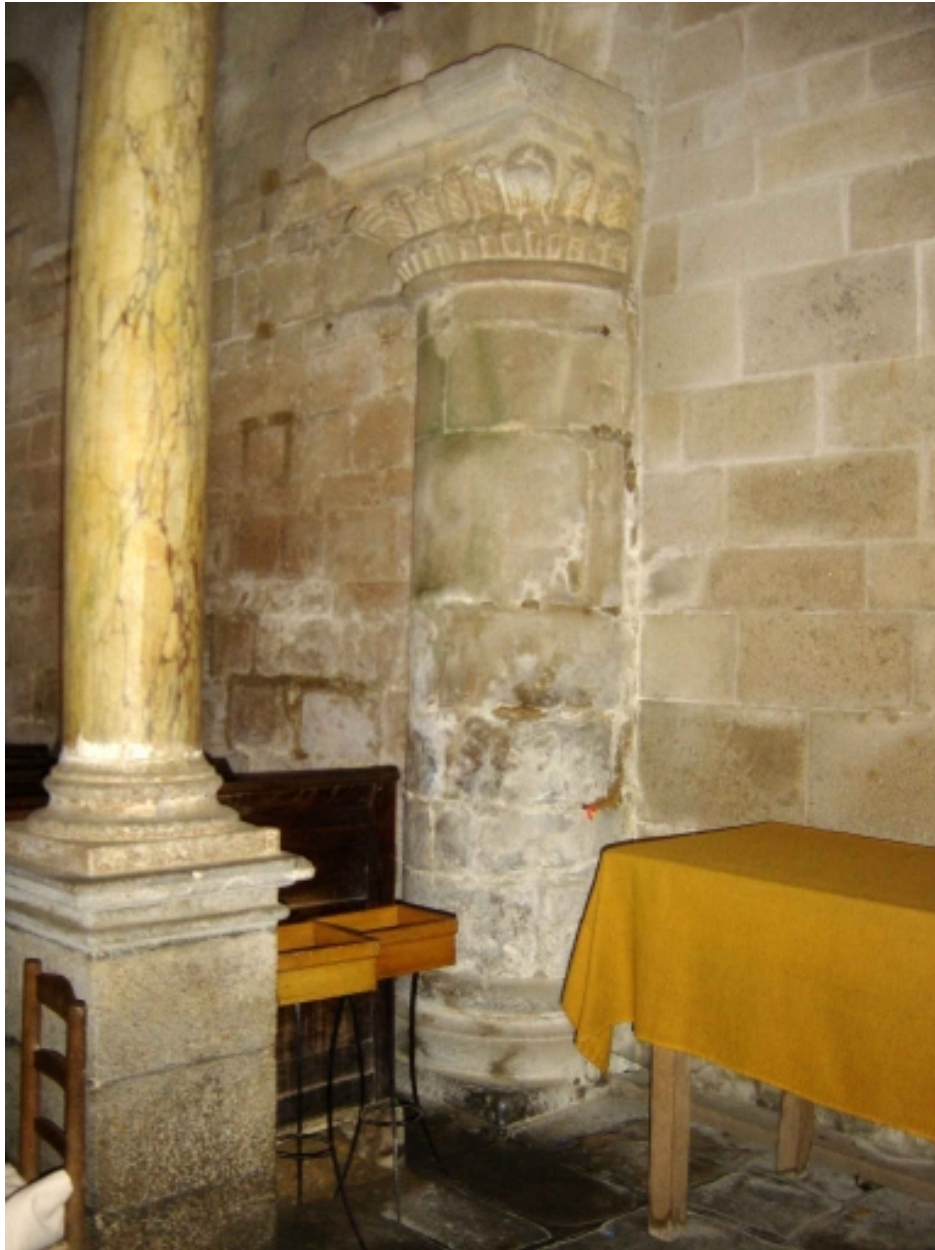
Elévation intérieure Sud, 1ère travée : colonne engagée
