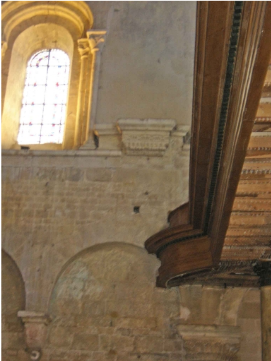
Elévation intérieure Sud de la nef : détail de la 1ère travée
