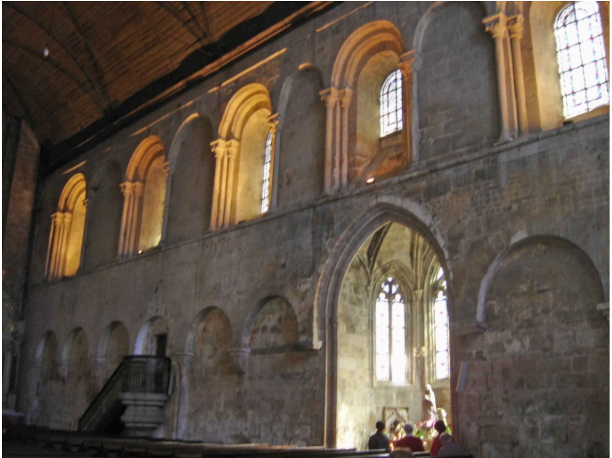
Elévation intérieure Sud de la nef, vue vers l'Est
