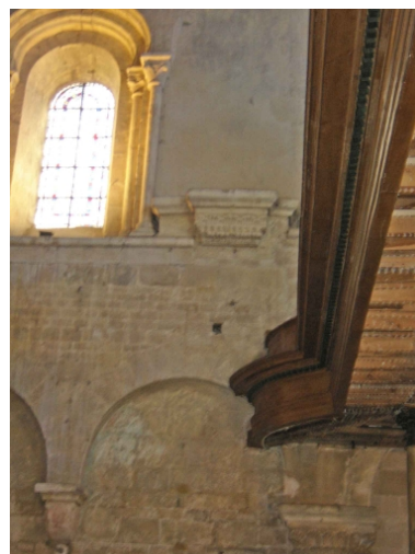
Elévation intérieure Sud de la nef : détail de la 1ère travée Phot. Mélanie Cros IVR53_20062212868NUCA
