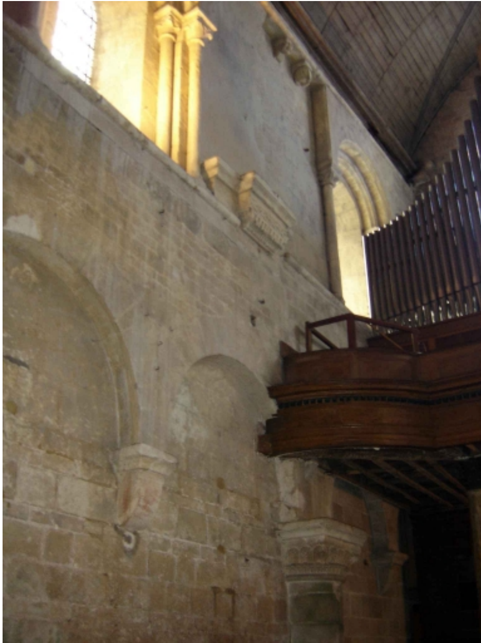
Elévation intérieure Sud, travées occidentales de la nef
