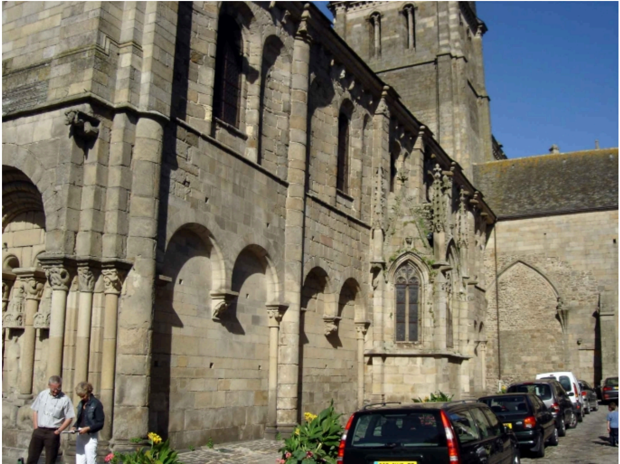
Elévation Sud, vue de l'angle Sud-Ouest en 2006
