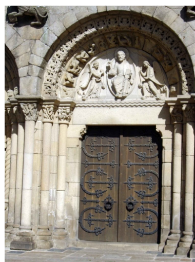
Façade occidentale : portail central en 2006 Phot. Mélanie Cros IVR53_20062212845NUCA
