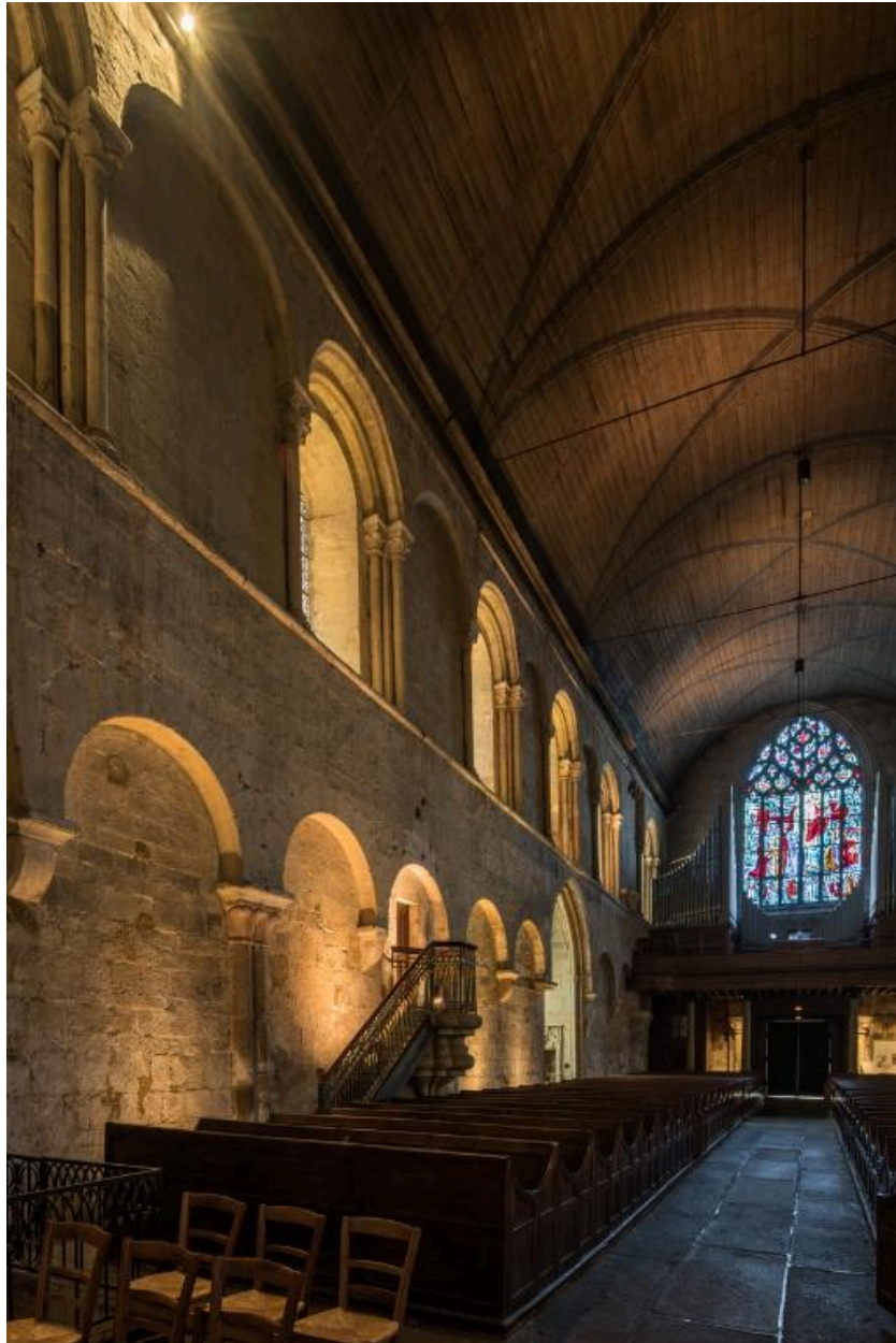
Intérieur, mur sud de la nef, vue en enfilade vers l'ouest
