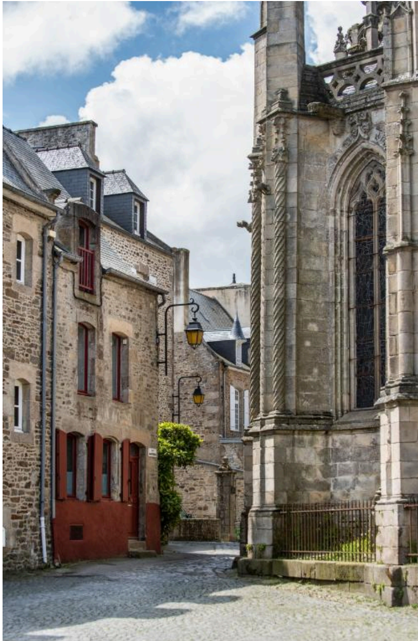
Détail des colonnettes torses d'un contrefort du chevet
