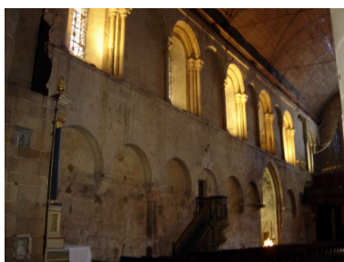
Elévation intérieure Sud de la nef, vue vers l'Ouest en 2006 Phot. Mélanie Cros IVR53_20062212866NUCA
