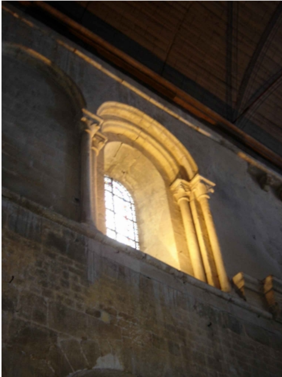
Elévation intérieure Sud : détail d'une baie du registre supérieur
