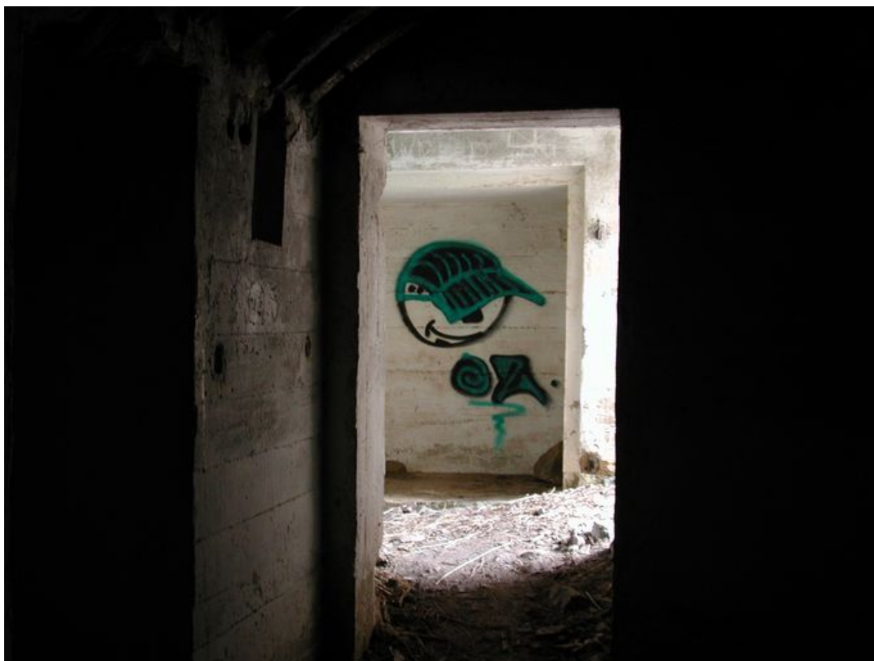
Vue intérieure : porte donnant sur le couloir d'accès et son tag (état en 2002)
