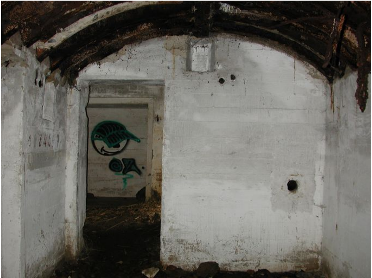
Vue intérieure (état en 2002). Il s'agit d'un abri type "tôle métro": porte donnant sur le couloir d'accès ; au centre en haut, niche murale (à lumière) et entrée/sortie de tuyau ; à gauche, peinture murale (numérotation)
