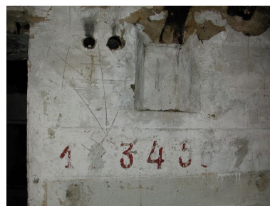
Vue intérieure : peinture murale (numérotation des armes placée au-dessus du râtelier situé à l'entrée de l'abri) et niche murale (état en 2002). A signaler, la présence de graffitis gravés dans le béton : croix de Lorraine associée à la lettre V (Victoire) et croix gammées Phot. Guillaume Lécueillier IVR53_20022901748NUCA
