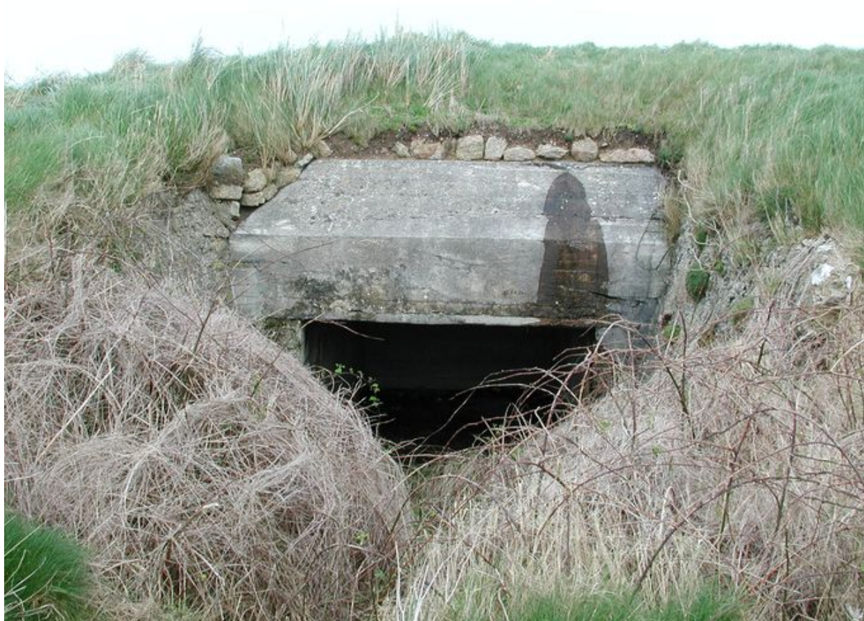
Vue de l'entrée du garage pour canon (bunker type VF5a ?) (état en 2002)
