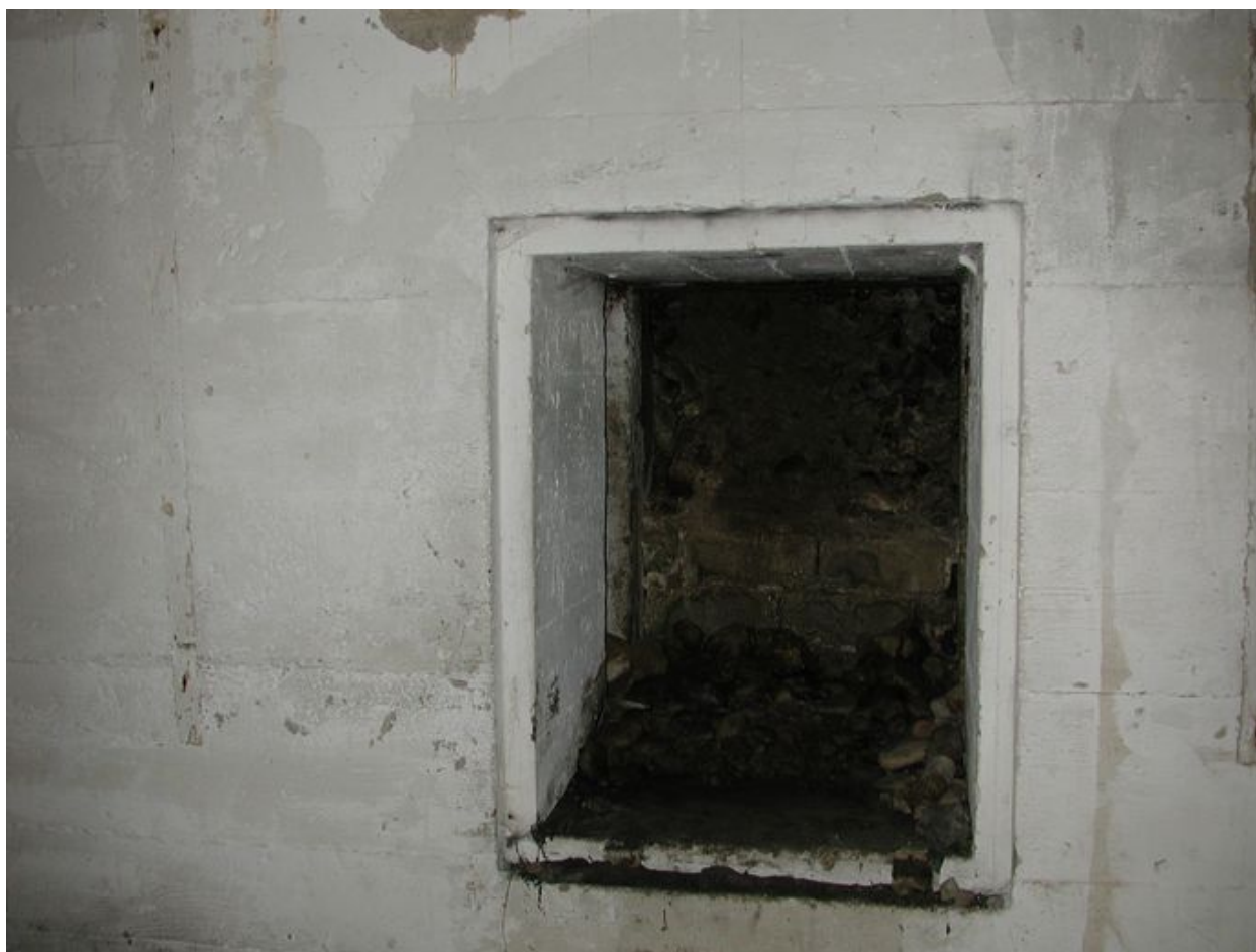
Vue intérieure : sortie de secours (état en 2002)
