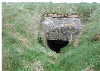
Vue de l'entrée ouest (état en 2002) Phot. Guillaume Lécueillier IVR53_20022901741NUCA
