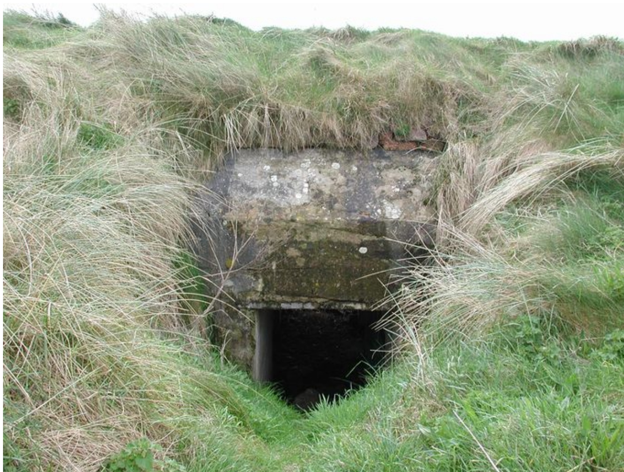
Vue de l'entrée est (état en 2002)
