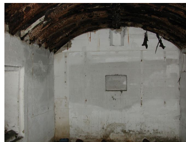
Vue intérieure (état en 2002). Il s'agit d'un abri type "tôle métro" : au fond de la pièce, deux niches murales ; à gauche, la sortie de secours Phot. Guillaume Lécueillier IVR53_20022901744NUCA
