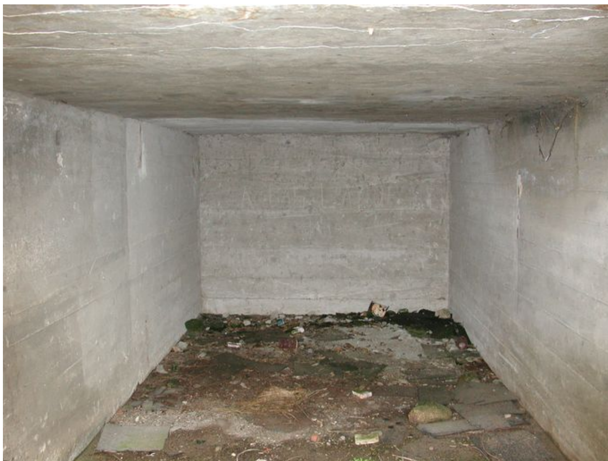
Vue intérieure du garage pour canon (bunker type VF5a ?) (état en 2002)
