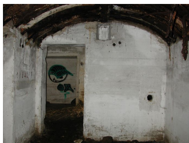
Vue intérieure (état en 2002). Il s'agit d'un abri type "tôle métro" : porte donnant sur le couloir d'accès ; au centre en haut, niche murale (à lumière) et entrée/sortie de tuyau ; à gauche, peinture murale (numérotation) Phot. Guillaume Lécueillier IVR53_20022901745NUCA
