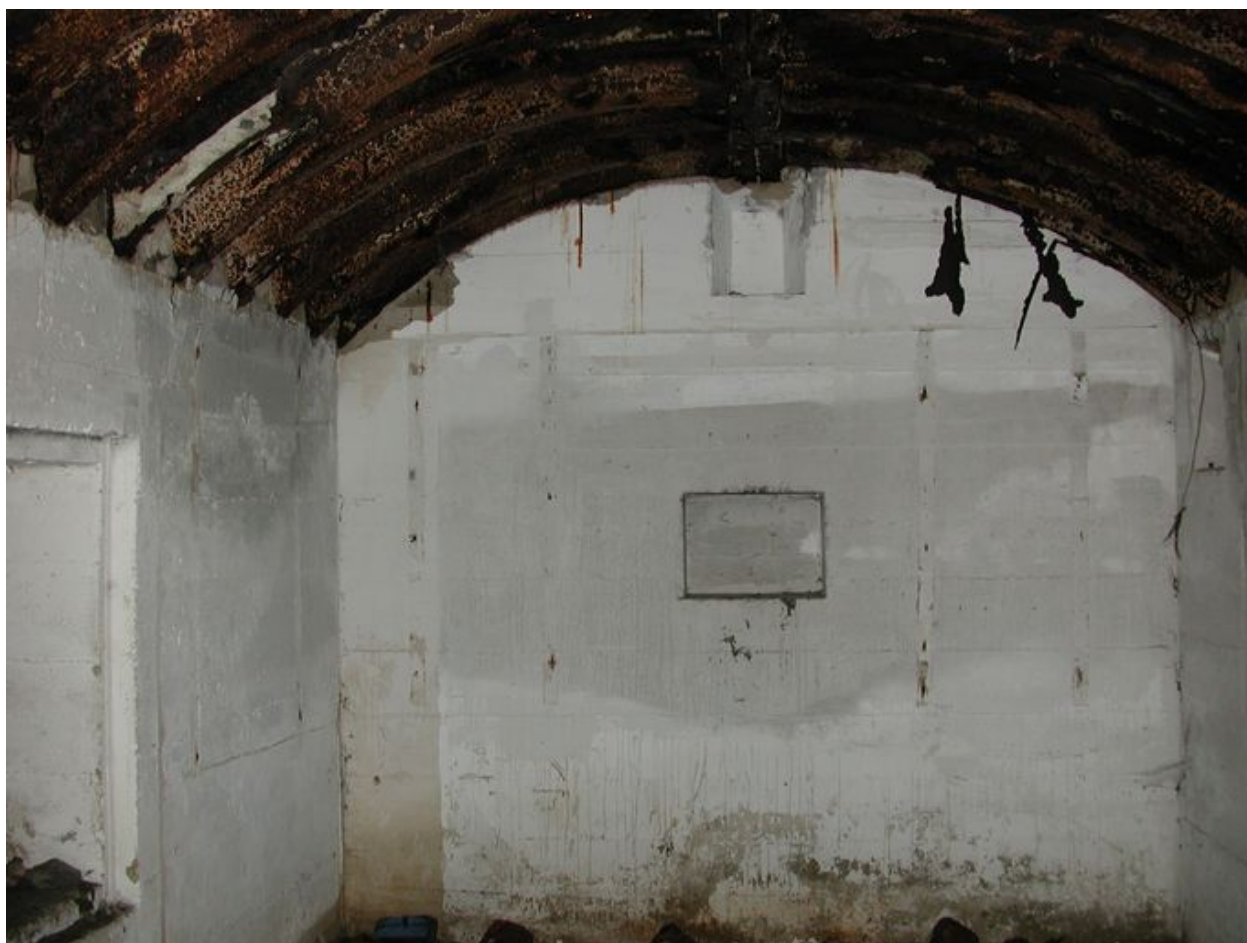
Vue intérieure (état en 2002). Il s'agit d'un abri type "tôle métro" : au fond de la pièce, deux niches murales ; à gauche, la sortie de secours
