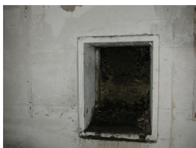
Vue intérieure : sortie de secours (état en 2002) Phot. Guillaume Lécueillier IVR53_20022901746NUCA
