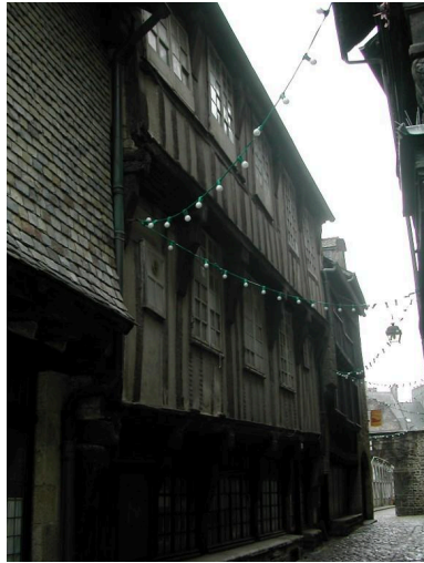
Façade en pan de bois en encorbellement, plusieurs fois reprise.
