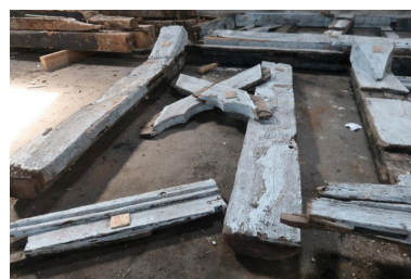
Eléments composant une porte trilobée d'un étage de la façade sud de la maison de Saint-Dinan, déposés après son incendie en 2019.
