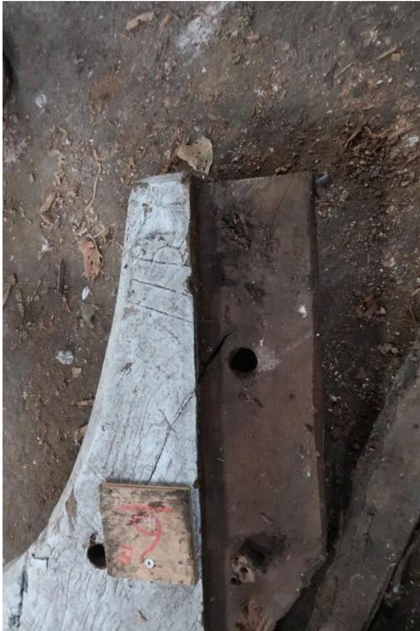
Marque de charpentier tracé à la reinette sur un élément en bois déposé après l'incendie en 2019 de la maison de Saint-Dinan.
