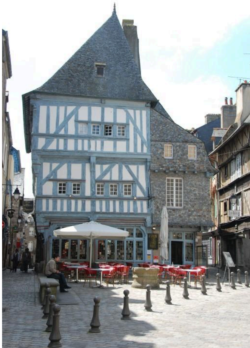
Maison d'angle dont les étages en encorbellement sont contreventés par des écharpes et potelets.
