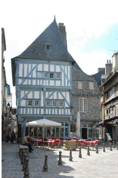
Maison d'angle dont les étages en encorbellement sont contreventés par des écharpes et potelets.
