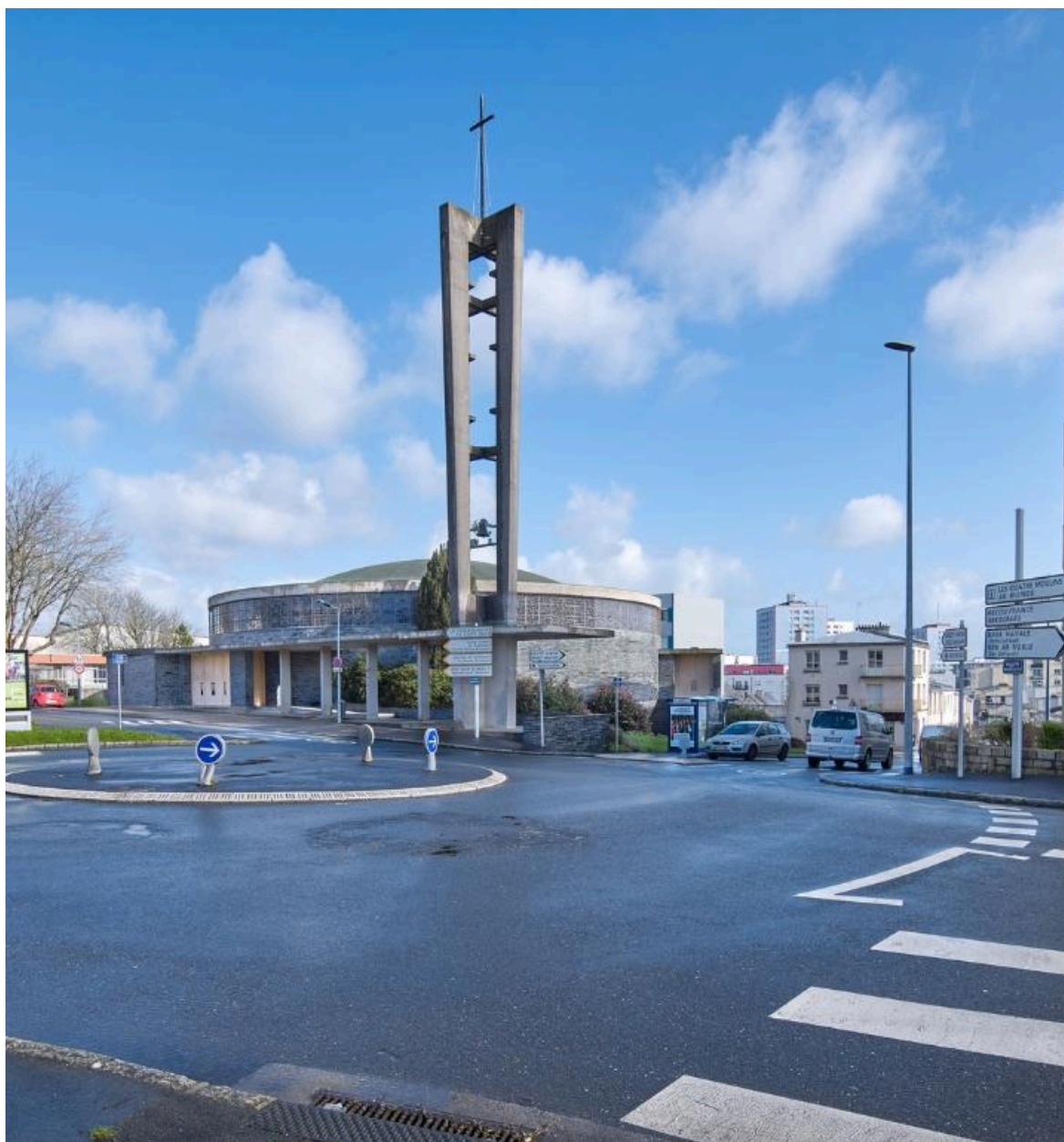
Eglise Sainte-Thérèse, Le Landais : vue générale, depuis le sud-ouest
