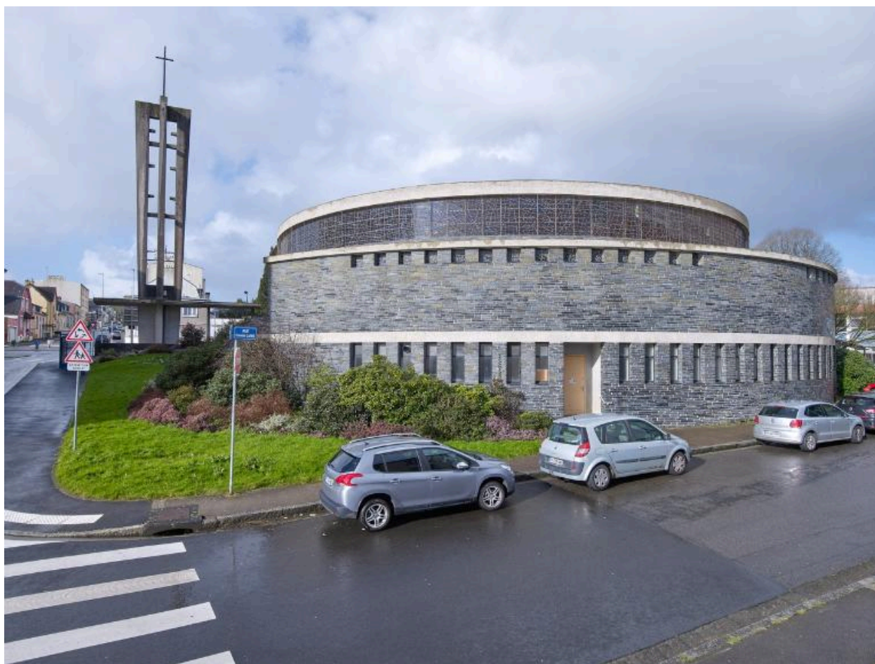
Eglise Sainte-Thérèse, Le Landais : vue générale depuis le sud
