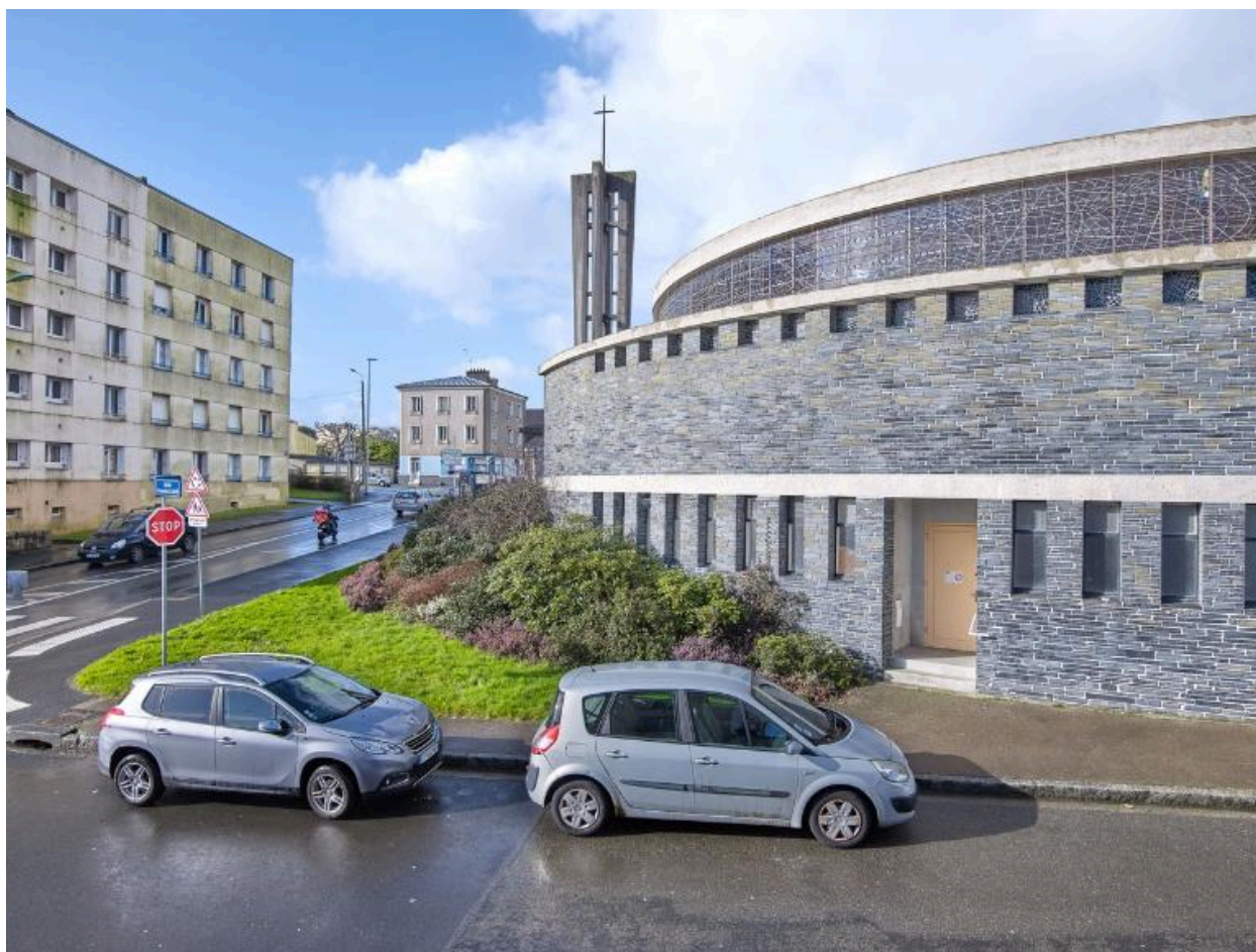
Eglise Sainte-Thérèse, Le Landais : vue depuis le sud, parement en schiste, bandeau de béton et verrières
