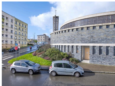
Eglise Sainte-Thérèse, Le Landais : vue depuis le sud, parement en schiste, bandeau de béton et verrières Phot. Bernard Bègne IVR53_20202900075NUCA
