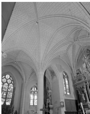
Voûtes du chœur, vue oblique des deux fermières travées.
