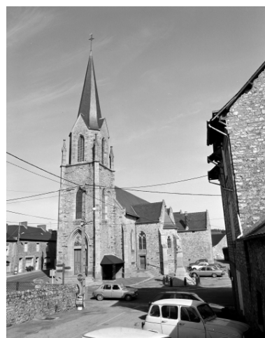
Vue générale ouest. Phot. Guy Artur, Phot. Norbert Lambart IVR53_19873500342X
