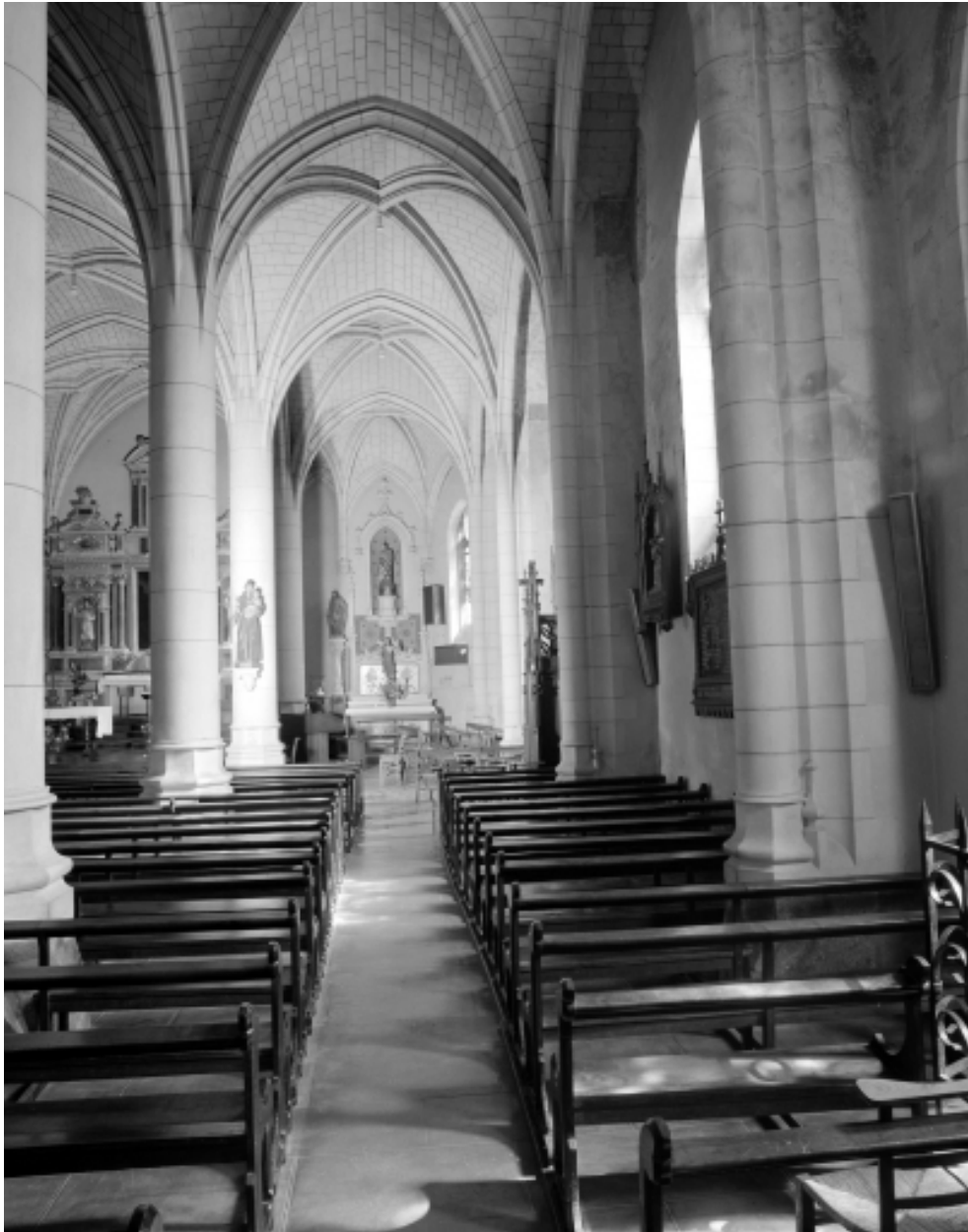
Bas-côté sud, vue générale vers l'est.
