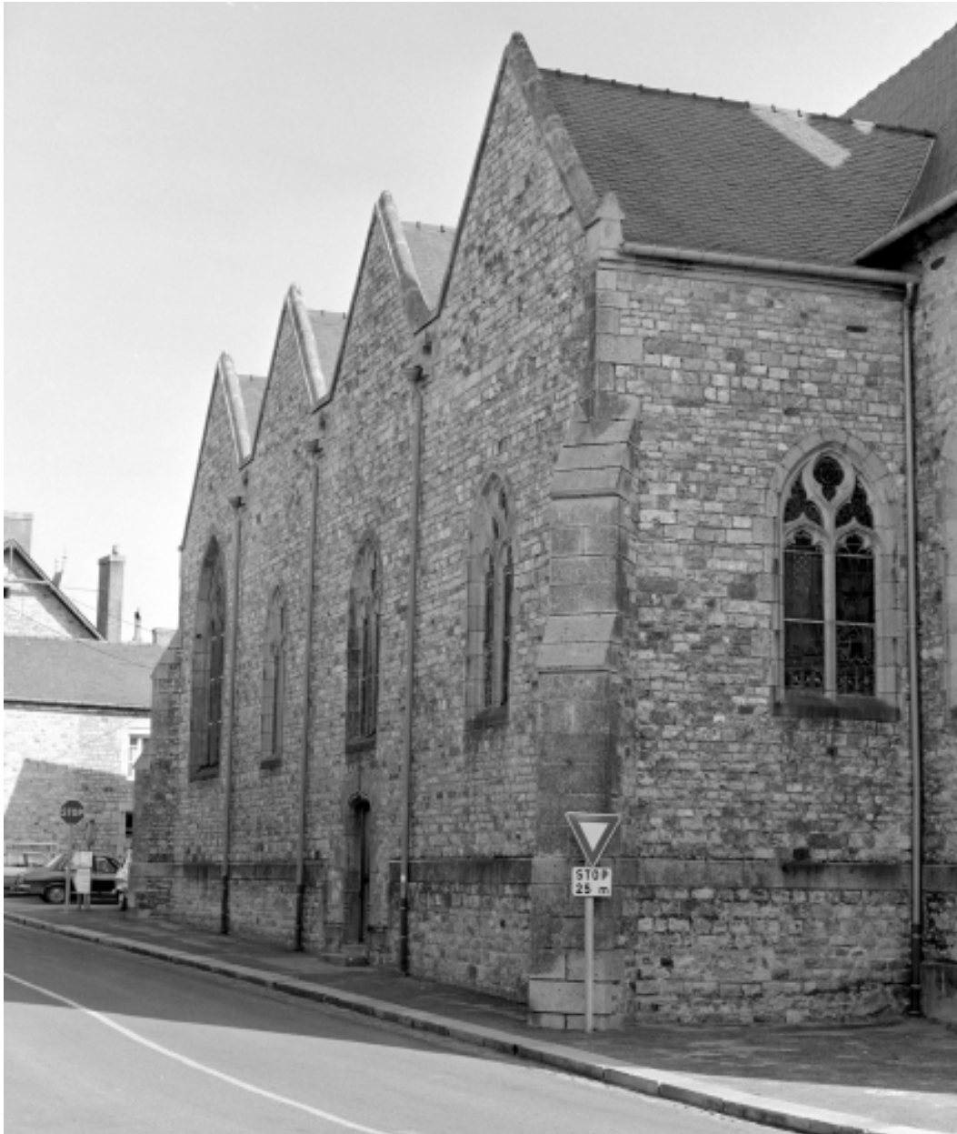
Vue générale nord-ouest, pignon de l'élévation nord.
