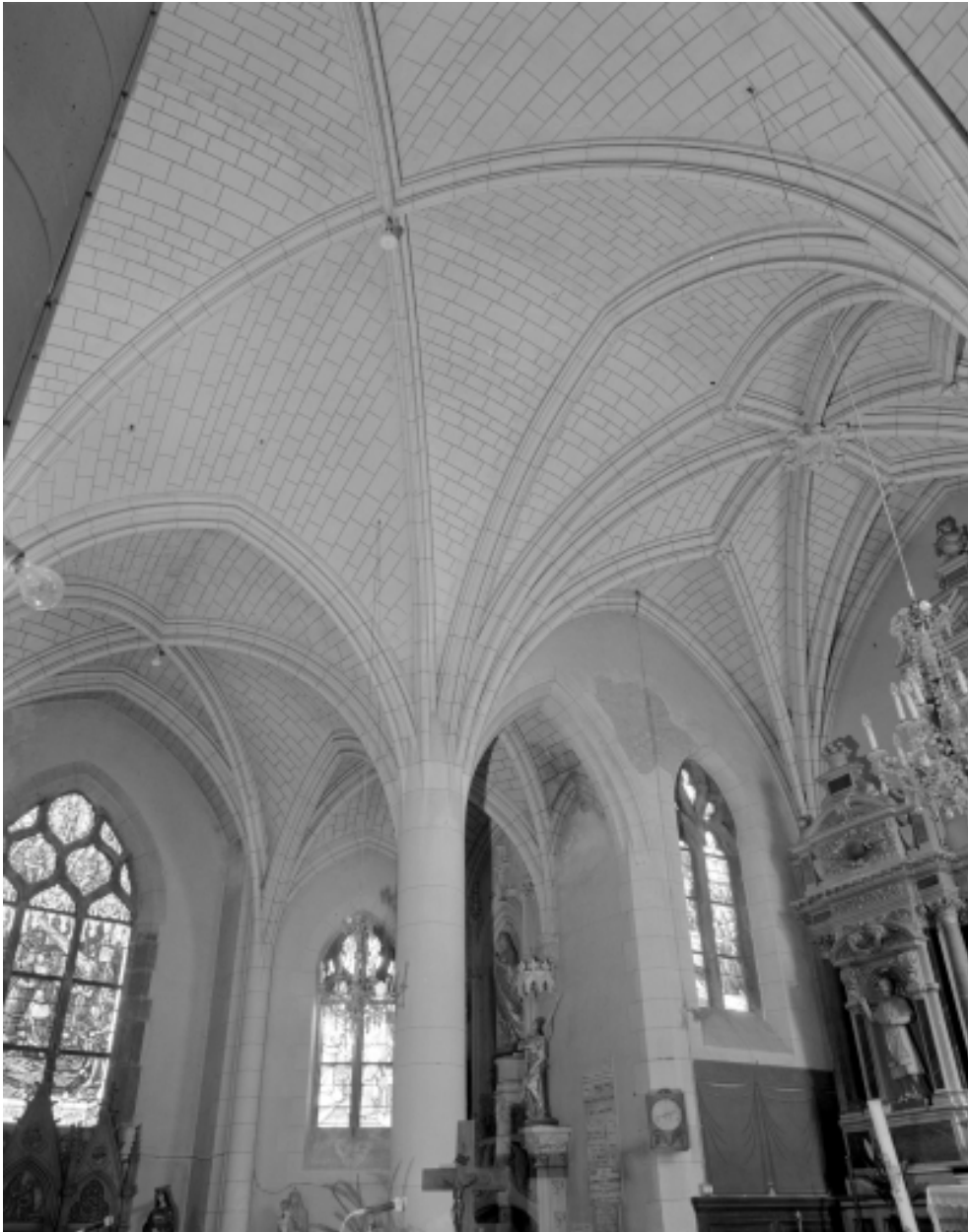
Voûtes du choeur, vue oblique des deux fermières travées.
