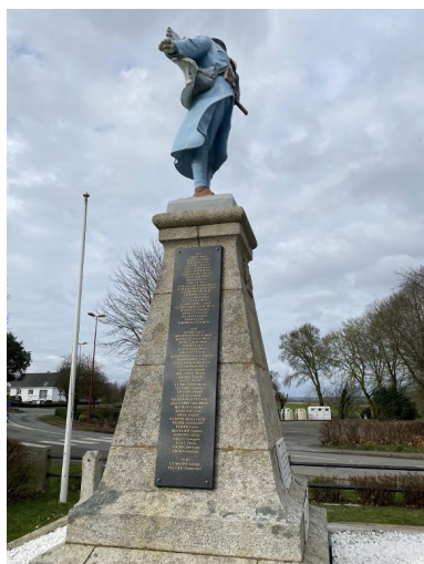
Vue sud Phot. Baptiste Oligo IVR53_20255610681NUCA
