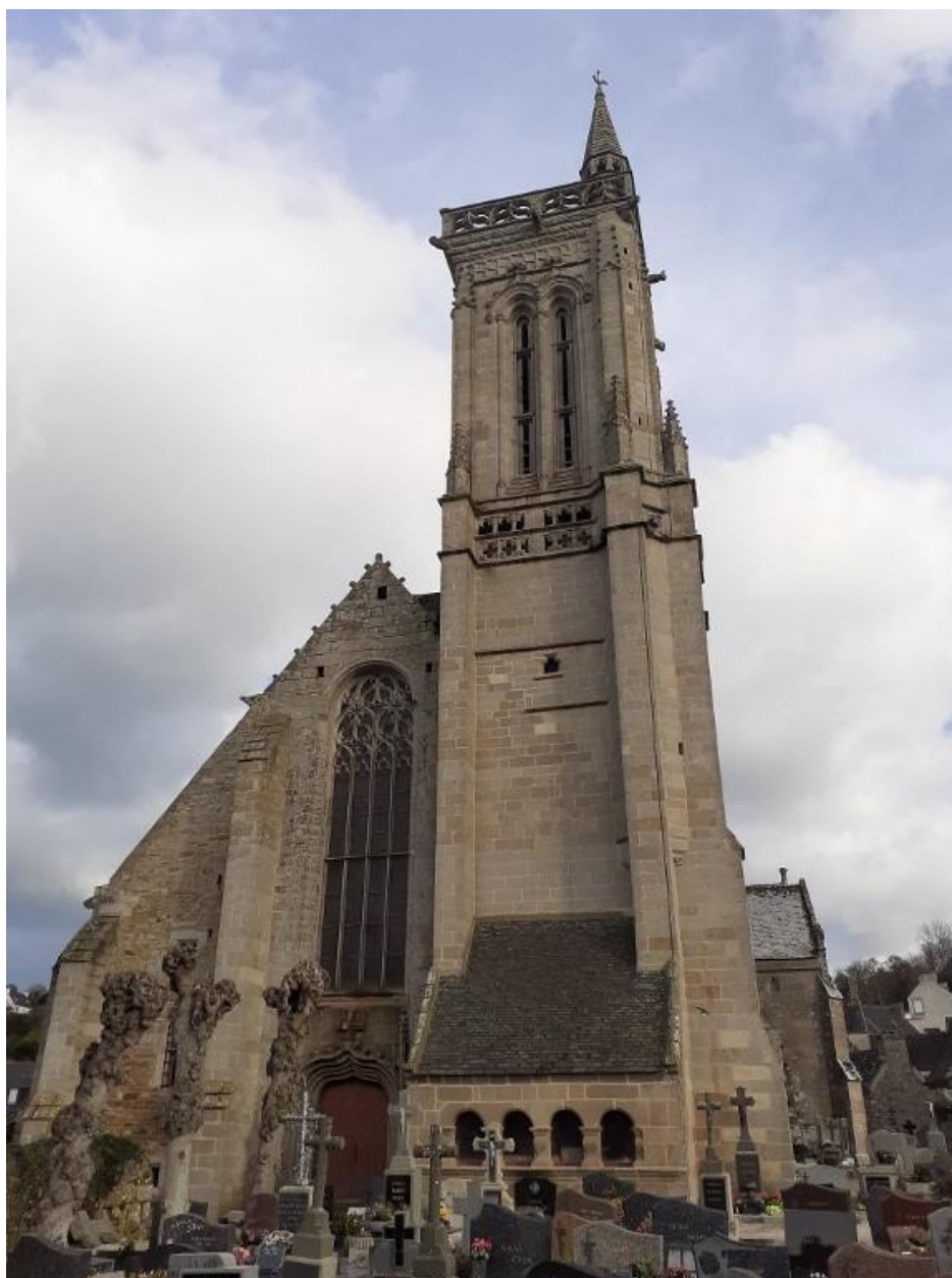
Façade ouest avec clocher et ossuaire d'attache
