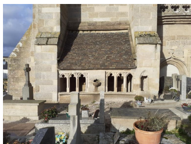
Ossuaire d'attache sud, vue de face Phot. Valentine Guillevic IVR53_20252910714NUCA
