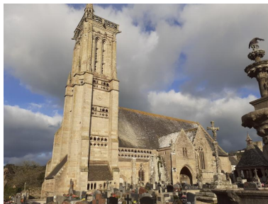
Vue depuis le sud-ouest avec le clocher, les ossuaires d'attache, le porche sud, la croix de cimetière et l'oratoire Phot. Valentine Guillevic IVR53_20232930472NUCA
