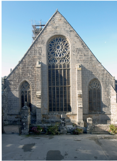
Vue du chevet Phot. Alain Dagorn IVR53_20082900198NUCA
