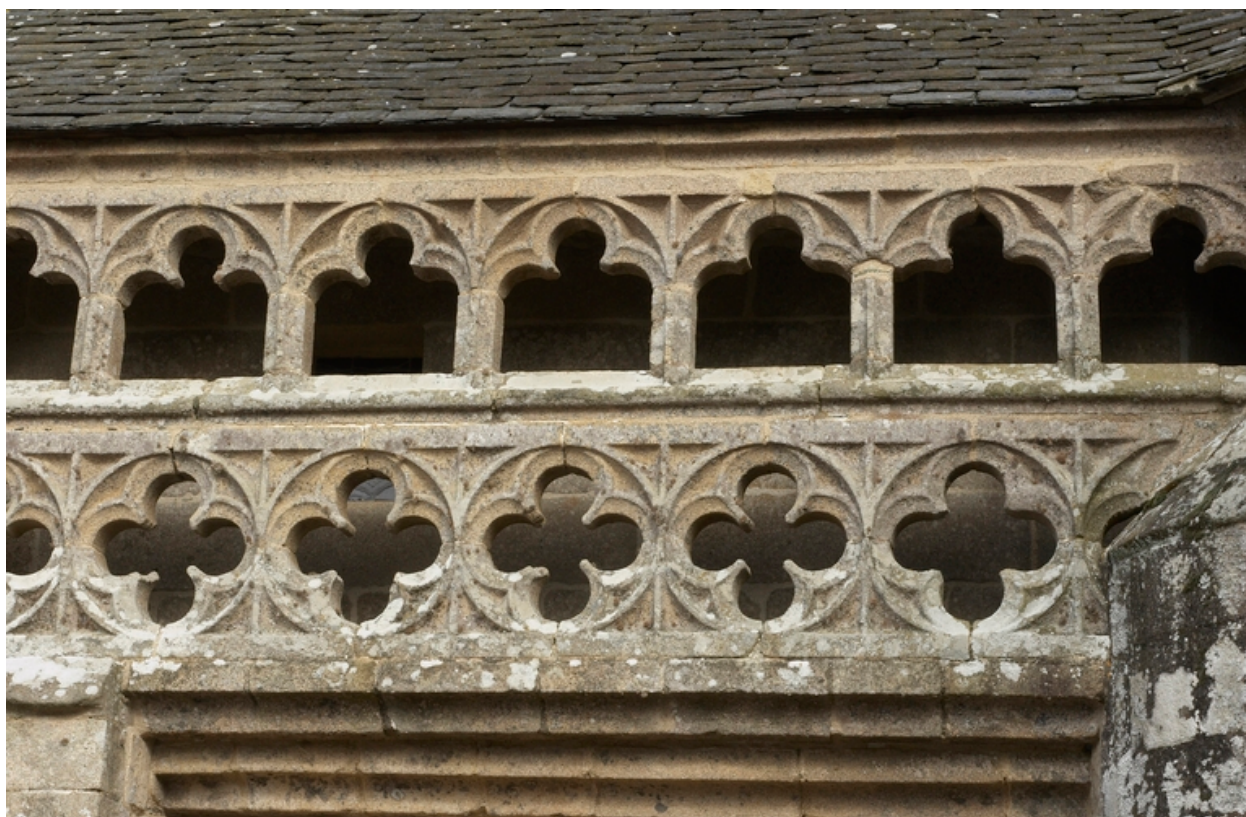
Vue de la coursière entre le porche sud et le clocher
