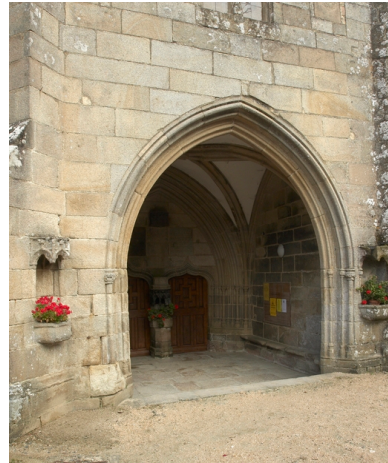
Vue rapprochée du porche sud Phot. Alain Dagorn IVR53_20082900192NUCA
