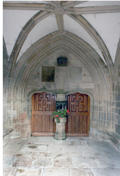
Intérieur du porche sud Phot. Alain Dagorn IVR53_20082900193NUCA
