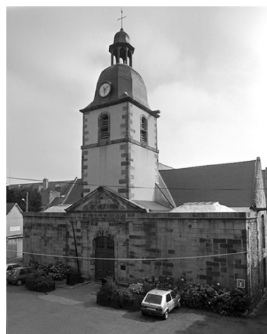
Vue générale ouest Phot. Guy Artur, Phot. Norbert Lambart IVR53_19943501912X
