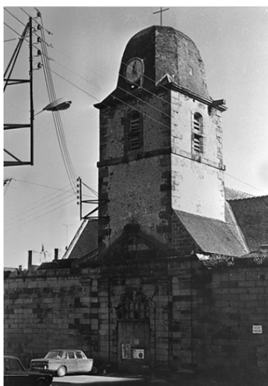
Etat de la façade ouest en 1979 Repro. Guy Artur, Repro. Norbert Lambart IVR53_20003500412X
