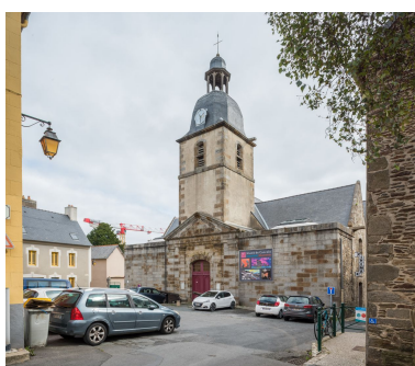
Vue générale de la façade occidentale depuis la place voisine Phot. Charlotte Barraud IVR53_20223501084NUCA
