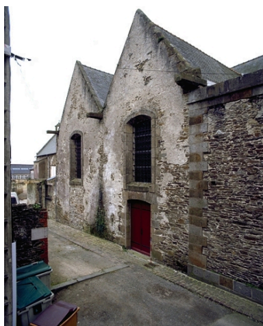
Vue latérale nord Phot. Guy Artur, Phot. Norbert Lambart IVR53_20003501007XA
