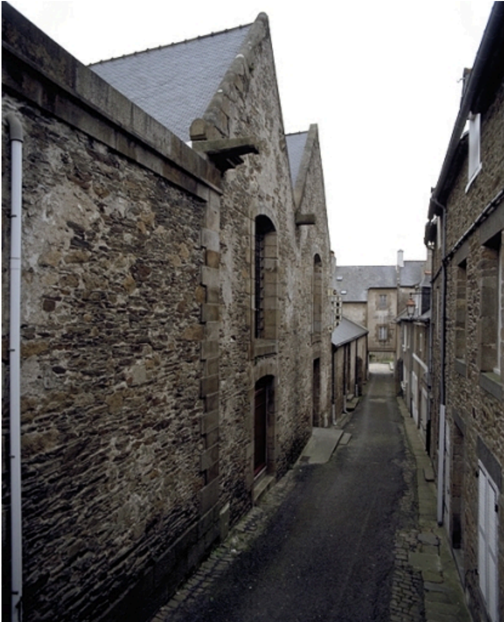
Vue latérale sud depuis l'impasse Saint-Méen
