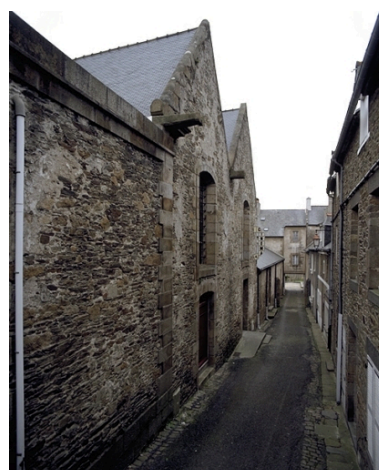
Vue latérale sud depuis l'impasse Saint-Méen Phot. Guy Artur, Phot. Norbert Lambart IVR53_20003501008XA
