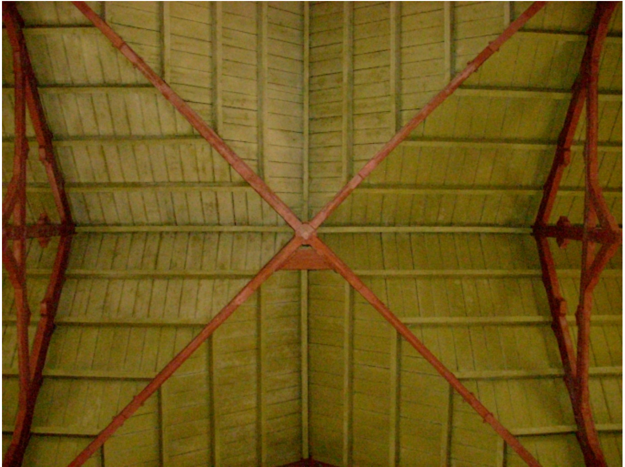
Kernilis, église paroissiale : détail lambris de couverture à la croisée du transept
