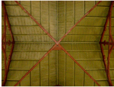
Kernilis, église paroissiale : détail lambris de couverture à la croisée du transept Phot. Gwénaél Fauchille IVR53_20082906333NUCA
