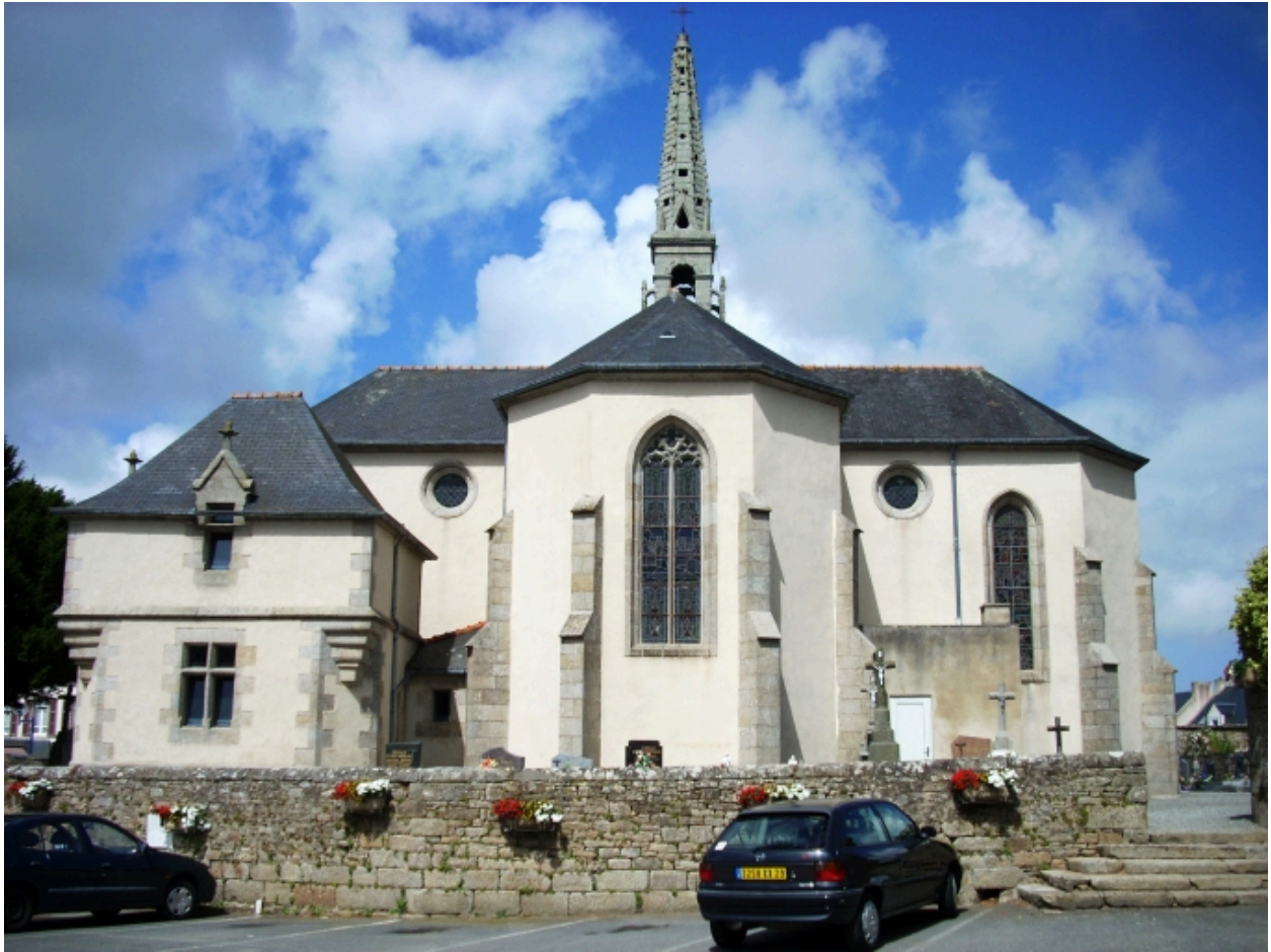
Kernilis, église paroissiale : élévation est
