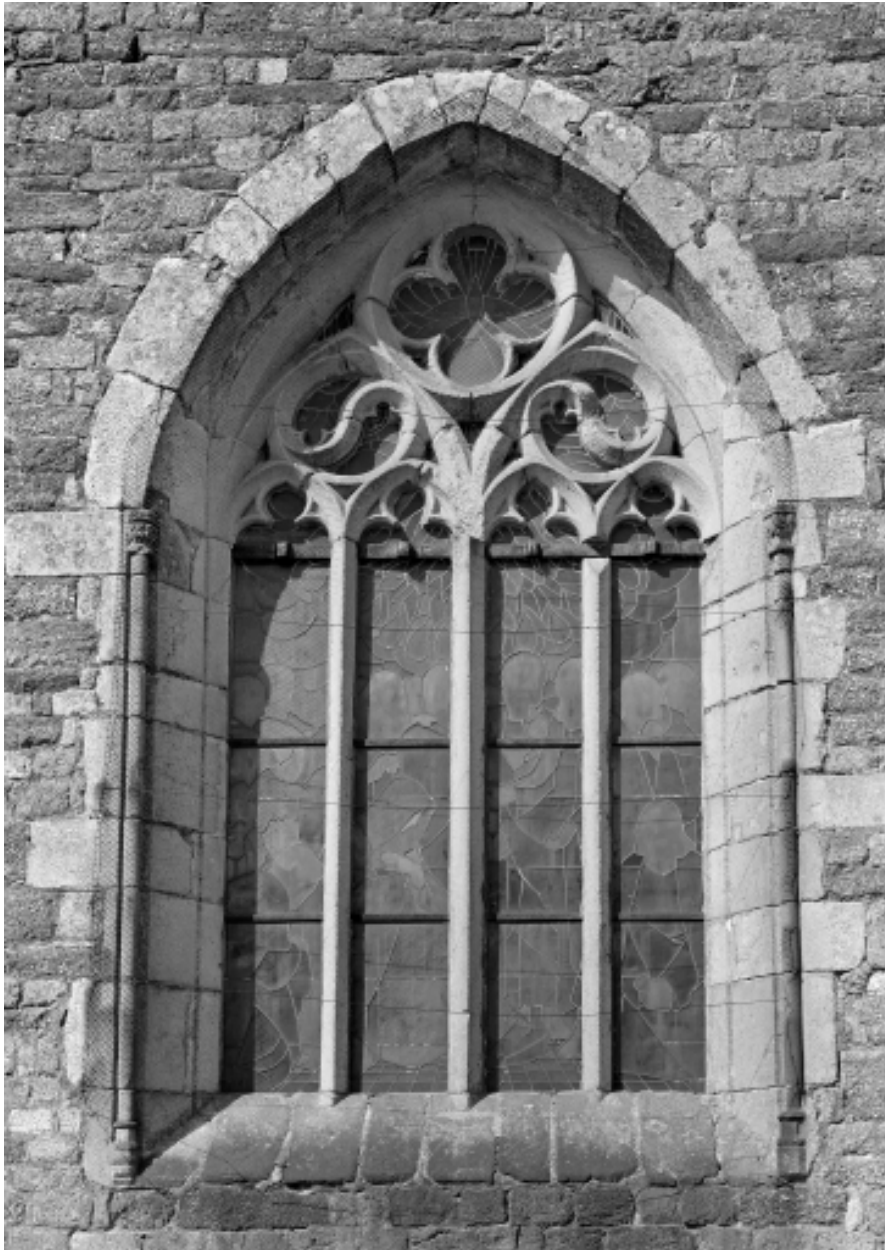
Façade sud, baie, vue générale
