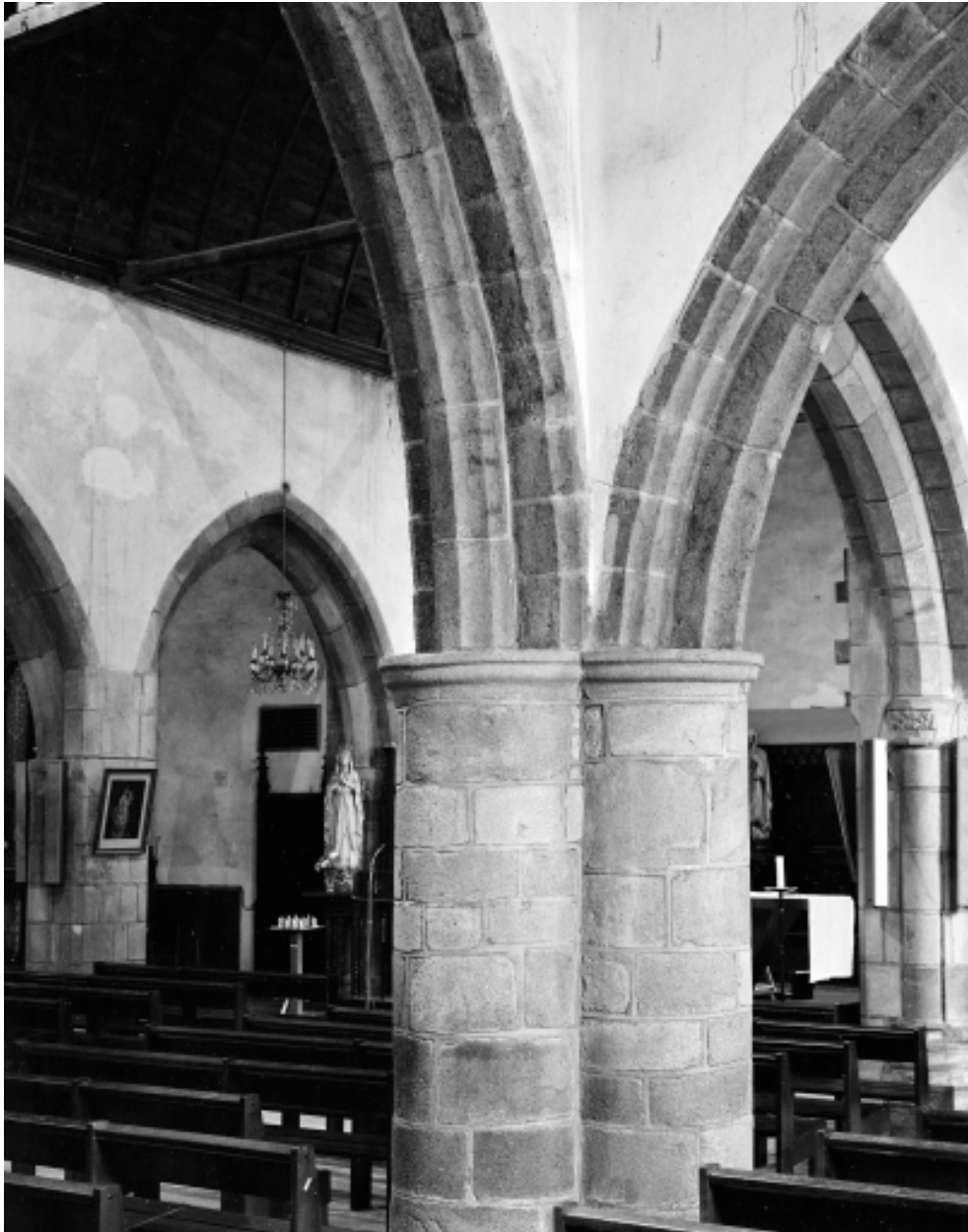
Nef, troisième pile Sud, vue générale
