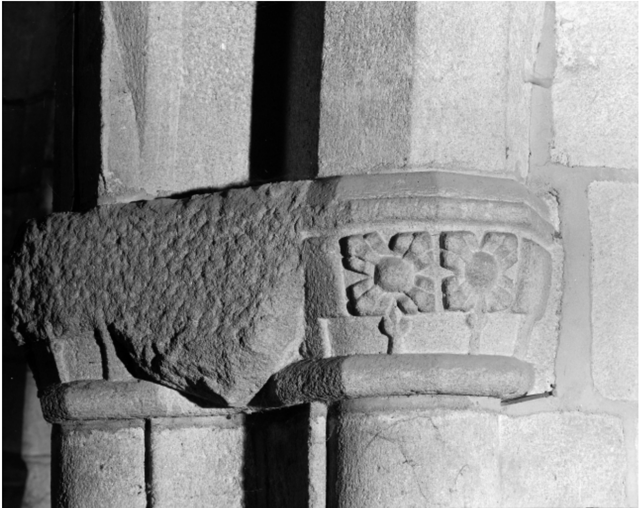
Nef, deuxième pile sud : chapiteau, vue de détail.
