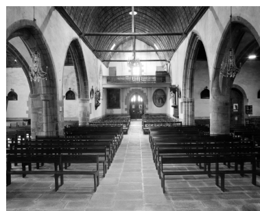
Intérieur : nef vers l'Ouest, vue générale. Phot. L. Lamandé IVR53_19853501234X
