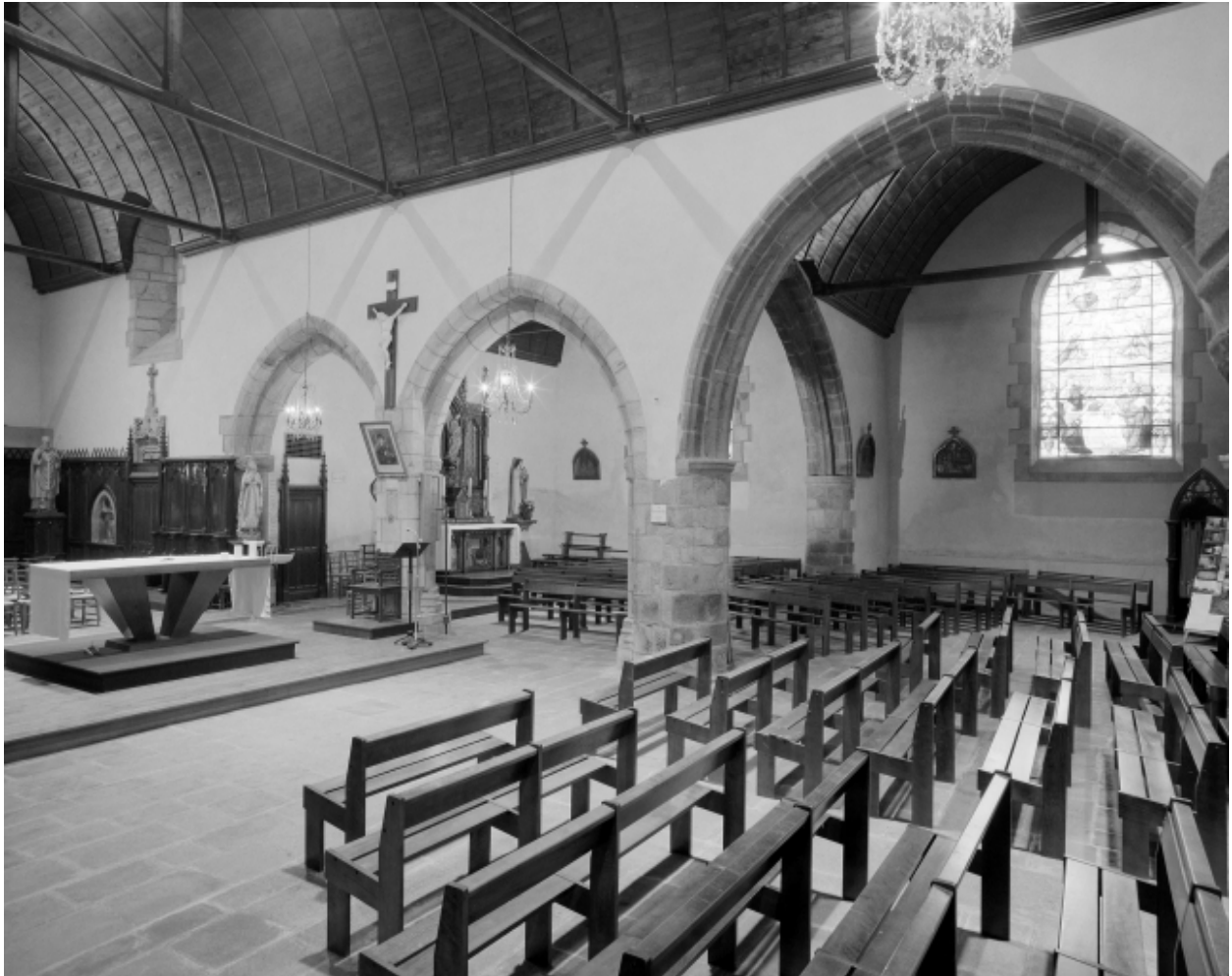
Intérieur, collatéral Sud, partie Est : vue générale.
