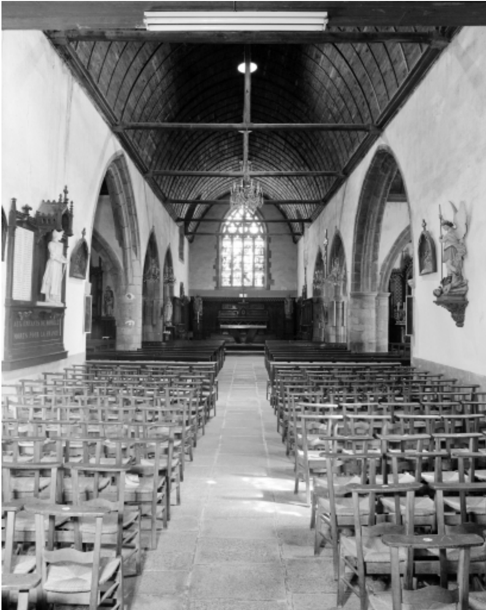
Intérieur, nef vers l'Est, vue générale.
