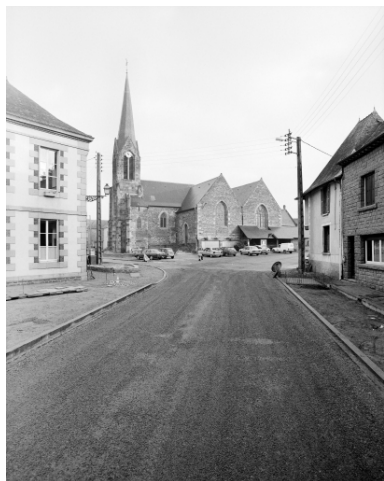
Elévation sud : vue générale Phot. Bernard Bègne, Phot. M. Loyon IVR53_19933500699X
