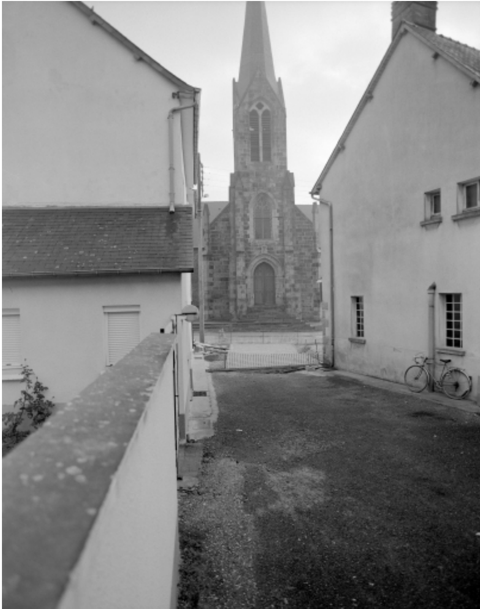
Elévation ouest : vue générale
