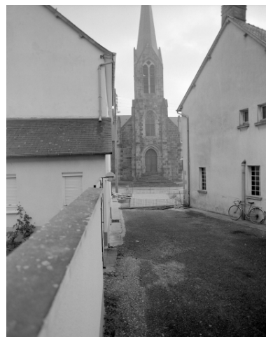
Elévation ouest : vue générale Phot. Bernard Bègne, Phot. M. Loyon IVR53_19933500700X
