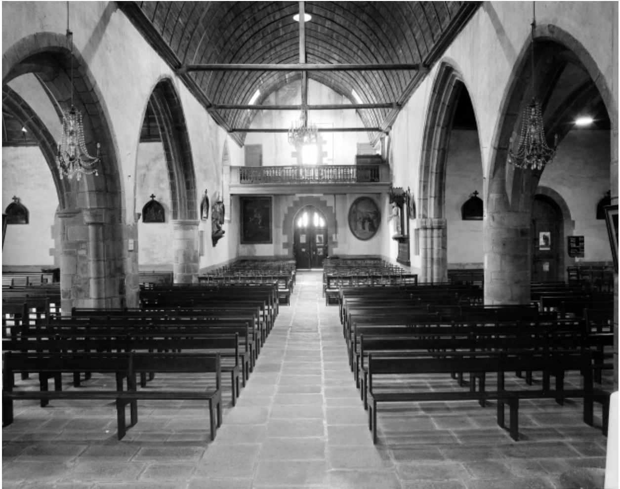
Intérieur : nef vers l'Ouest, vue générale.
