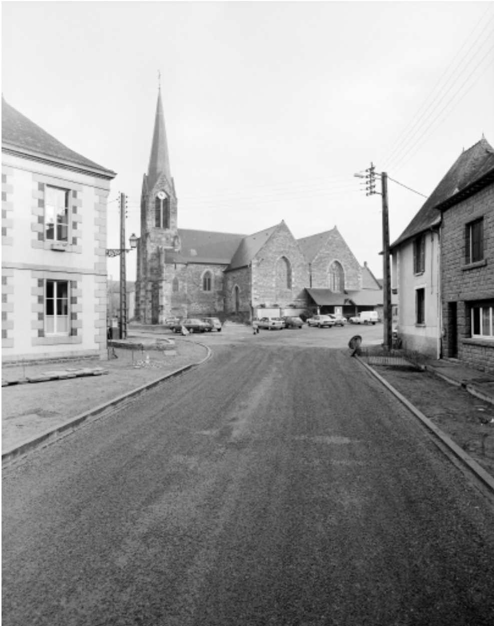
Elévation sud : vue générale
