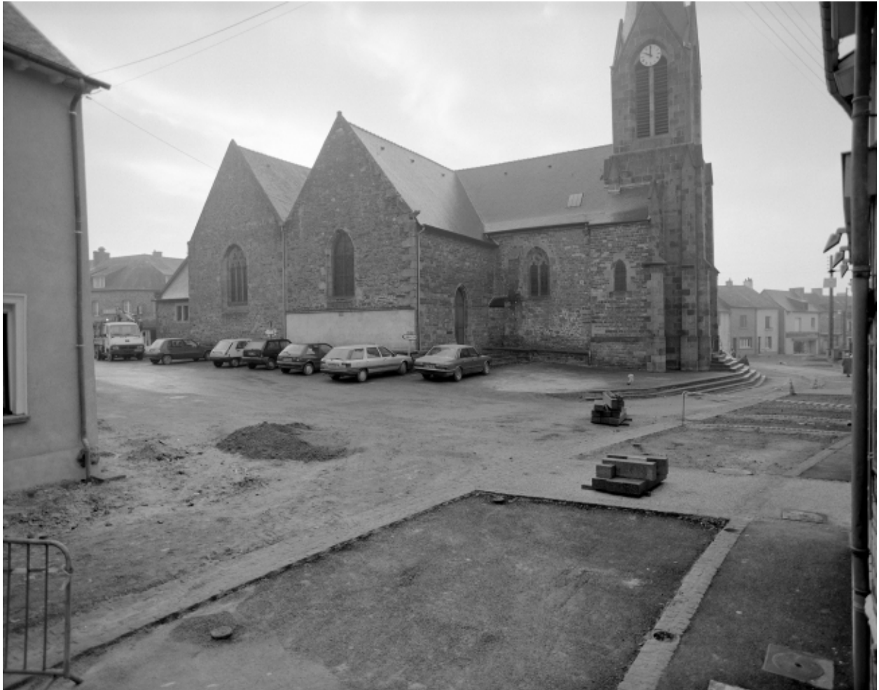
Elévation nord : vue générale
