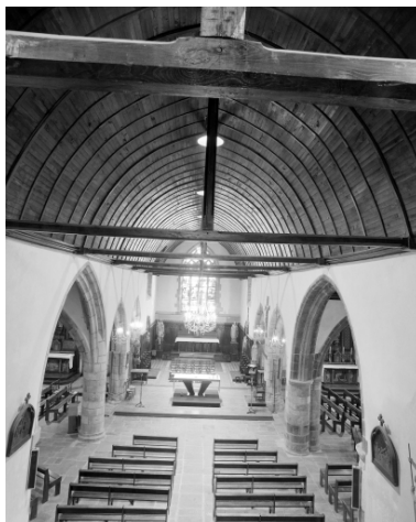
Intérieur : vue générale vers le chœur. Phot. Bernard Bègne, Phot. M. Loyon IVR53_19933500708X
