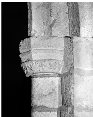
Nef, quatrième pile nord : chapiteau, vue de détail. Phot. L. Lamandé IVR53_19853501228X
