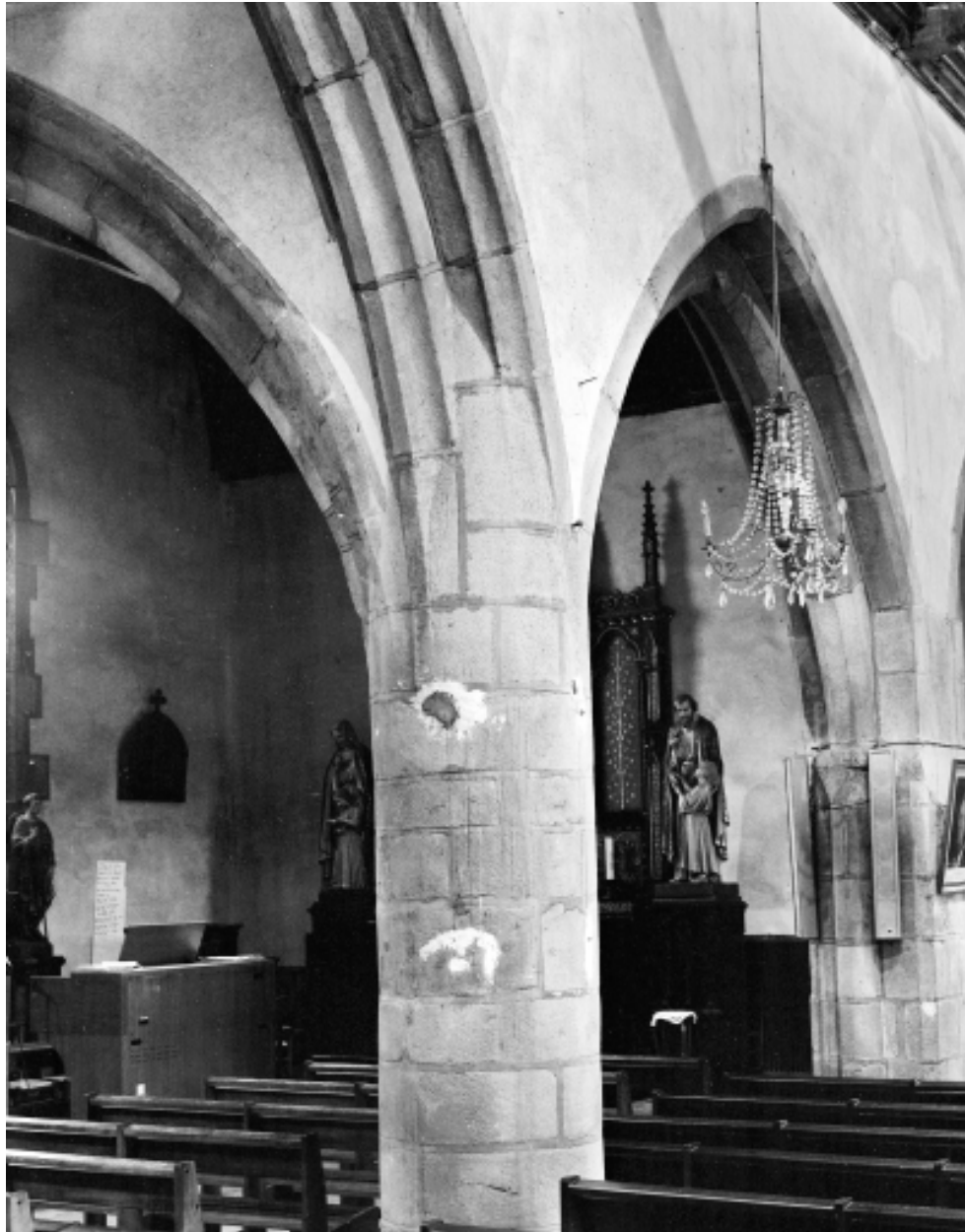
Nef, troisième pile nord, vue générale.
