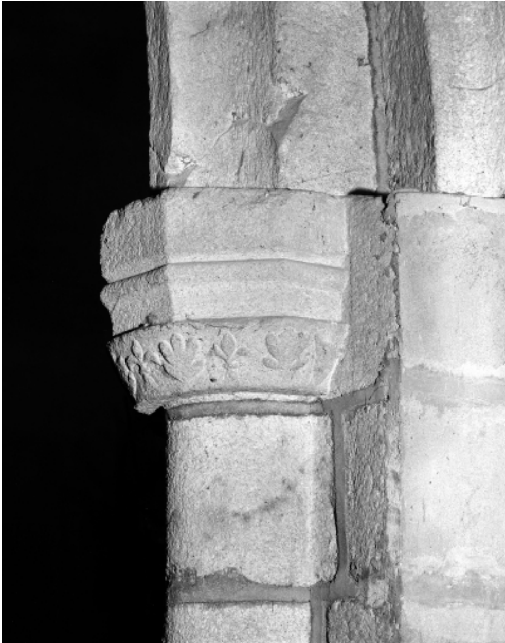
Nef, quatrième pile nord : chapiteau, vue de détail.
