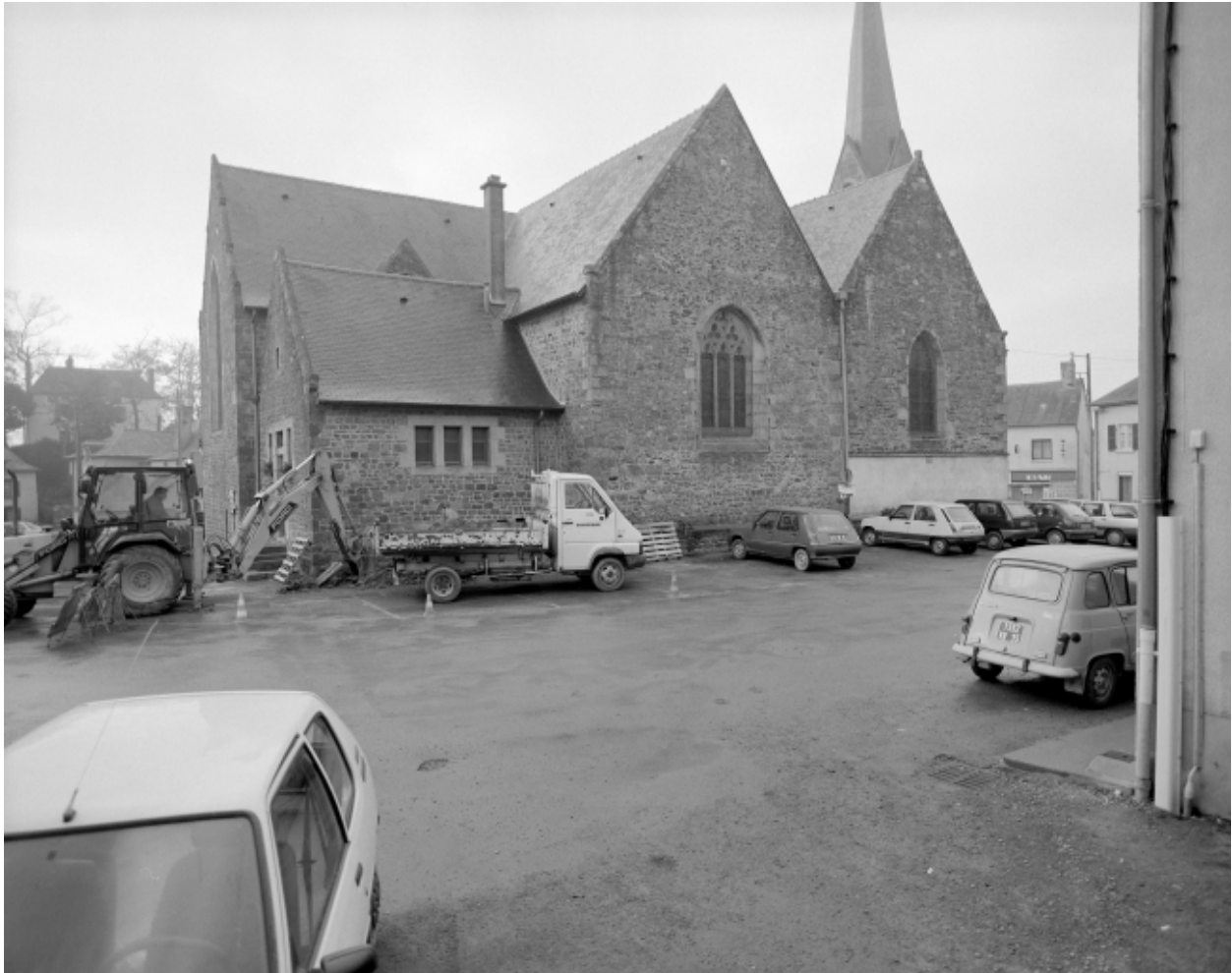
Elévation nord-est : vue générale
