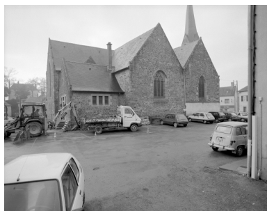
Elévation nord-est : vue générale Phot. Bernard Bègne, Phot. M. Loyon IVR53_19933500702X
