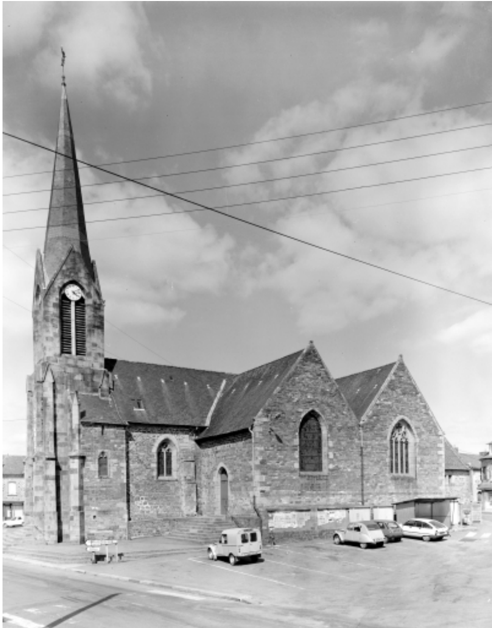
Elévation sud : vue générale
