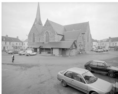
Elévation sud-est : vue générale Phot. Bernard Bègne, Phot. M. Loyon IVR53_19933500704X
