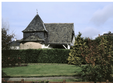
Vue générale sud ; état en 1993 Phot. Bernard Bègne, Phot. M. Loyon IVR53_19933500184XA
