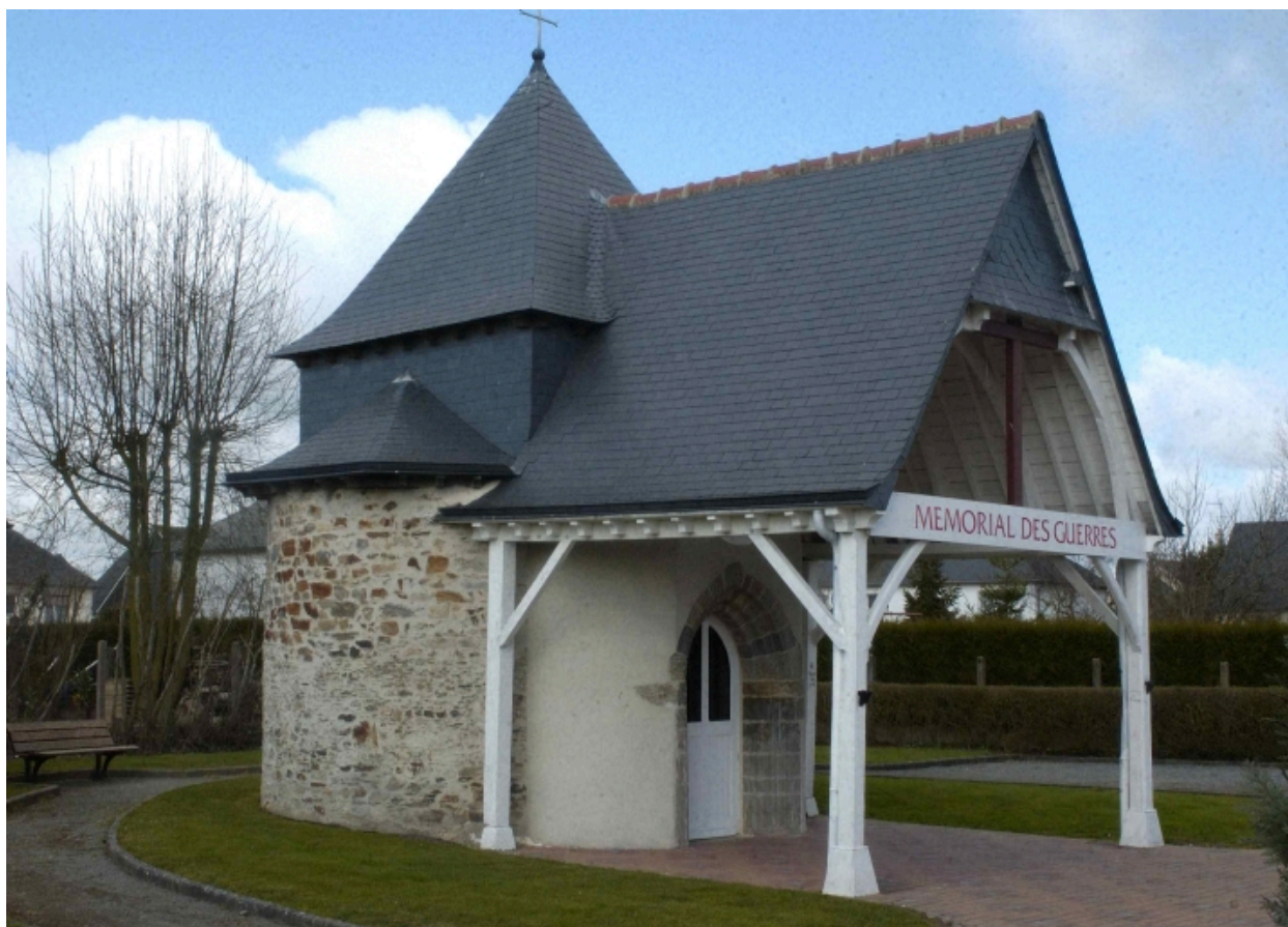
Vue générale sud
