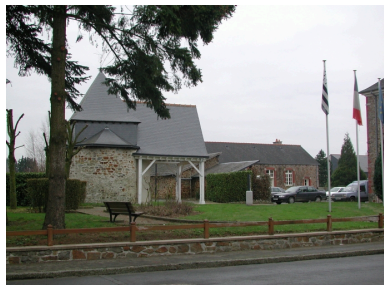
Vue de situation sud Phot. Claude Quillivic IVR53_20033507585NUCA
