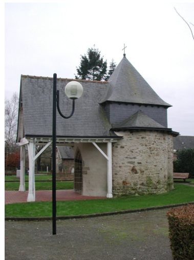
Vue générale nord Phot. Claude Quillivic IVR53_20033507584NUCA
