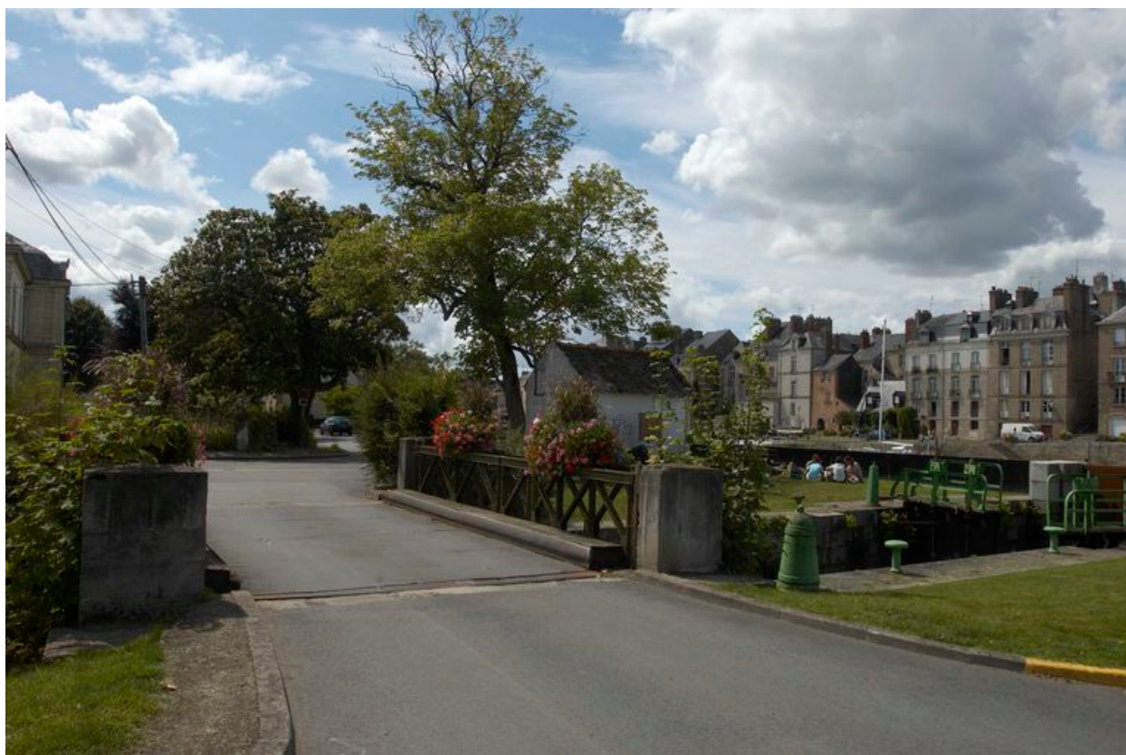
Ecluse 17 (en Loire-Atlantique) : vue rapprochée prise de l'ouest
