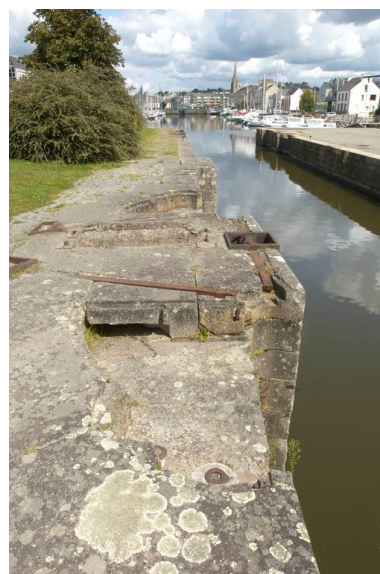
Ecluse marine : vue générale du sas Phot. Norbert Lambart IVR53_20083501187NUCA
