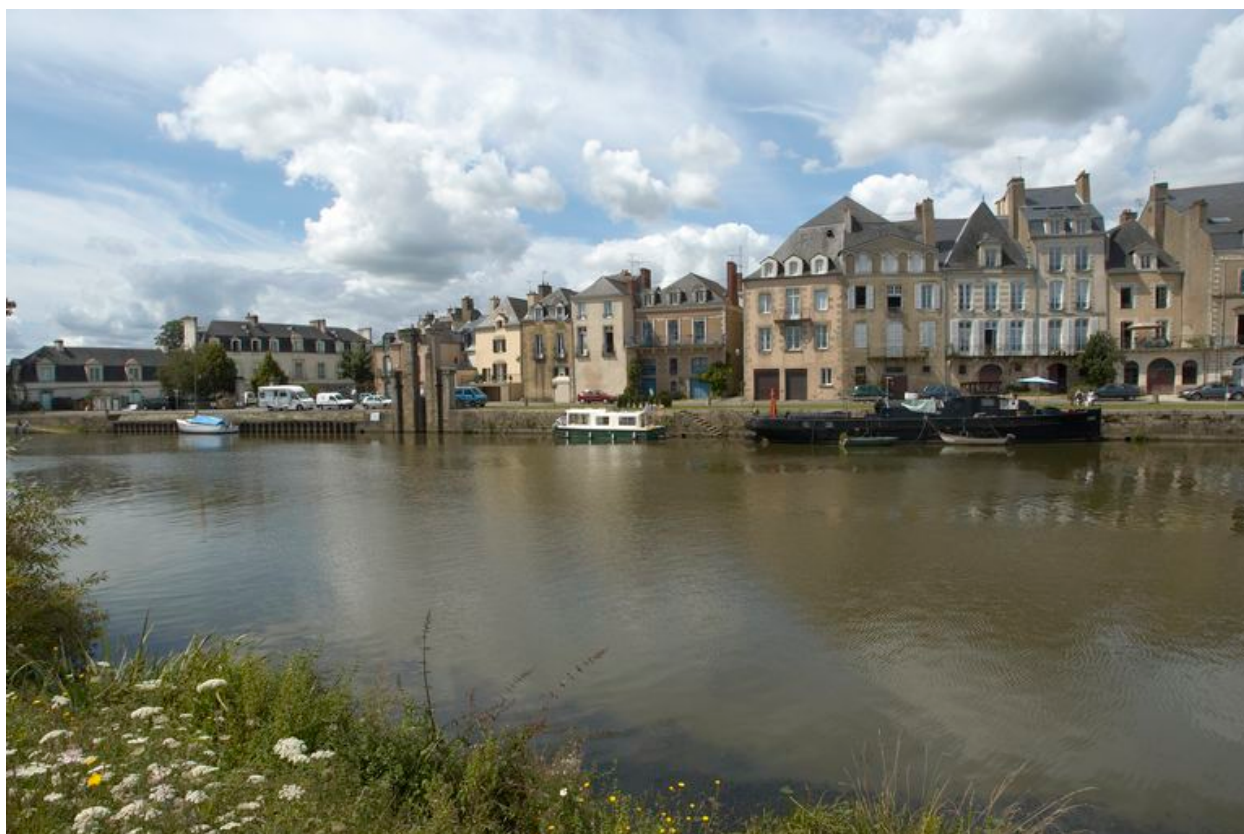
Grand Vannage : pile ouest du barrage : vue générale prise du nord-est
