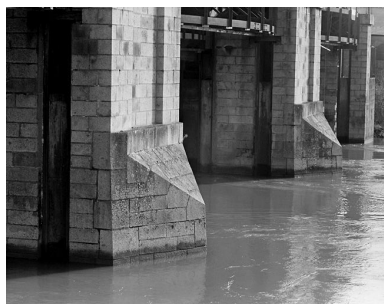
Grand Vannage : détail sur une pile à bec de granite
