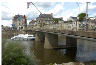
La Vilaine, pont routier au nord du Grand Vannage : vue rapprochée prise de l'aval Phot. Norbert Lambart IVR53_20083501211NUCA
