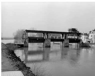
Grand Vannage : vue générale prise du nord
