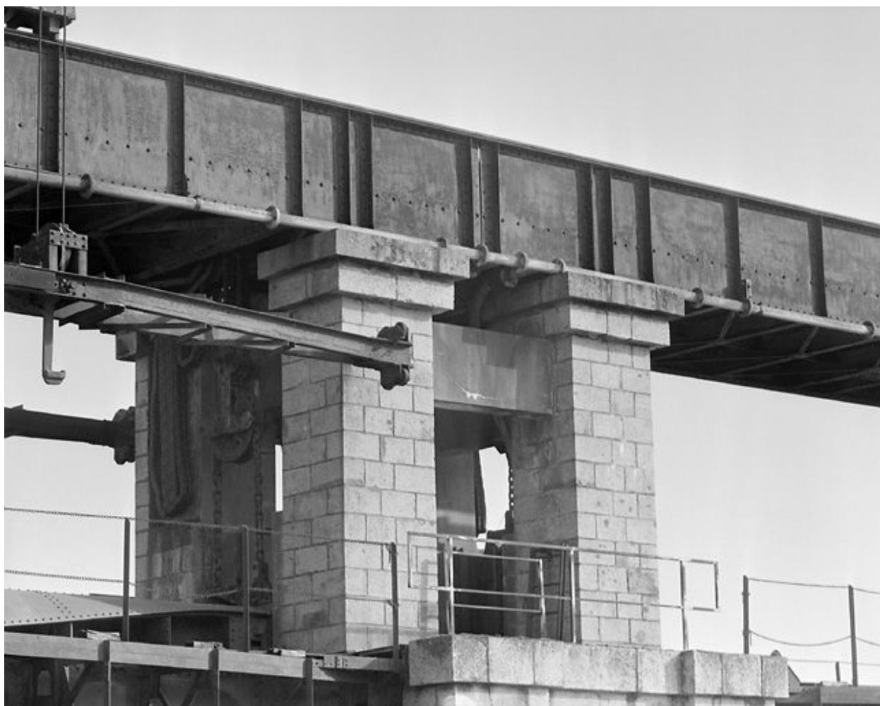
Grand Vannage : détail montrant la mixité granite-fer
