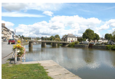
La Vilaine, pont routier au nord du Grand Vannage : vue générale prise de l'aval Phot. Norbert Lambart IVR53_20083501196NUCA
