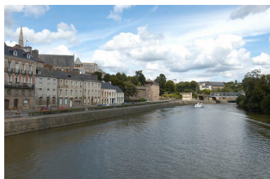
La Vilaine, quai Saint-Jacques : vue générale vers l'amont, avec le pont de chemin de fer Phot. Norbert Lambart IVR53_20083501213NUCA
