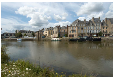
Grand Vannage : pile ouest du barrage : vue générale prise du nord-est Phot. Norbert Lambart IVR53_20083501203NUCA
