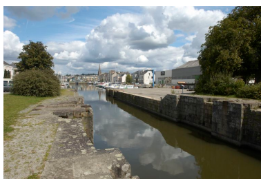
Ecluse marine : vue générale vers le grand bassin Phot. Norbert Lambart IVR53_20083501185NUCA
