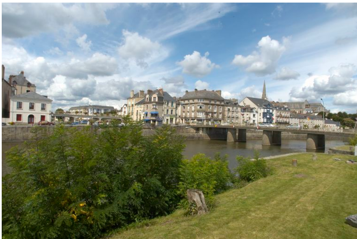
La Vilaine, pont routier au nord du Grand Vannage : vue générale prise de l'aval
