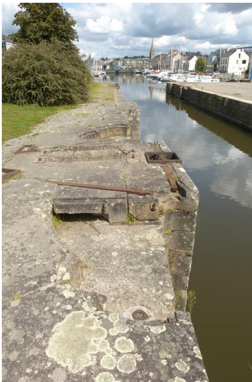
Ecluse marine : vue générale du sas
