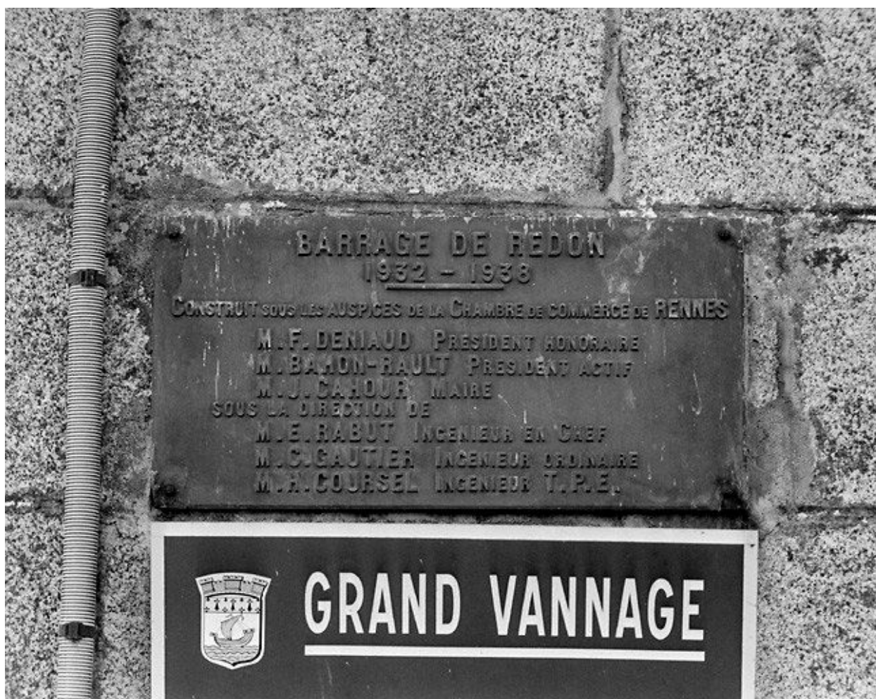
Grand Vannage : plaque indiquant les dates et les constructeurs
