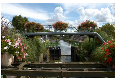
Ecluse 17 (en Loire-Atlantique) : vue rapprochée depuis l'amont Phot. Norbert Lambart IVR53_20083501217NUCA
