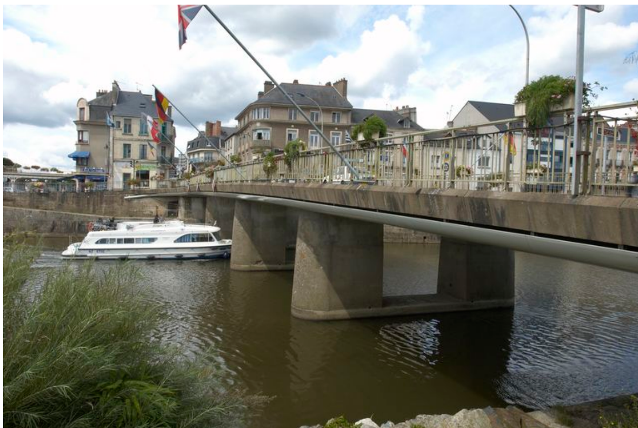
La Vilaine, pont routier au nord du Grand Vannage : vue rapprochée prise de l'aval
