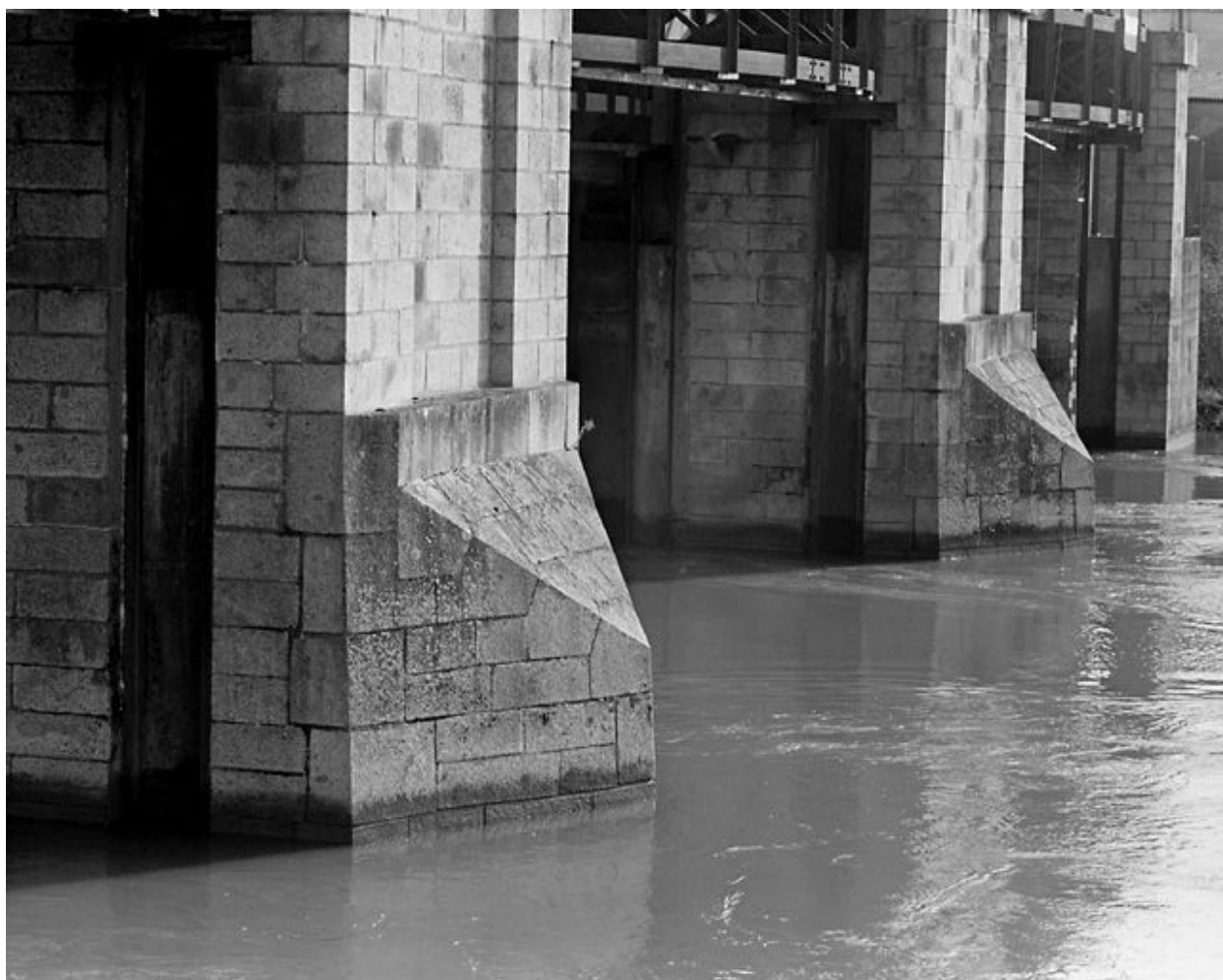
Grand Vannage : détail sur une pile à bec de granite
