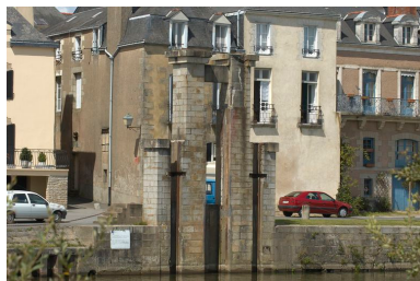
Grand Vannage : pile ouest du barrage : vue rapprochée Phot. Norbert Lambart IVR53_20083501201NUCA
