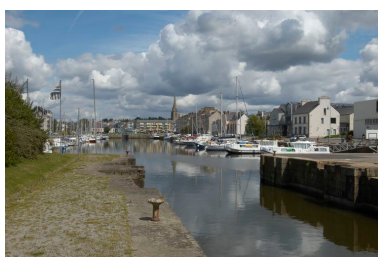
Grand bassin : vue générale sud nord prise depuis l'écluse marine Phot. Norbert Lambart IVR53_20083501189NUCA
