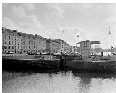
Vue de situation du bassin à partir du canal de Nantes à Brest Phot. Guy Artur IVR53_19973500410X
