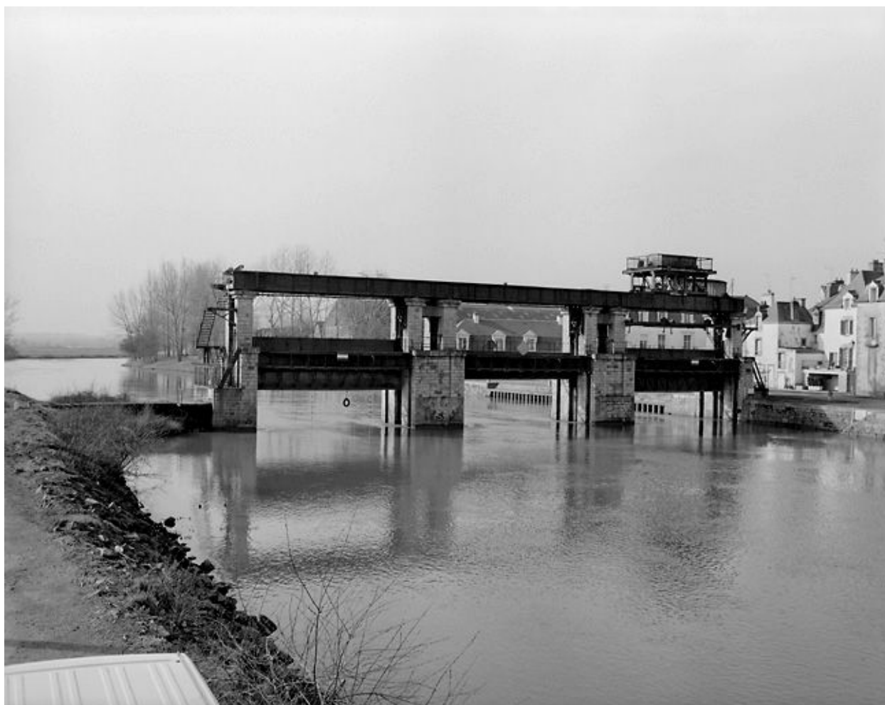
Grand Vannage : vue générale prise du nord
