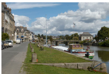
La Vilaine, péniche amarrée le long du quai Duguay-Trouin et pont au nord du Grand Vannage Phot. Norbert Lambart IVR53_20083501195NUCA
