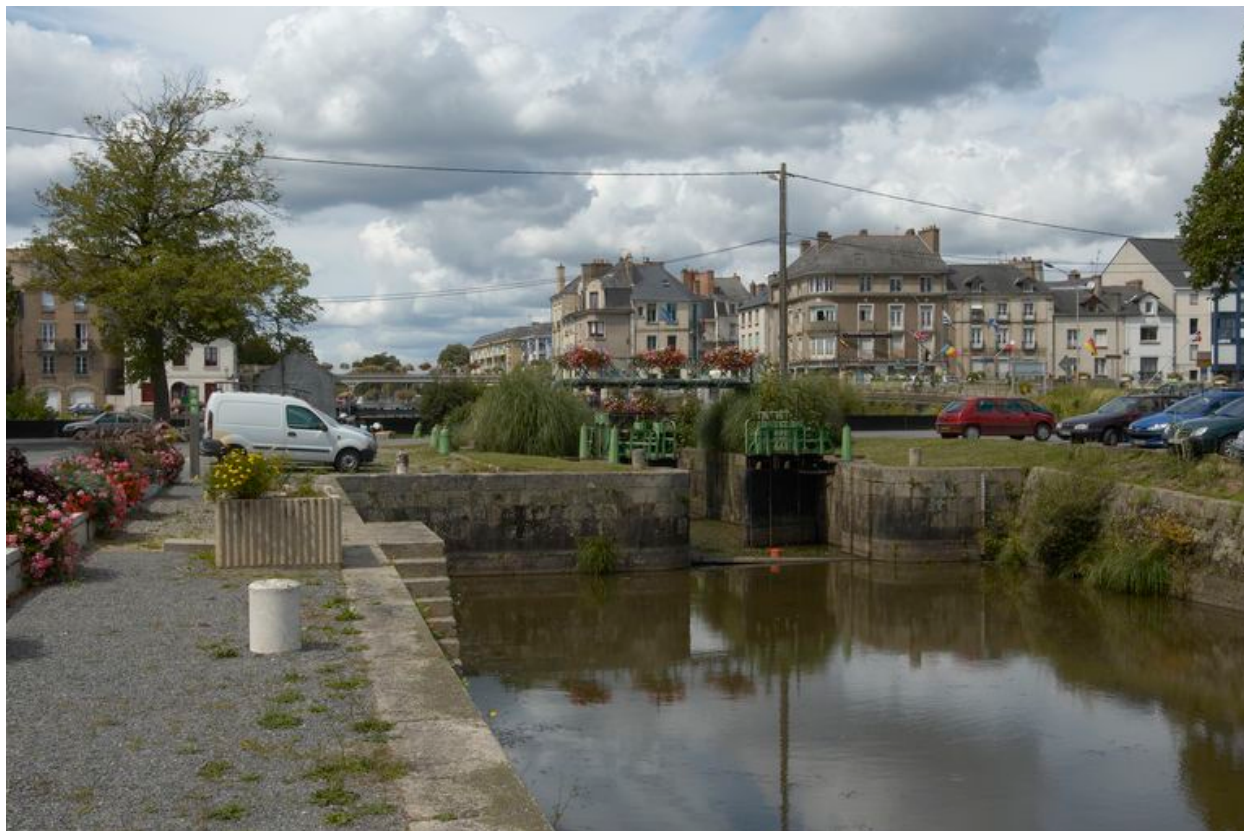
Ecluse 17 (en Loire-Atlantique) : vue générale depuis l'aval
