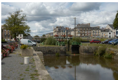
Ecluse 17 (en Loire-Atlantique) : vue générale depuis l'aval Phot. Norbert Lambart IVR53_20083501209NUCA
