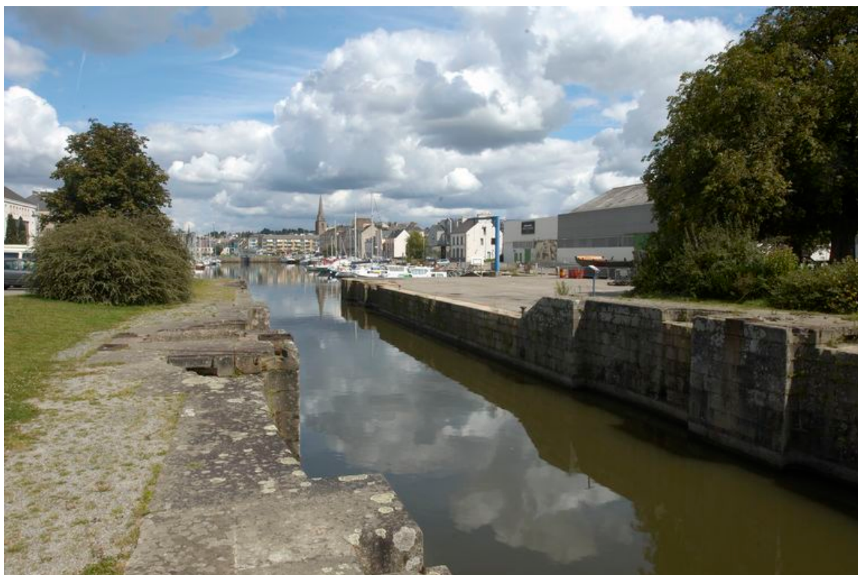
Ecluse marine : vue générale vers le grand bassin
