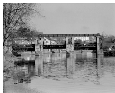
Grand Vannage : vue générale prise du sud Phot. Guy Artur IVR53_19973500376X
