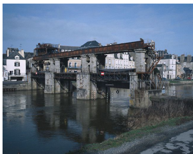
Grand Vannage : vue générale sur le flanc est Phot. Guy Artur IVR53_19973500415XA
