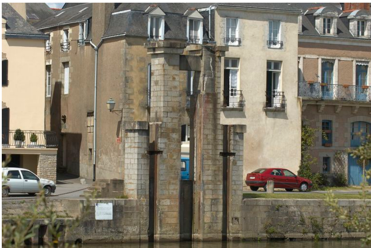
Grand Vannage : pile ouest du barrage : vue rapprochée
