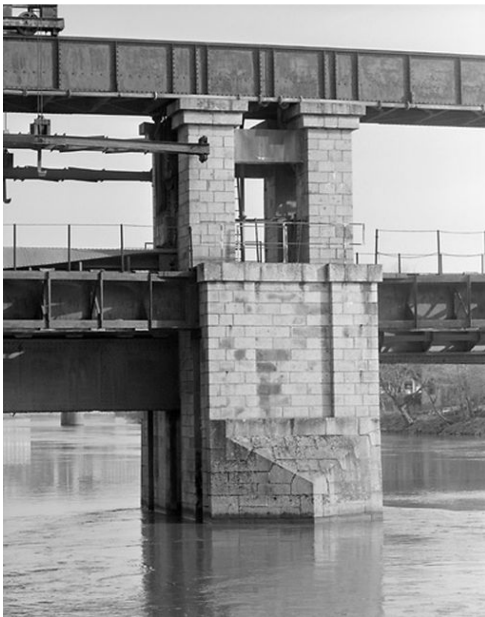
Grand Vannage : vue générale d'une pile
