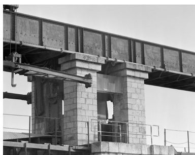
Grand Vannage : détail montrant la mixité granite-fer Phot. Guy Artur IVR53_19973500385X
