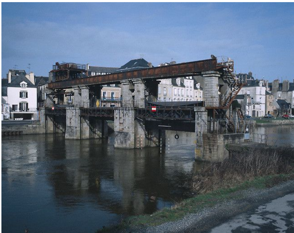
Grand Vannage : vue générale sur le flanc est
