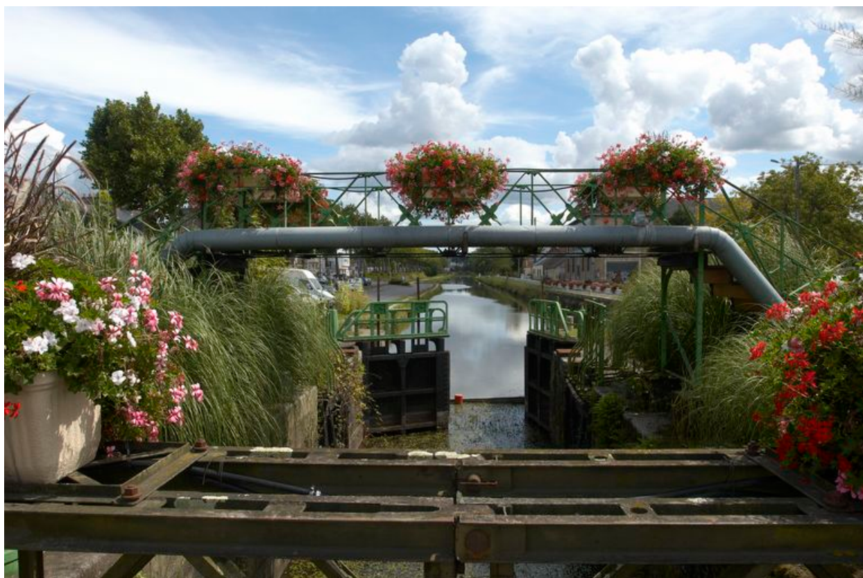
Ecluse 17 (en Loire-Atlantique) : vue rapprochée depuis l'amont
