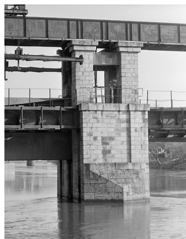
Grand Vannage : vue générale d'une pile Phot. Guy Artur IVR53_19973500383X
