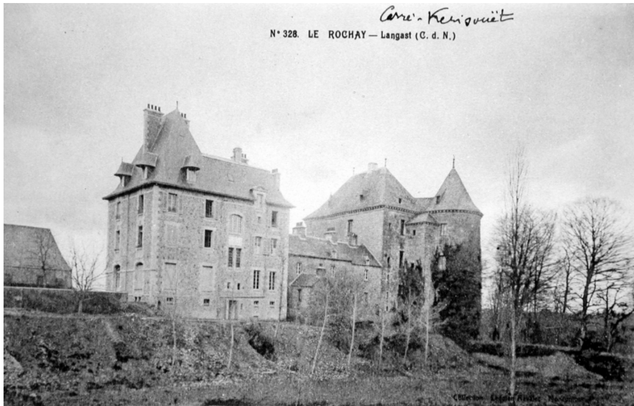
Vue générale des élévations postérieures
