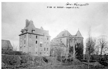
Vue générale des élévations postérieures Phot. Elise Lauranceau IVR53_20042209048NUCB
