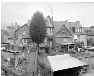
Vue générale de l'élévation postérieure.
