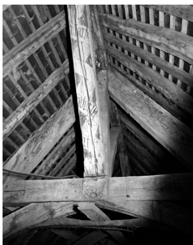
dessin sur charpente. Phot. Guy Artur, Phot. Norbert Lambart IVR53_19993501456X
