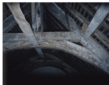
Détail sous charpente. Phot. Auteur inconnu IVR53_19993501463XA
