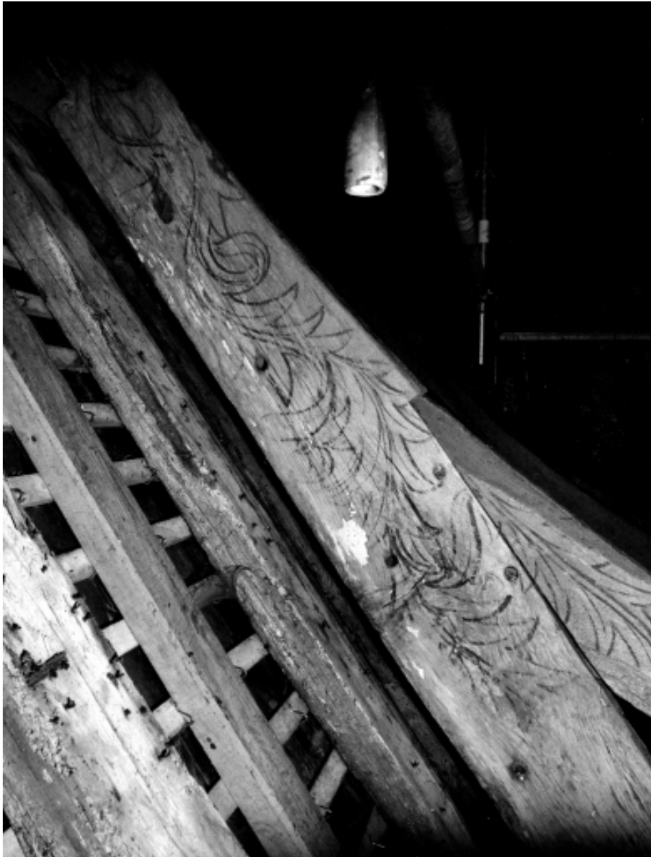
Détail sous charpente.
