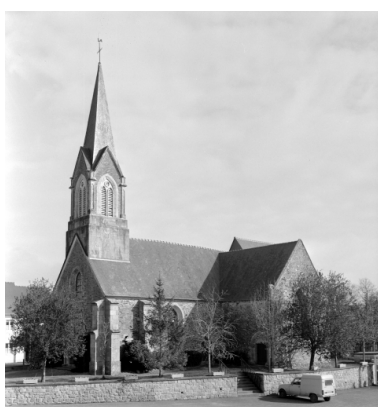
Elévation Sud-Ouest : vue générale
