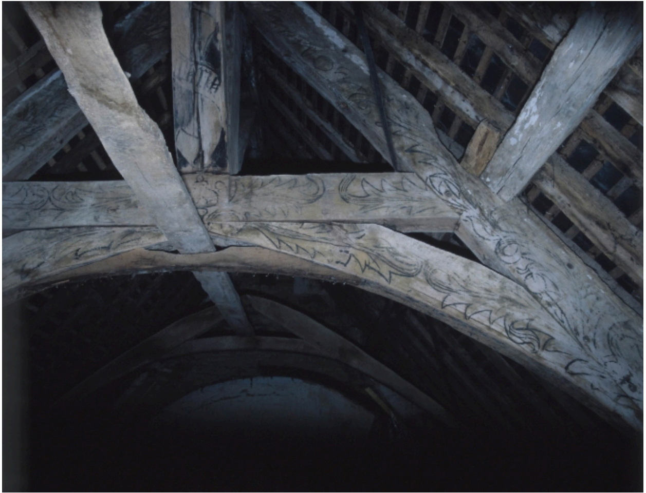
Détail sous charpente.
