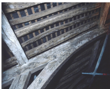
Détail sous charpente. Phot. Auteur inconnu IVR53_19993501462XA
