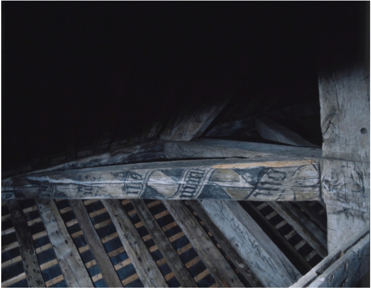
Détail sous charpente.
