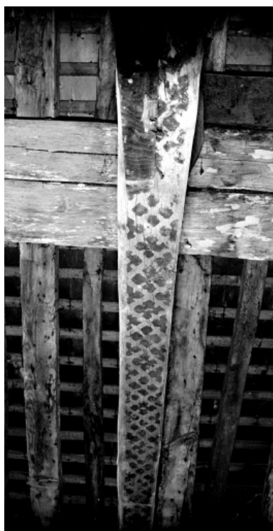
dessin sur charpente. Phot. Guy Artur, Phot. Norbert Lambart IVR53_19993501455X
