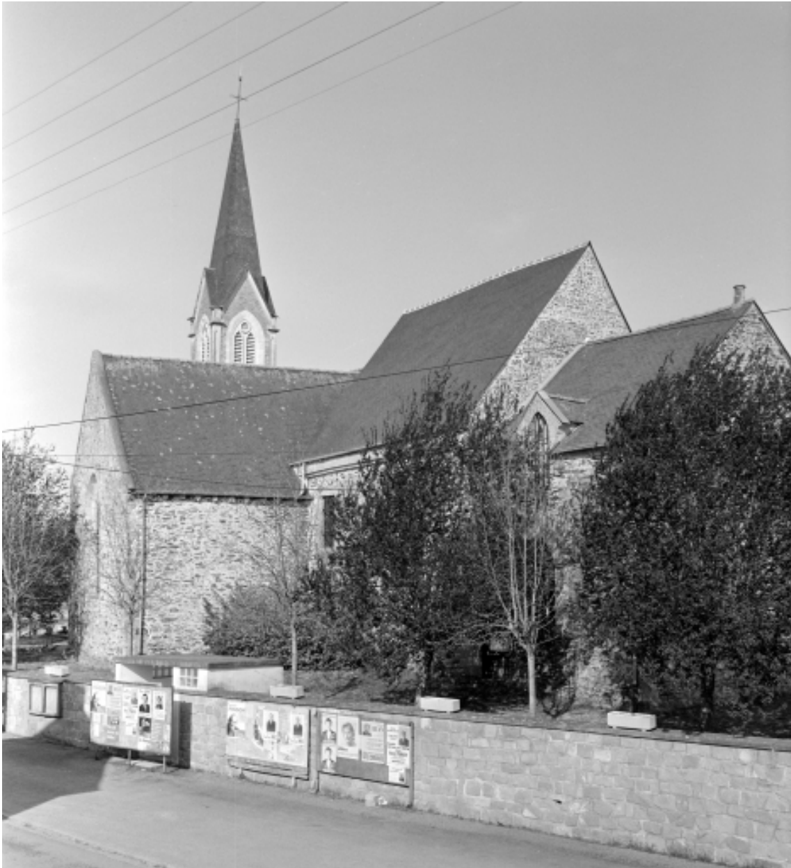
Elévation Est : vue générale
