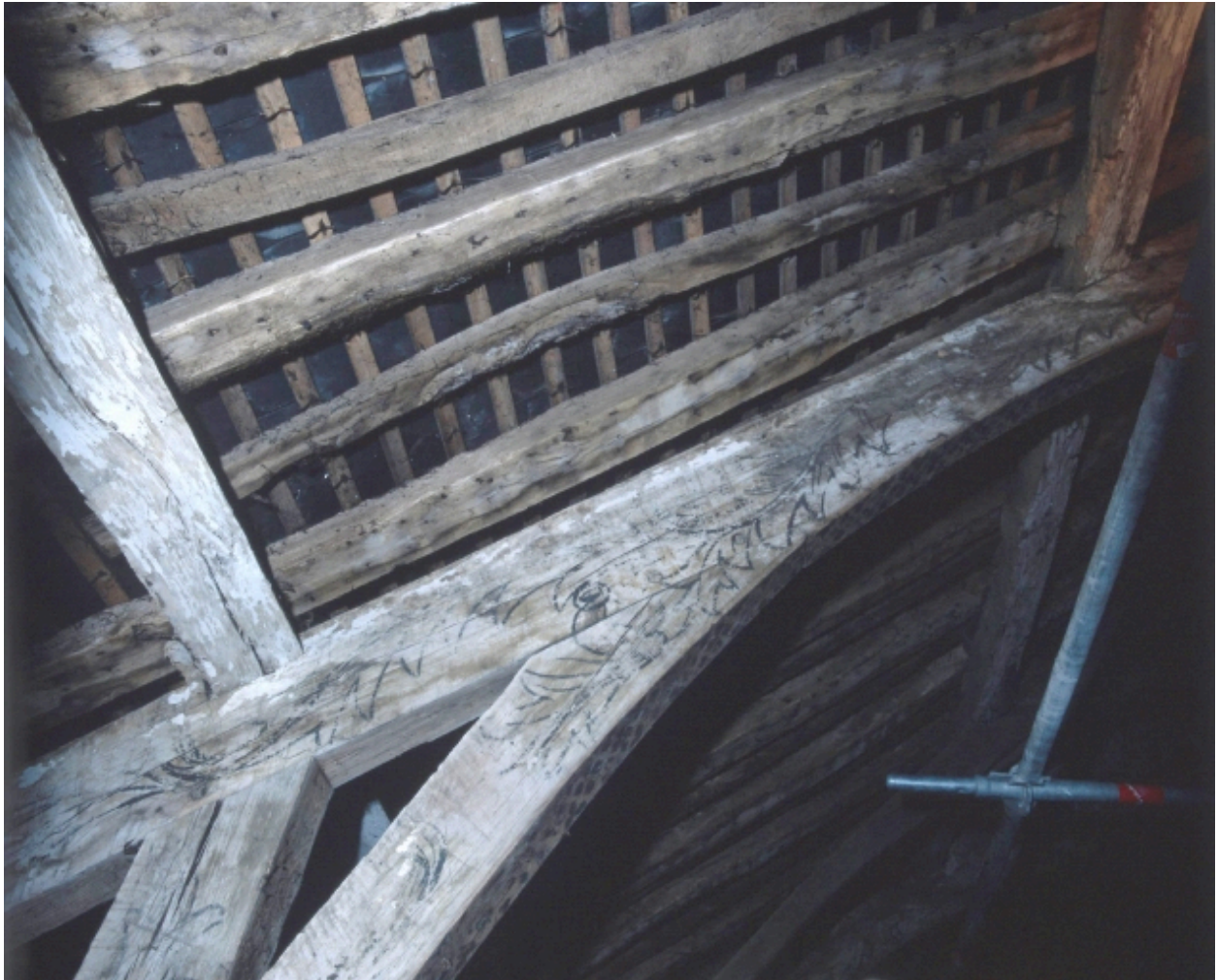
Détail sous charpente.
