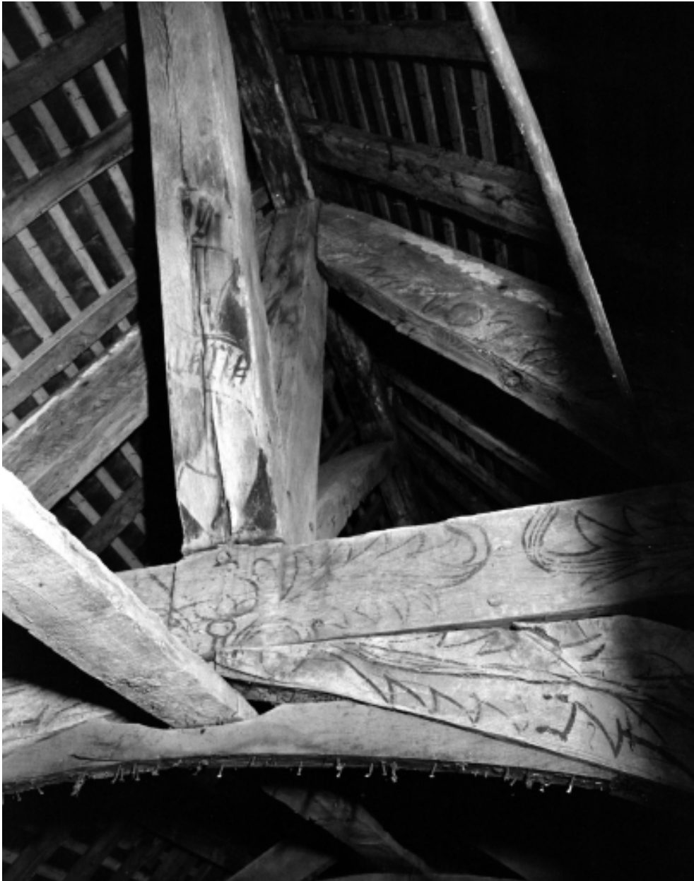
Détail sous charpente.
