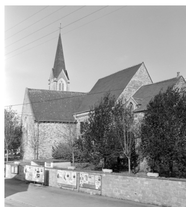
Elévation Est : vue générale
