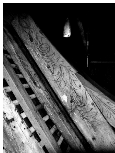
Détail sous charpente. Phot. Auteur inconnu IVR53_19993501460X
