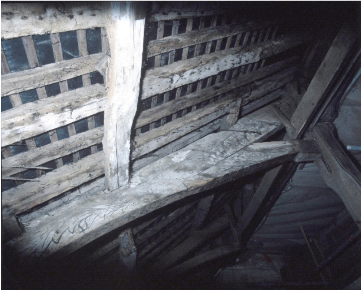
Détail sous charpente.
