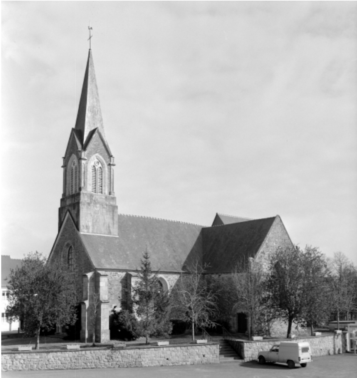
Elévation Sud-Ouest : vue générale
