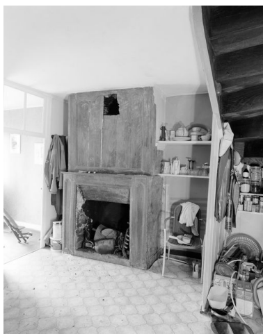
Maison, étage, pièce ouest : cheminée du 18e siècle (état en 1994) Phot. Guy Artur, Phot. Norbert Lambart IVR53_19945600475X
