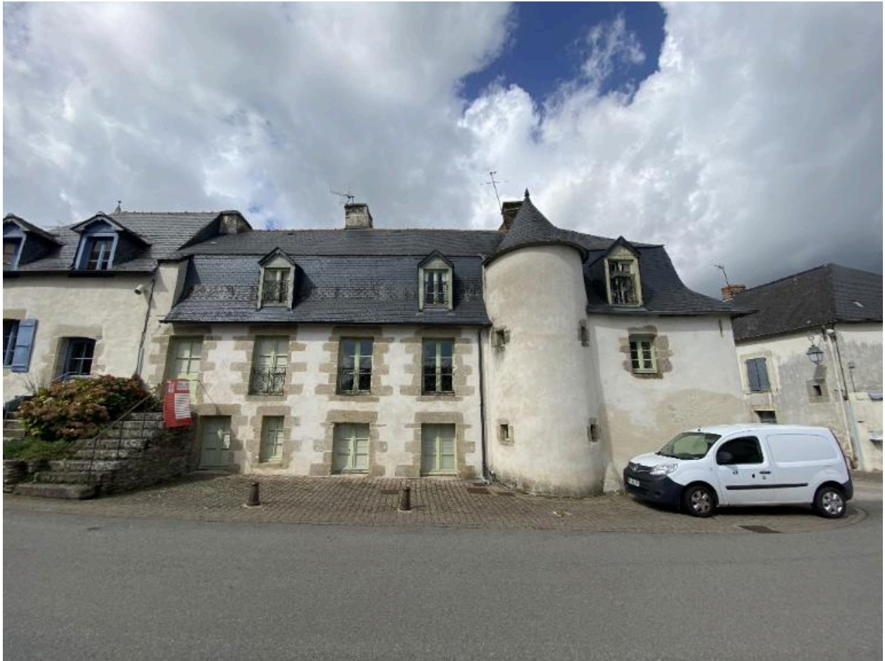
Vue générale sud
