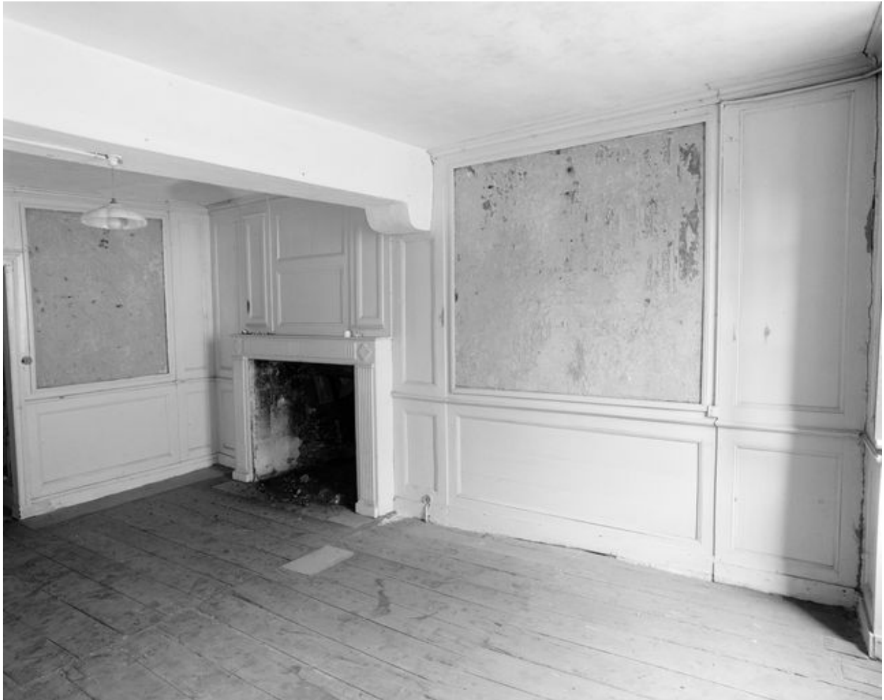
Maison, rez-de-chaussée : cheminée de la pièce est (état en 1994)
