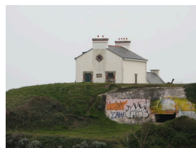
Vue du pignon nord de la villa Les Roches et de la casemate de Bellangenêt Phot. Guillaume Marie IVR53_20072909042NUCA
