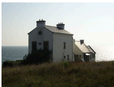
Vue générale de la villa Les Roches Phot. Johan Vincent IVR53_20062908670NUCA
