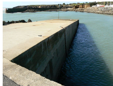
Vue générale de la cale Larzul Phot. Julien Amghar IVR53_20082908613NUCA
