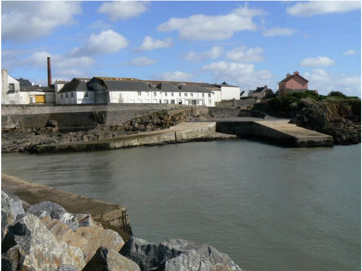
Les deux cales devant l'ancienne conserverie Capitaine Cook
