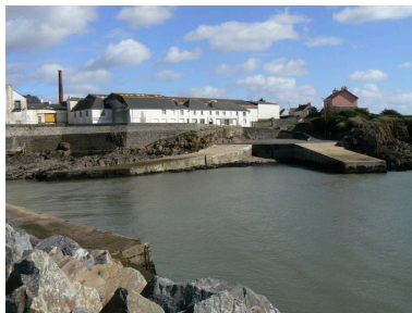
Les deux cales devant l'ancienne conserverie Capitaine Cook Phot. Julien Amghar IVR53_20082908605NUCA
