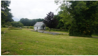
Vallon de Troménec : aménagement, station de pompage Phot. Auteur inconnu (phototype/graphique) IVR53_20252910048NUCA
