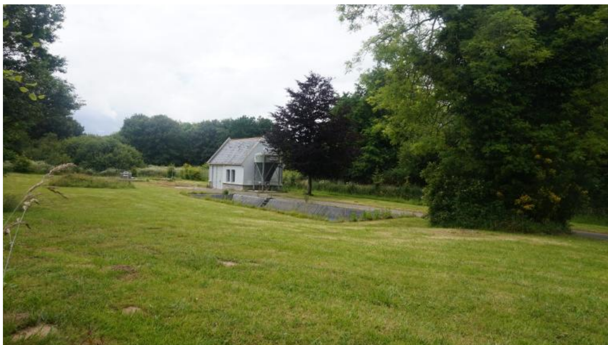
Vallon de Troménec : aménagements, station de pompage
