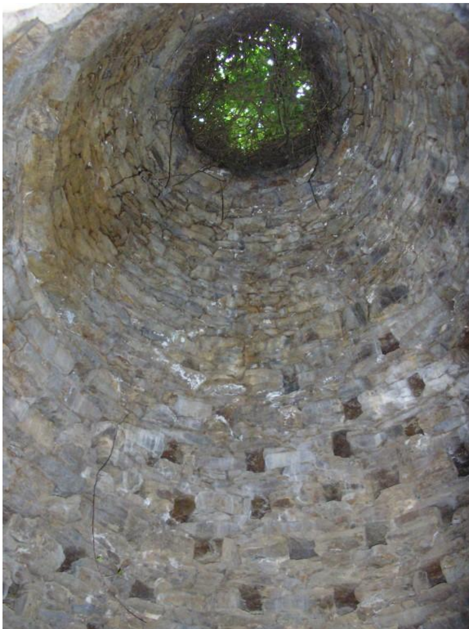
Intérieur du pigeonnier et des boulins
