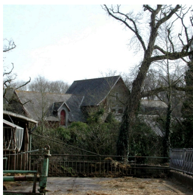
Vue générale des écuries Phot. Patrick Pichouron IVR53_20032203525NUCA
