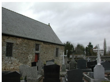
Mur sud de la nef et cimetière Phot. Véronique Orain IVR53_20023505191NUCA
