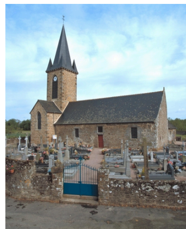
Cimetière et vue générale de l'église paroissiale Phot. Véronique Orain IVR53_20013501195XA
