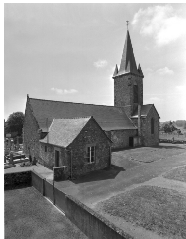
Vue d'ensemble des façades nord Phot. Guy Artur, Phot. Norbert Lambart IVR53_19943501008X
