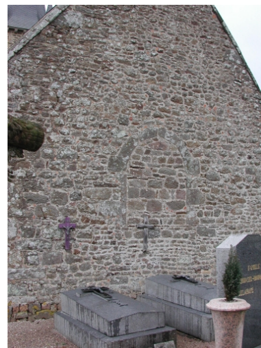
Vue extérieure du chevet, détail d'une ouverture murée Phot. Véronique Orain IVR53_20023505192NUCA
