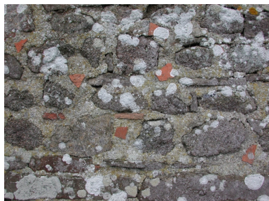
Mur nord de la nef, détail de l'appareillage Phot. Véronique Orain IVR53_20023505193NUCA
