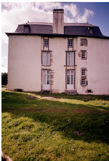
Vue générale, de la façade est. Phot. Service régional de l'Inventaire de Bretagne IVR53_19703501429VA
