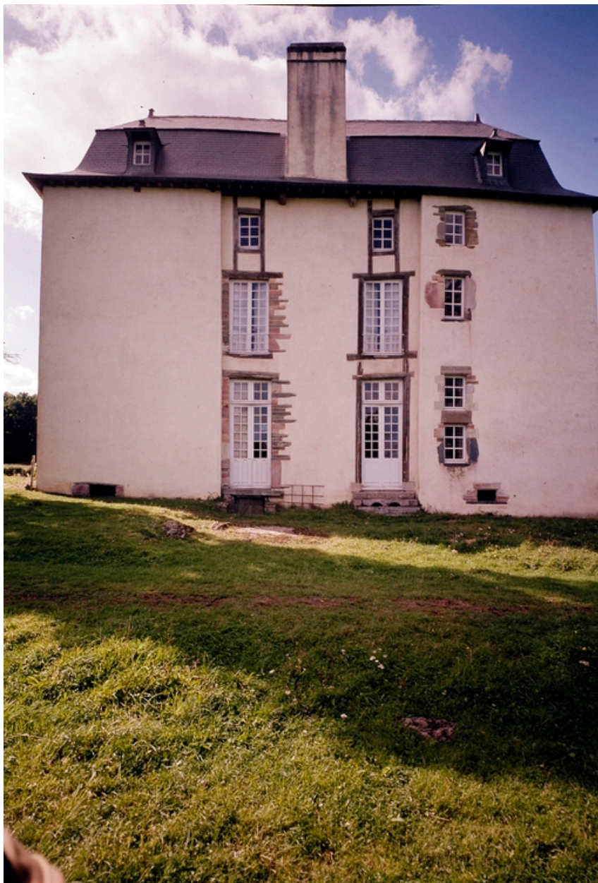
Vue générale, de la façade est.
