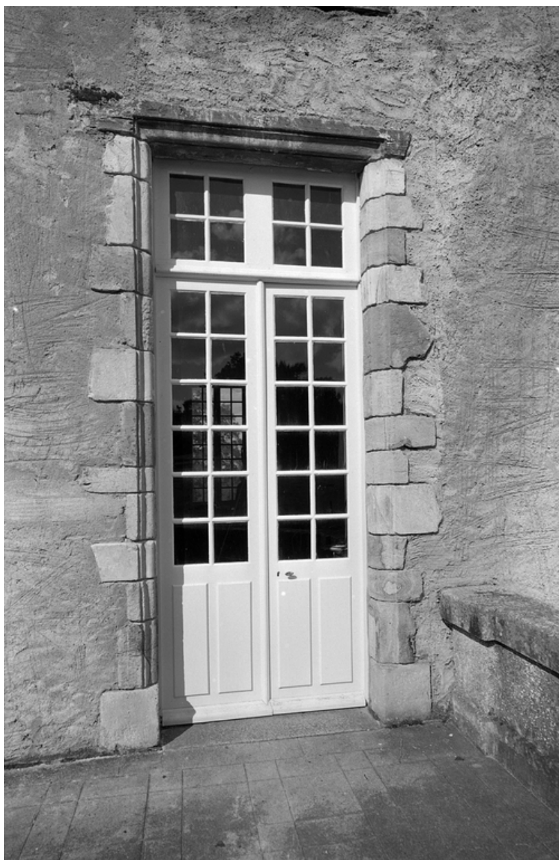
Façade sud, détail d'une porte fenêtre.
