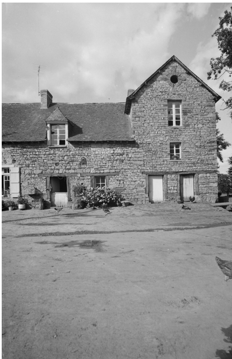
Dépendances, aile nord façade sud.
