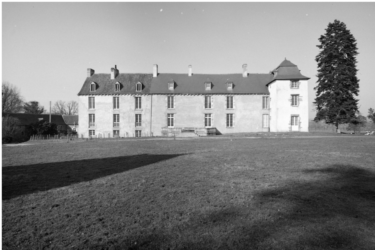
Façade sud, vue générale.
