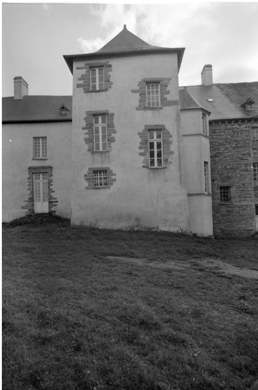
Tour façade nord, vue générale.
