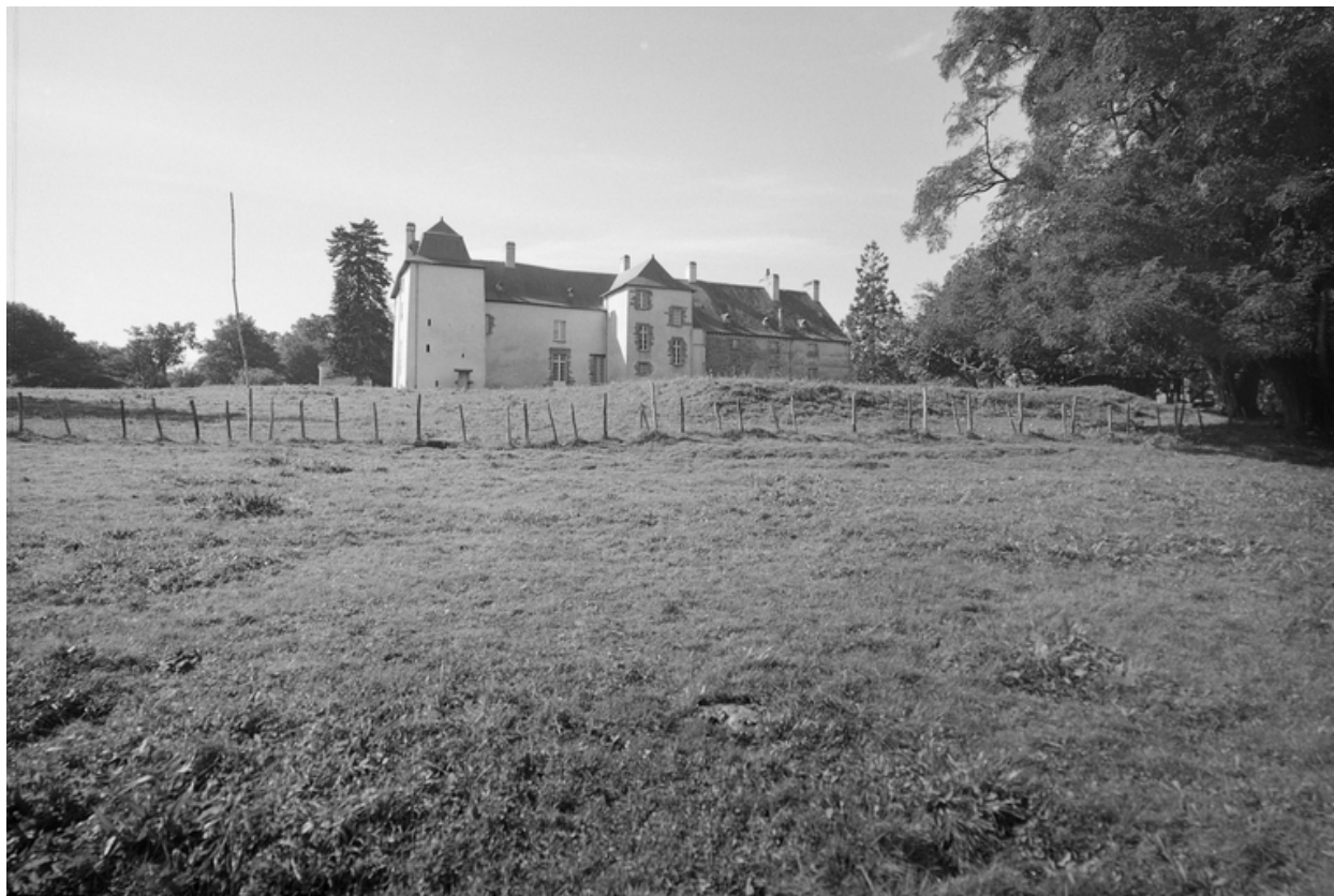
Vue de situation, prise du nord.
