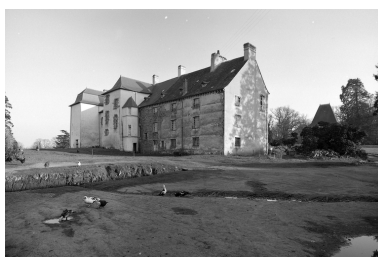
Vue générale, la cour de la ferme. Phot. Guy Artur IVR53_19693500158V
