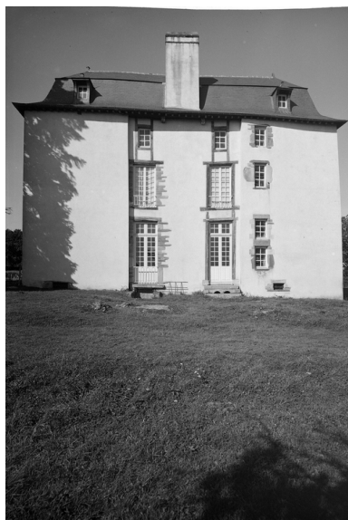
Vue générale de la façade est. Phot. François Dagorn IVR53_19703500658V
