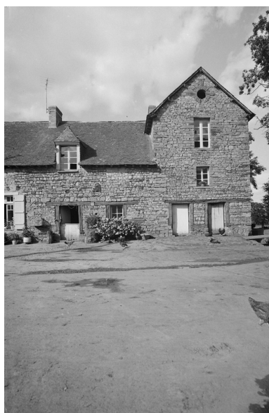
Dépendances, aile nord façade sud. Phot. François Dagorn IVR53_19703500649V
