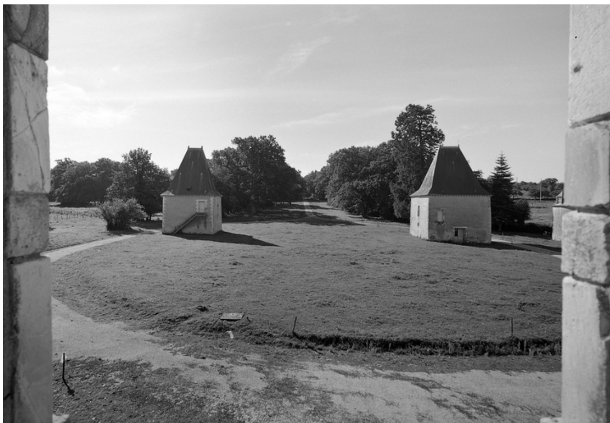
Vue de situation axe, nord-sud.
